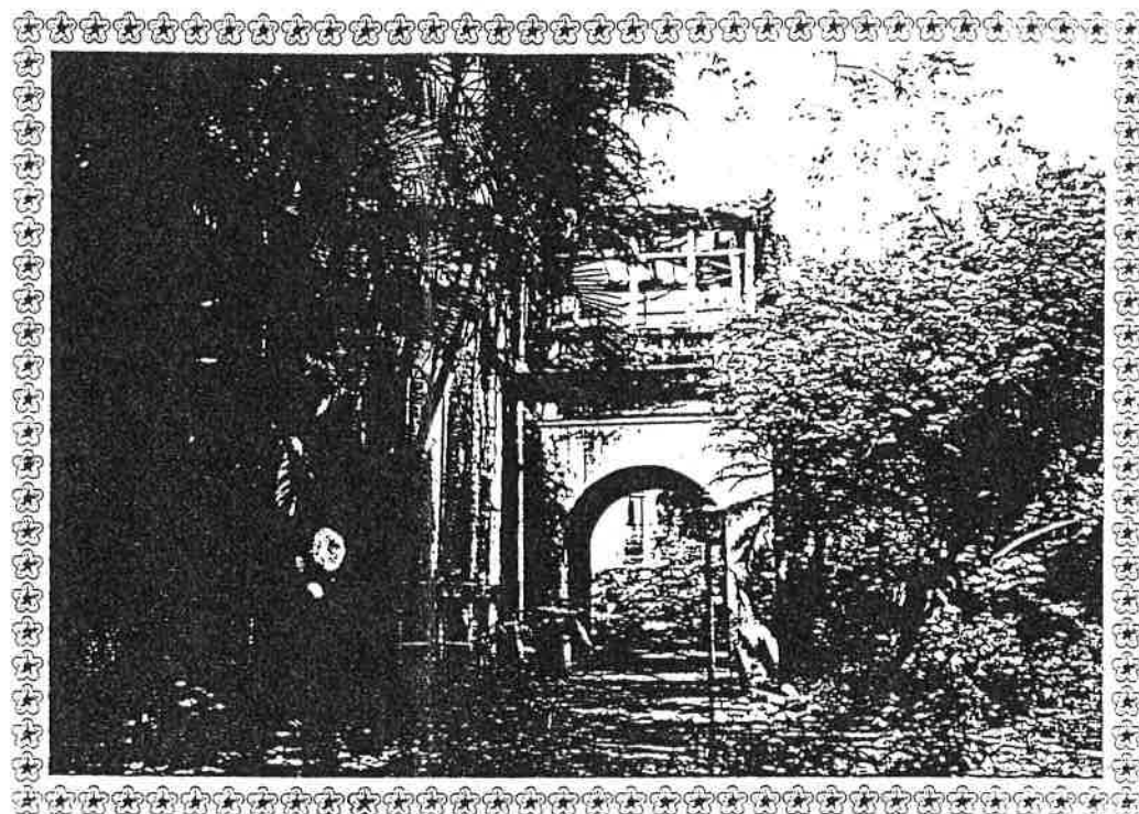
圖片說明：一樓拱形門
