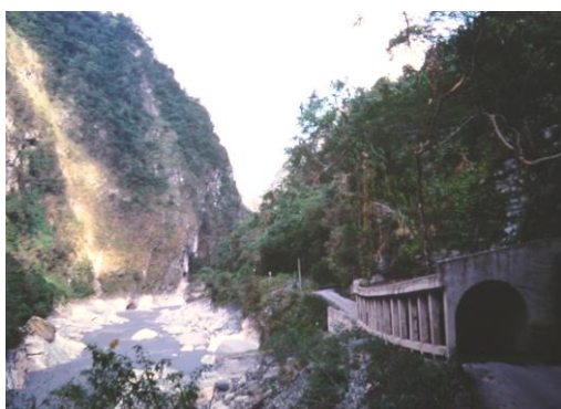
木瓜溪溪谷及道路混凝土護廊
