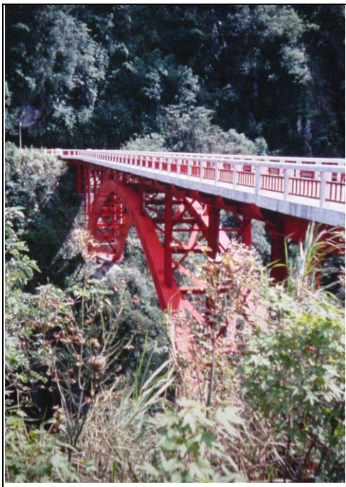
台電龍澗發電廠鐵拱橋
