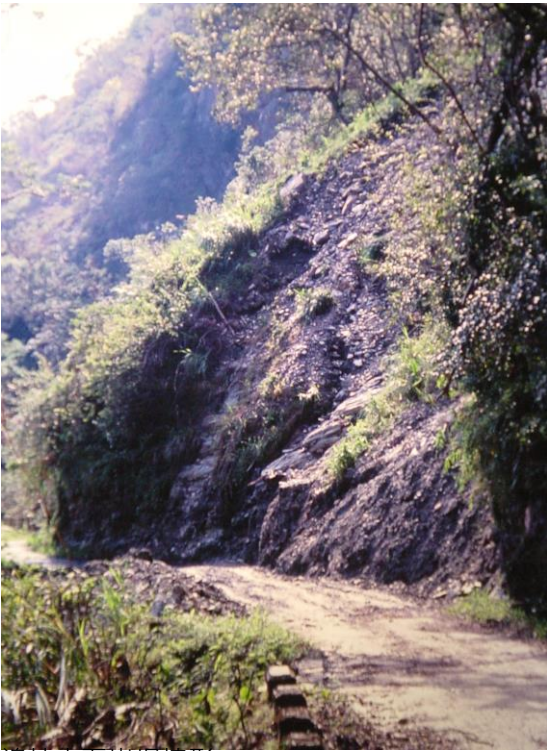
邊坡土石崩塌情形
