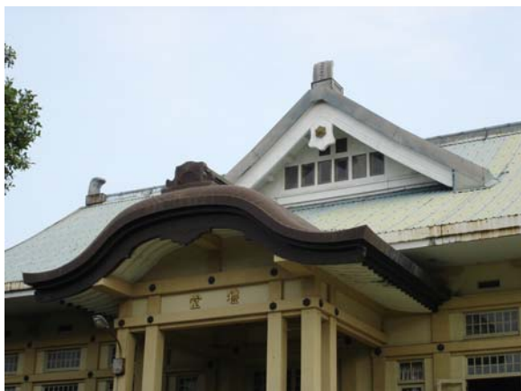
修復前：武德殿入口軒屋面及主屋面鋁鋅鋼鈹。拍攝於 2004 年 9 月
