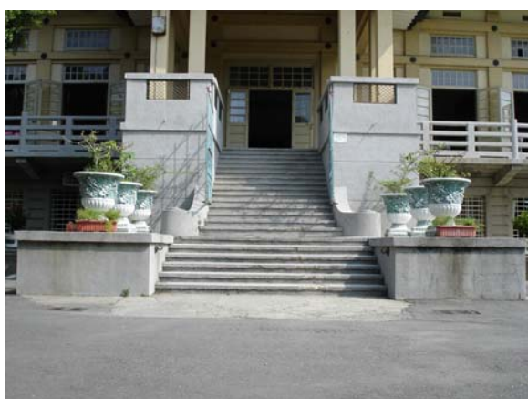
修復前：武德殿南側入口階梯。拍攝於 2004 年 9 月
