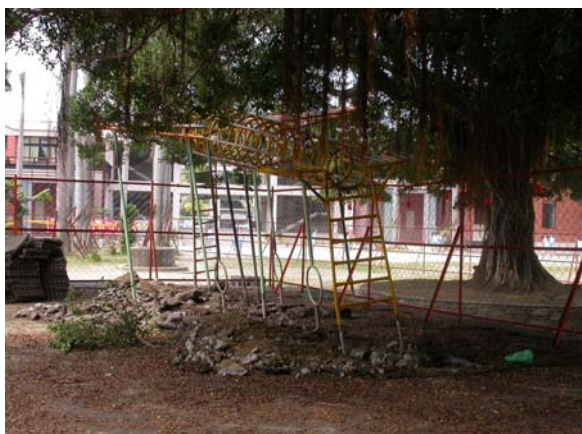
修復前：南側室外遊戲區景觀改善前。拍攝於 2005 年 5 月
