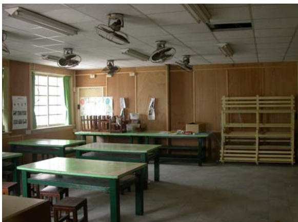
修復前：武德殿一樓教室及附加壁板。拍攝於2005年3月
