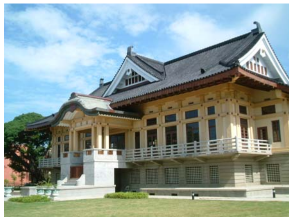
修復後：武德殿東南側外觀。拍攝於 2007 年 8 月
