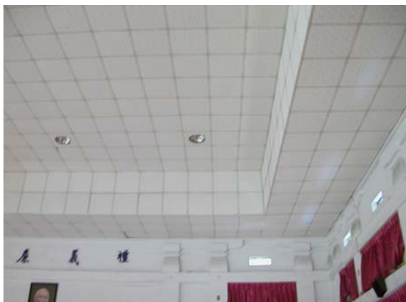
修復前：二樓禮堂輕鋼架礦纖天花板。拍攝於 2004 年 9 月
