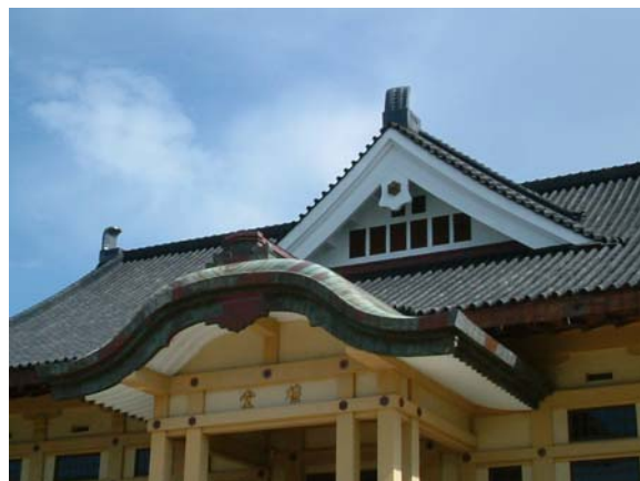
修復後：武德殿入口軒屋面及主屋面黑瓦。拍攝於 2007 年 8 月
