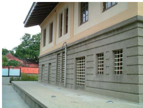
修復後：武德殿北側犬走及立面恢復景象。拍攝於 2007 年 8 月
