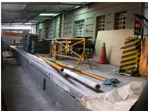
修復前：武德殿北側犬走及鐵皮加蓋空間。拍攝於 2005 年 3 月
