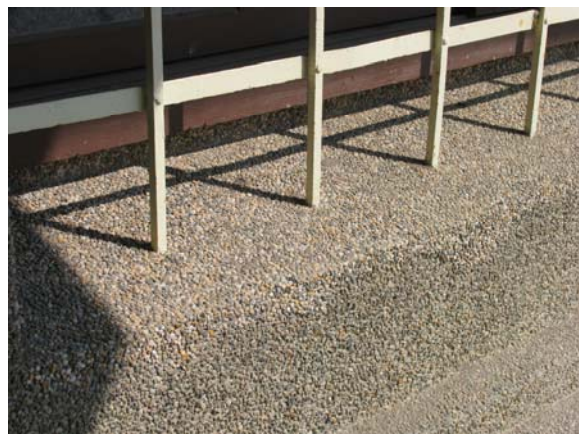
修復後：武德殿一樓室外窗台洗石子。拍攝於 2008 年 2 月
