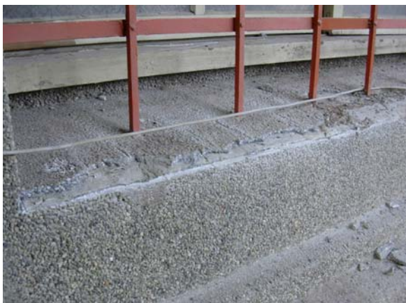
修復前：武德殿一樓室外窗台洗石子。拍攝於 2006 年 11 月
