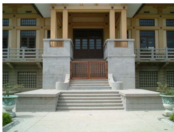
修復後：武德殿南側入口階梯及新作木門。拍攝於 2007 年 8 月
