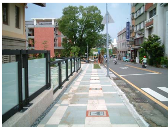
修復後：武德殿北側人行道。拍攝於 2007 年 8 月
