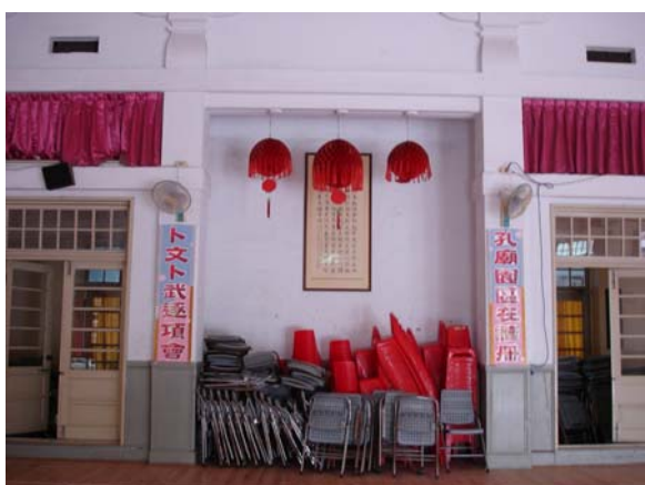
修復前：武德殿二樓北側原有神龕位置。拍攝於2004年9月
