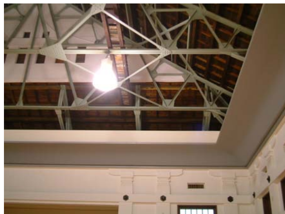
修復後：二樓禮堂天花板開設大片開口，可見原有鋼屋架。拍攝於 2007 年 8 月
