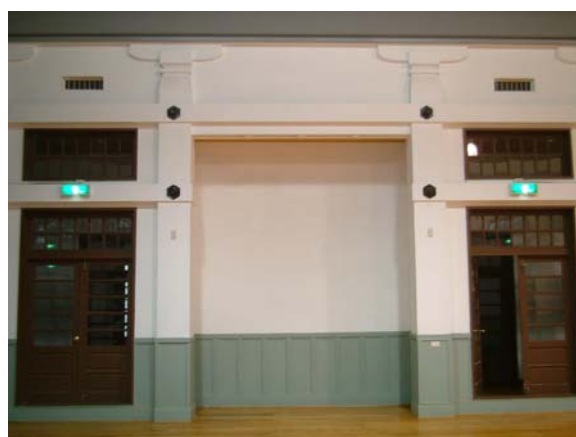
修復後：武德殿二樓北側原有神龕位置。拍攝於2007年8月
