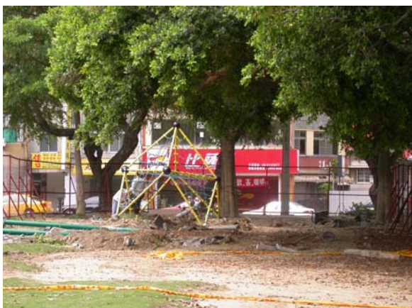
修復前：南端操場西側空間景觀改善前。拍攝於2005年5月
