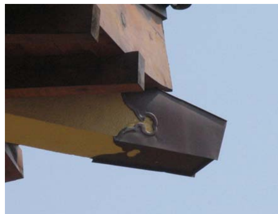
修復後：武德殿木椽天花出簷角樑。拍攝於 2008 年 2 月
