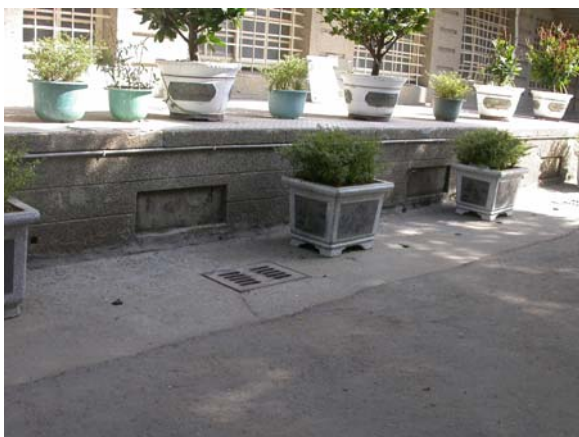
修復前：武德殿西南側犬走及原有之封閉通氣口。拍攝於 2005 年 2 月
