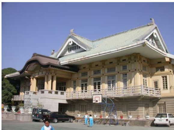
修復前：武德殿東南側外觀。拍攝於 2005 年 2 月
