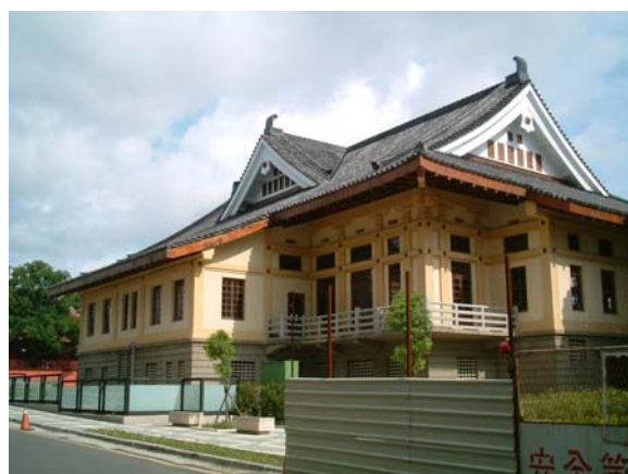
修復後：武德殿西北側外觀。拍攝於 2007 年 8 月
