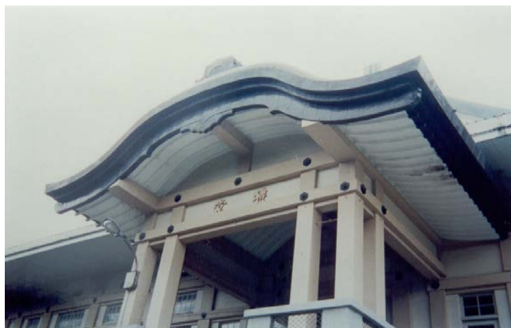
入口軒鋼筋混凝土柱樑仿木構件
