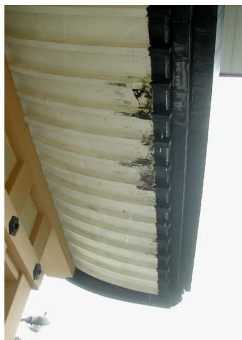
入口唐破風軒之椽出檐現況
