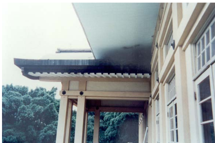
入口軒鋼筋混凝土柱樑仿木構件
