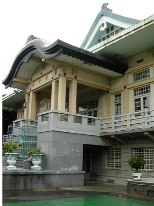
南向立面現況
