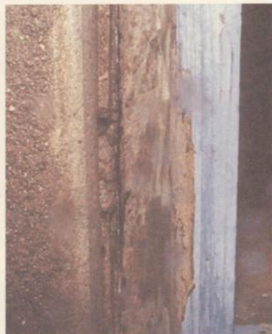
水侵入木框使局部混凝土劣化
