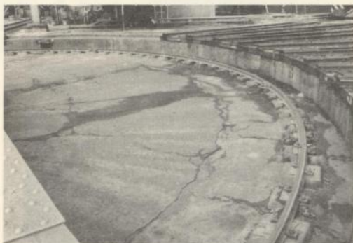
圖 4-15 轉車台環狀軌道 PC 基座損壞狀況
