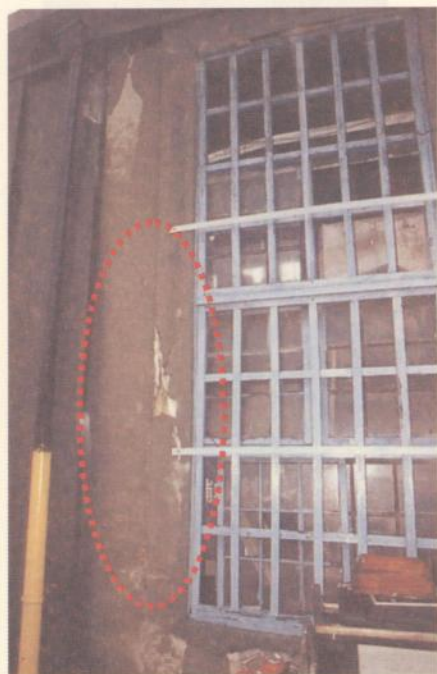
牆體因地震力發生剪力裂紋
