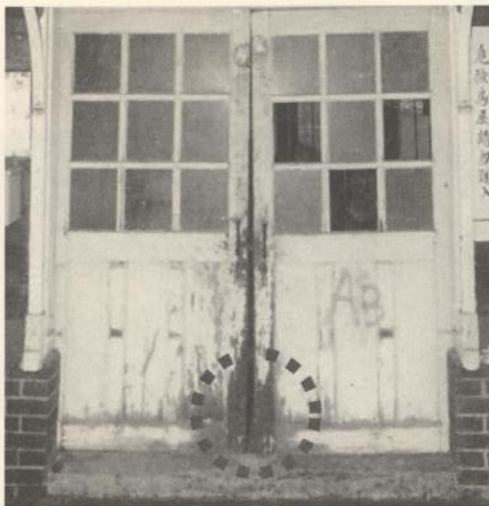
圖 4-50 門版受潮腐朽脫漆
