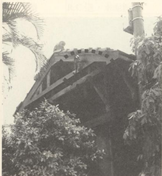
圖 4-54 庫房簷板設置電線礙子
