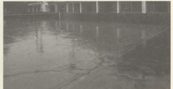
圖 4-44 車庫東側球場有龜裂痕跡
