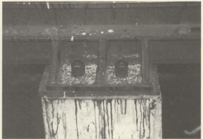
圖 4-58 髒污的鑄鐵軌道夾具與 PC 基座
