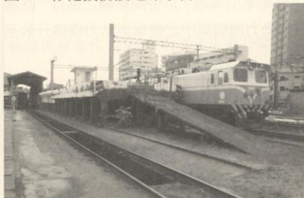
圖 3-1 彰化機務段之煤水台
