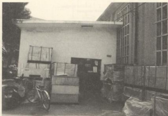
圖 4-18 於扇形車庫外圍增建儲料庫房
