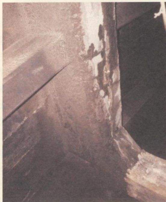
檢修股道上方屋頂煙燻嚴重
