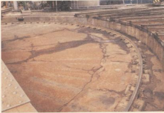
轉車台環狀軌道 PC 基座損壞狀況
