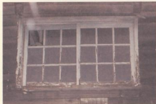
庫房木窗檯受潮腐朽
