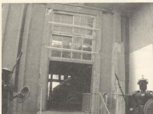
圖 4-7 人員出入口側邊牆體粉刷層剝落
