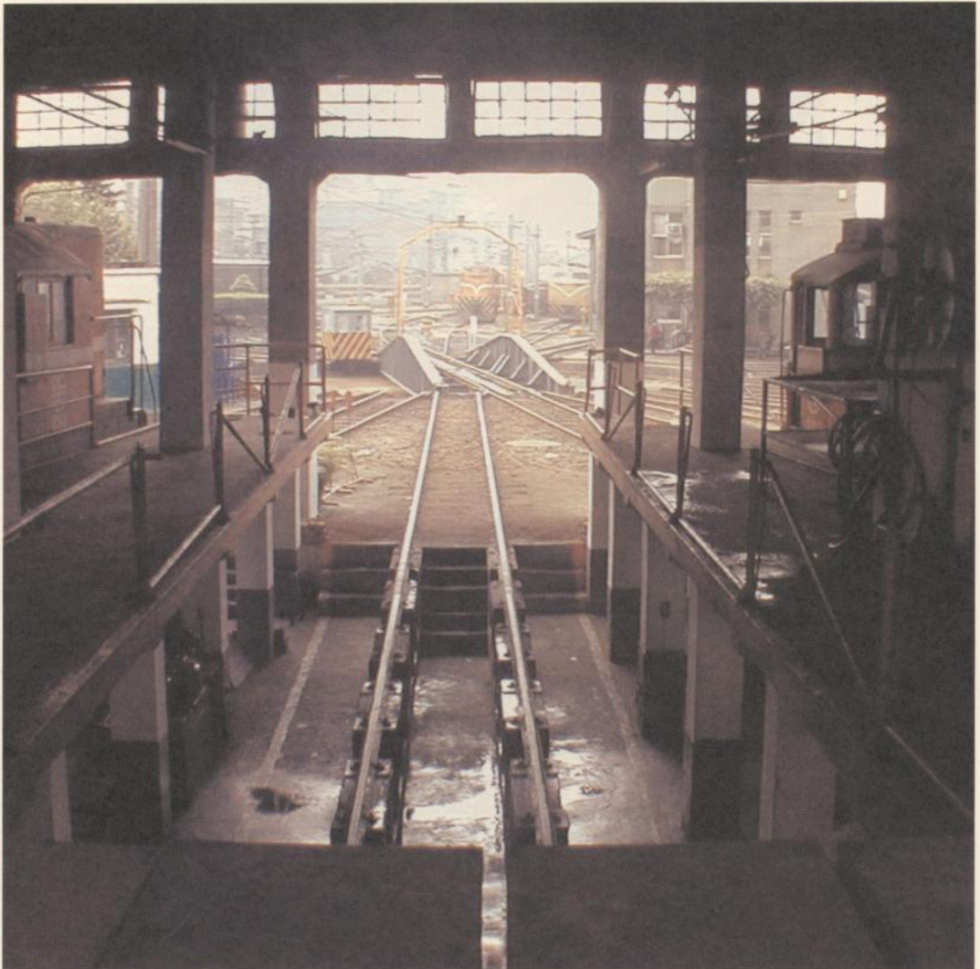
增建之半陷地式維修平台
