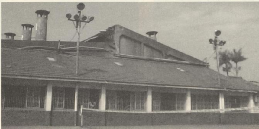
圖 4-37 機械工場屋面改裝前
