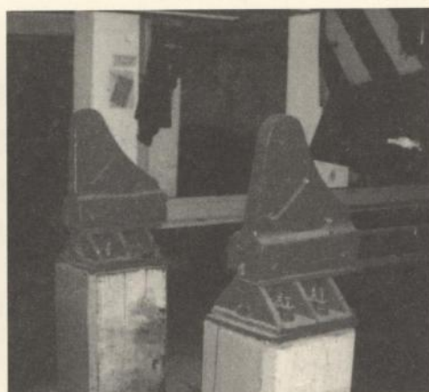
圖 3-49 使用外加式的止衝檔
