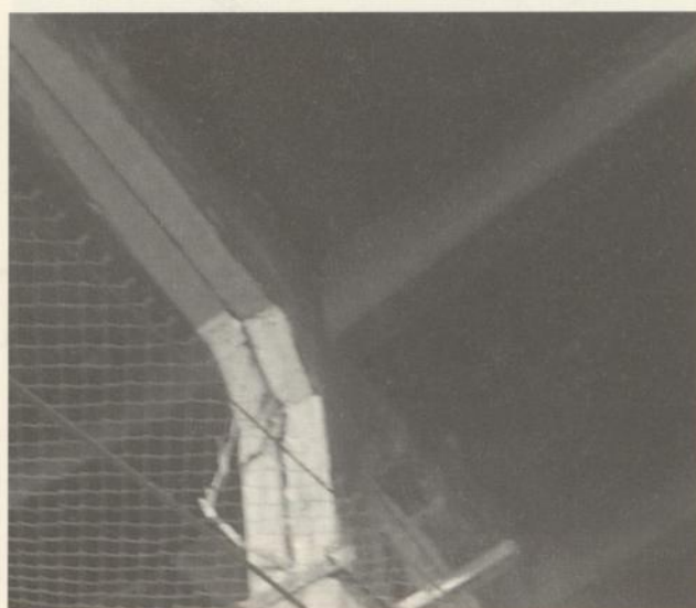
圖 4-26 前後次施工接縫處破壞情形
