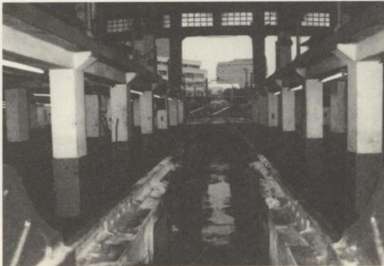
圖 4-40 維修平台之地坪油污嚴重
