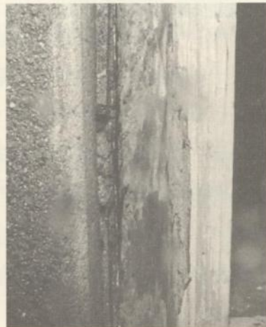
圖 4-2 水侵入木框使局部混凝土劣化
