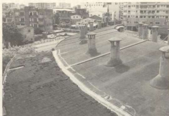
圖 3-20 屋面為 RC 造頂版，表面猶有施工接縫處痕跡
