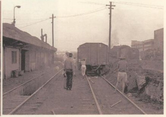
60年代二水機務分段卸煤灰情形
