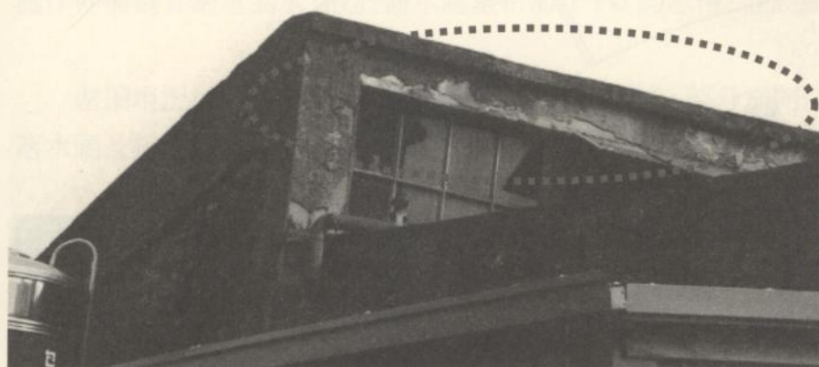
圖 4-29 十二股道上方窗楣水泥噴漿面層剝落現況
