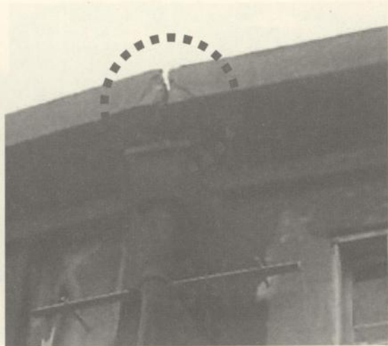
圖 4-33 落水頭為施工接縫處有破損現象
