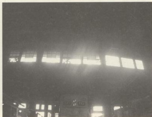
圖 3-23 屋面運用前後坡分水線設置橫帶採光天窗
