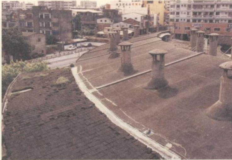
屋面為 RC 造頂版，表面猶有施作接縫處痕跡
