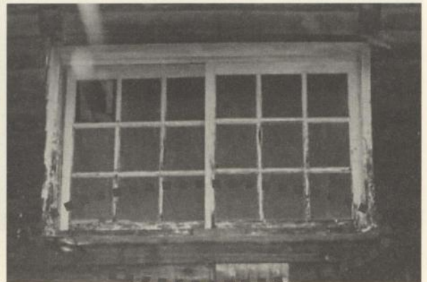
圖 4-51 窗檯受潮腐朽脫漆
