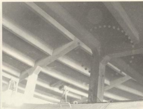
圖 3-21 主要結構為 RC 造樑柱系統 樑柱交點有斜向補強
