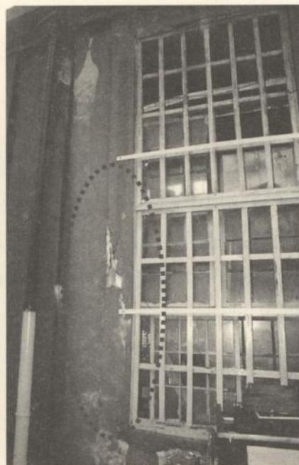
圖 4-4 牆體因地震力發生剪力裂紋
