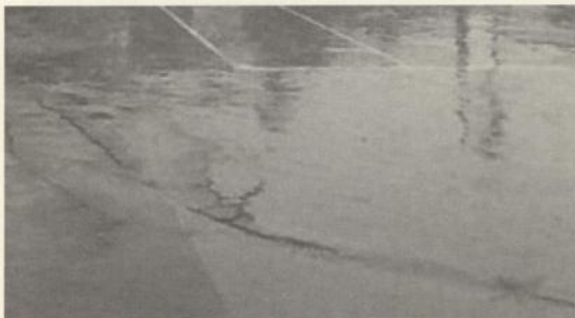
圖 4-43 車庫東側球場有龜裂痕跡
