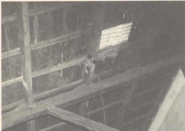
圖 4-34 機械工場屋面有滲水現象發生
