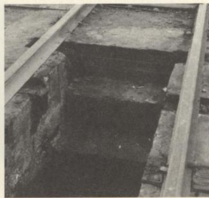
圖 4-41 維修平台之地坪油污嚴重
