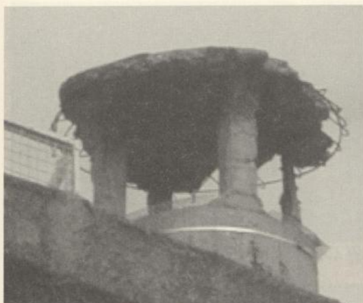
圖 4-5 煙囪因混凝土劣化剝落
