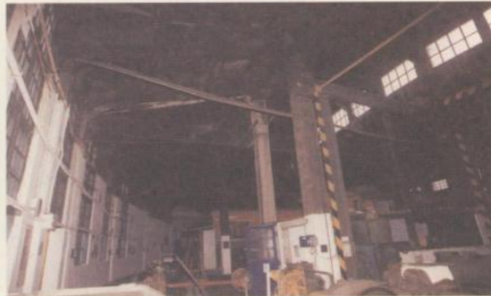
車庫上方屋頂煙燻嚴重
