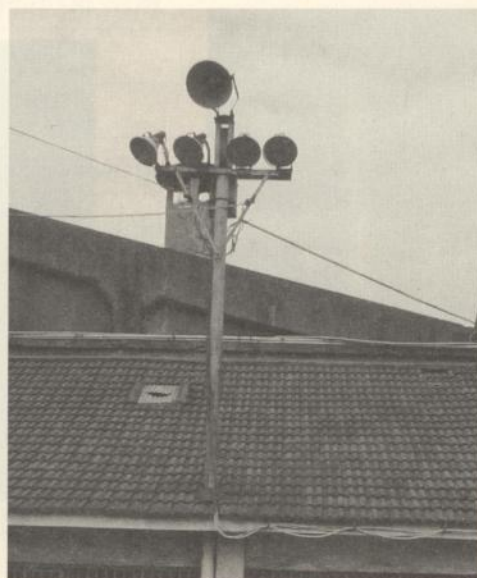
圖 4-55 球場照明燈桿設於工場屋面內
