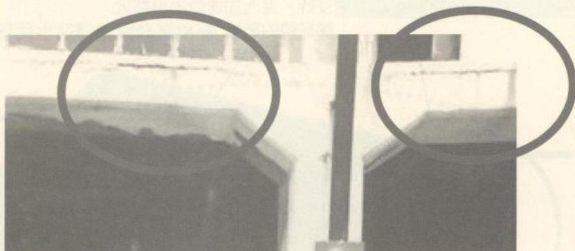
圖 4-25 開口上部橫向裂紋現況
