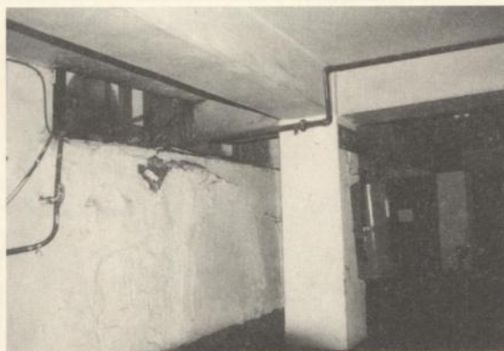
圖 4-8 車庫底層室內牆體粉刷層受潮浮突
