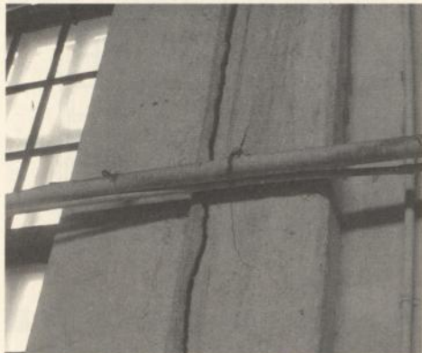
圖 3-30 立面柱間之結構體接縫處
