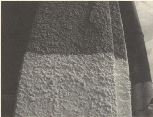
圖 3-28 室外牆面以水泥噴漿處理
