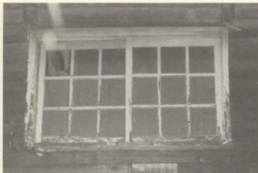
圖 4-10 庫房木窗檯受潮腐朽
