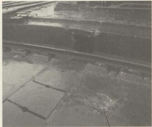
圖 4-46 轉車台因重物重擊破損
