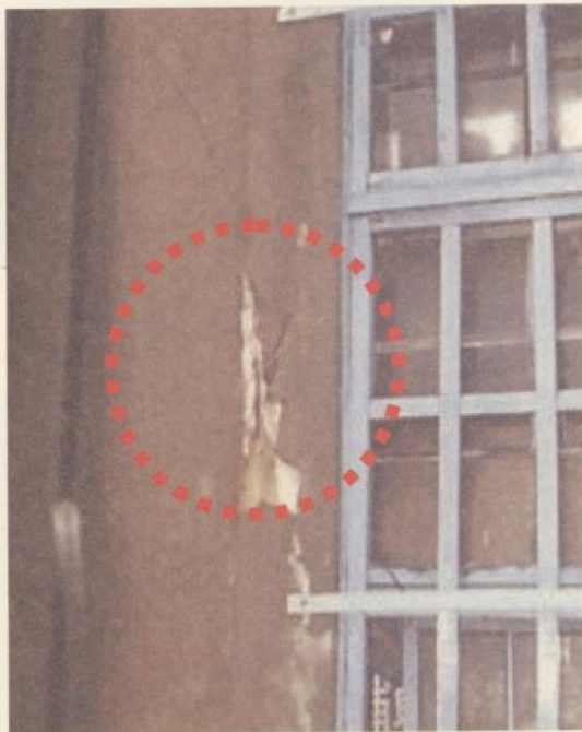
震後外側之柱牆有 X 型裂縫
