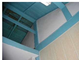
(1) 原台南運河海關西側次量體屋架單元為跨度四架之和小屋組（設有貫木與縱向貫木連接小屋束以及屋架單元）
