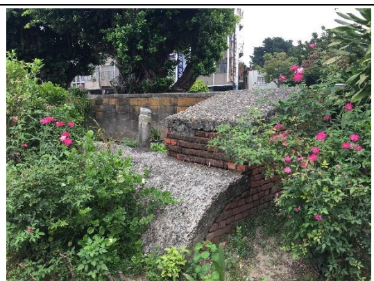
【圖 4-1.52】通氣孔現況
