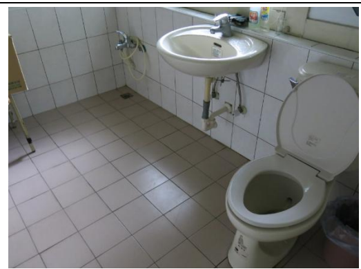
【相 5-3.8】女廁地坪貼磚情形
