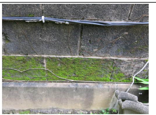
【相 5-1.18】北側圍牆有青苔附生情形
