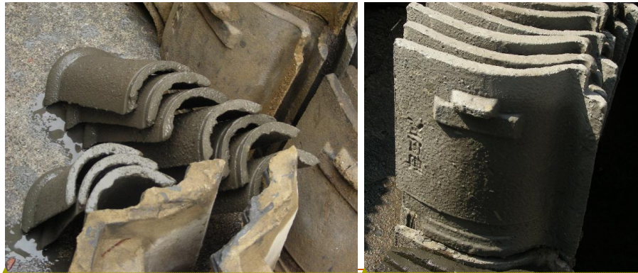
【圖 8-2.1】【圖 7-3.1】日式建築舊瓦重鋪與新瓦集中鋪設
