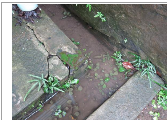
【相 5-1.9】基地西北側排水溝有積水情形
