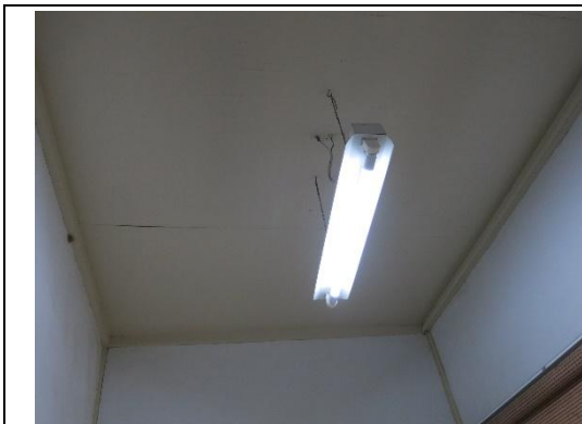
【相 5-6.5】廁所區域之天花板為木板
