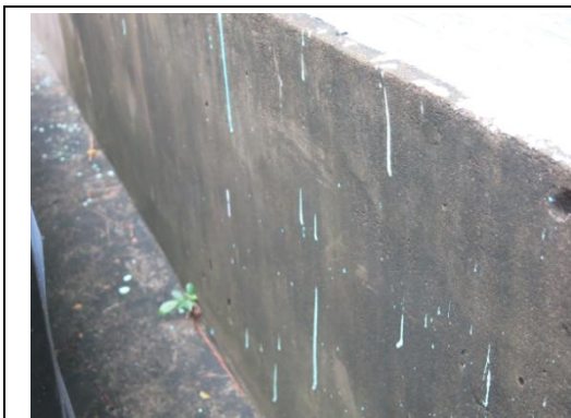
【相 5-2.11】室外布基礎有防水油漆滴落
