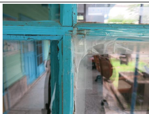
【相 5-7.6】押條掉落修補情形
