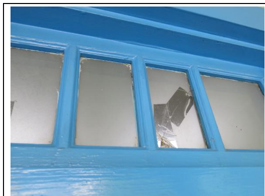
【相 5-7.5】玻璃裂修補情形
