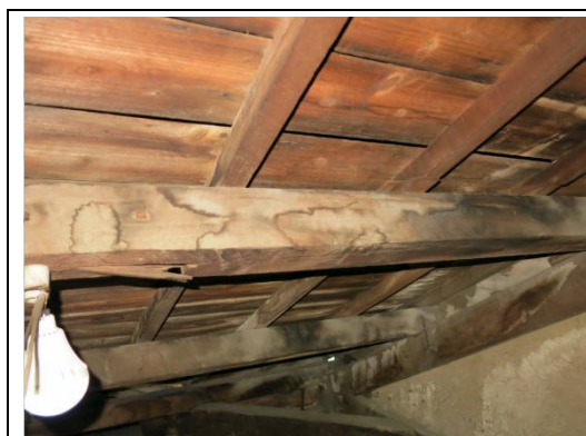
【相 5-5.3】桁木受潮、開裂情形
