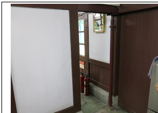
【相 5-4.15】軸組開脫處緊急支撐情形
