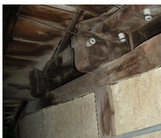
(2) 原台南運河海關西側次量體屋架單元與主量體連接處之縱向貫木中斷
