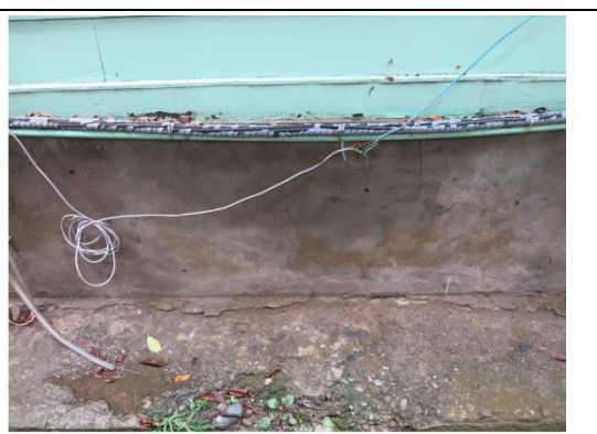
【相 5-2.2】北側布基礎有嚴重受潮情形
