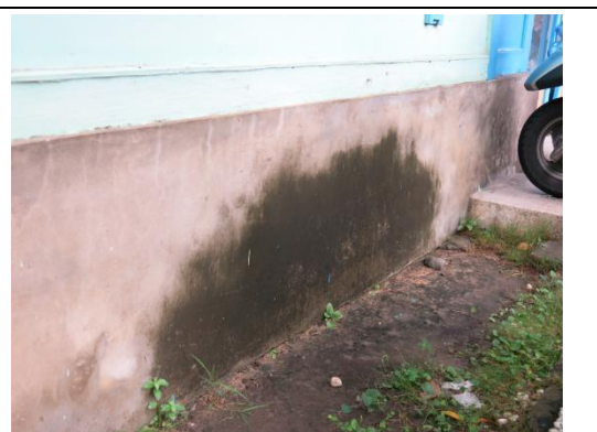
【相 5-2.4】東側布基礎有嚴重水漬及青苔附生
