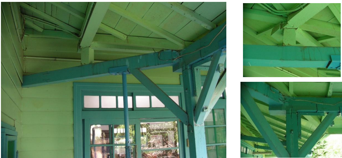
(3) 原台南運河海關簷廊轉折處之屋架構造
