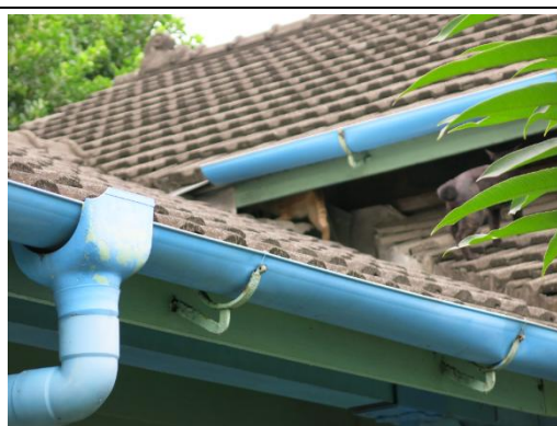
【相 5-5.18】屋面板破損處有動物進出
