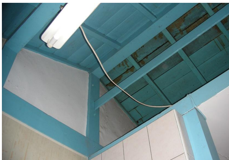
(1) 原台南運河海關西側次量體屋架單元為跨度四架之和小屋組（設有貫木與縱向貫木連接小屋束以及屋架單元）
