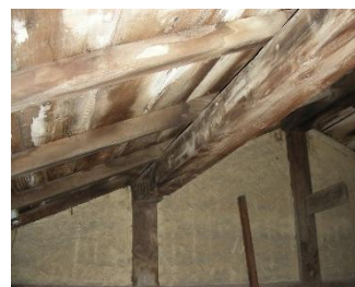
(1) 原台南運河海關西側次量體屋架單元為跨度四架之和小屋組（設有貫木與縱向貫木連接小屋束以及屋架單元）
