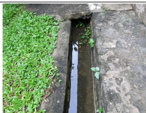
【相 5-1.10】基地西側排水溝有積水情形
