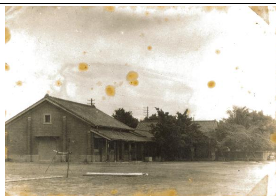
【圖 4-1.19】財政部臺南關稅務司公署臺南支關（辦公廳背面及倉庫）
