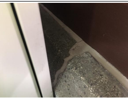
【相 5-2.10】布基礎裂痕修補痕跡
