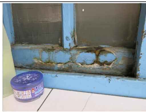
【相 5-7.8】W11 腐朽情形
