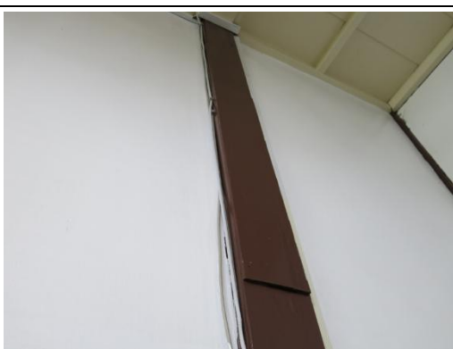
【相 5-4.16】軸組柱修復情形
