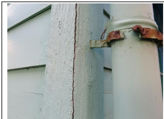
【相 5-4.5】雨淋板轉角收邊木板開脫
