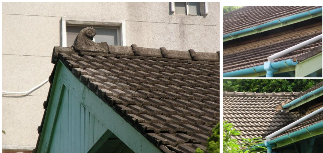
(1) 原台南運河海關屋頂鋪設雙溝水泥瓦
