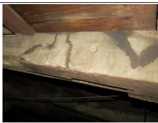
【相 5-5.2】桁木受潮情形
