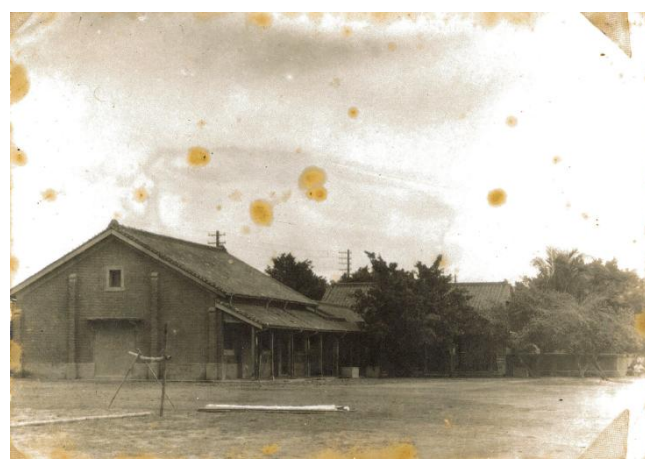
【圖 3-1.62】稅關安平支署及倉庫（港町 230 番地，大正 15 年完工）
