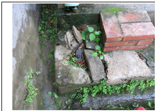
【相 5-2.21】不同時期修補痕跡
