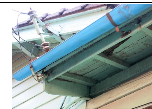
【相 5-5.24】雨庇屋面板有受潮情形
