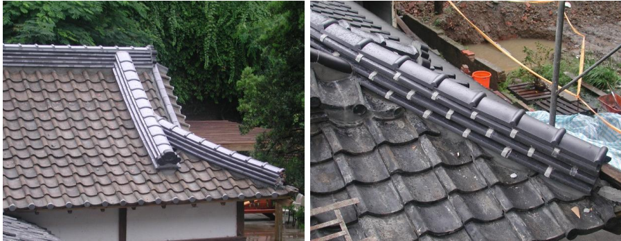
【圖 8-2.1】【圖 7-3.1】日式建築舊瓦重鋪與新瓦集中鋪設
