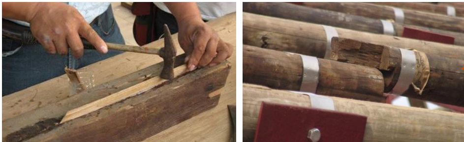
【圖 8-2.5】【圖 7-3.5】木構件包覆鐵片（右）以及縫隙填補同材質木料
