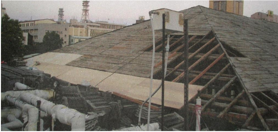
【圖 8-2.2】(圖 7-3.3) 新舊屋面板集中鋪設
