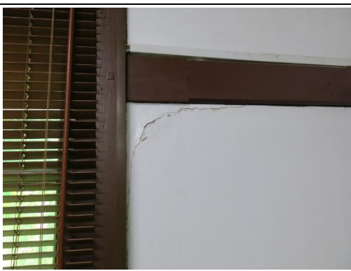
【相 5-4.18】小舞壁端部開裂情形 2
