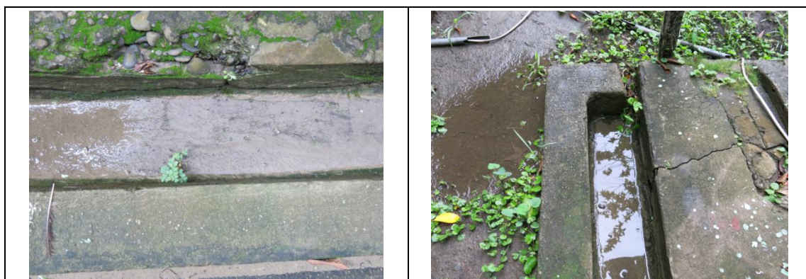
【相 5-1.7】基地北側之排水溝有泥沙淤積情形
