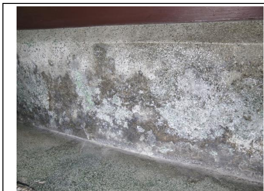
【相 5-2.3】室內布基礎有嚴重受潮及白華情形
