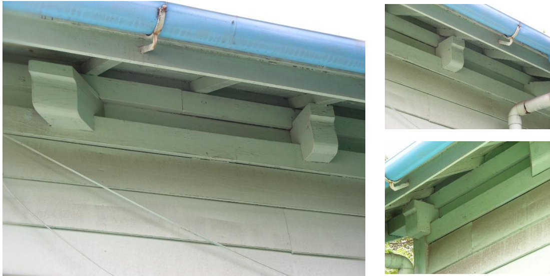
(2) 原台南運河海關主量體屋架水平大樑外端突出牆面處做成曲面造型
