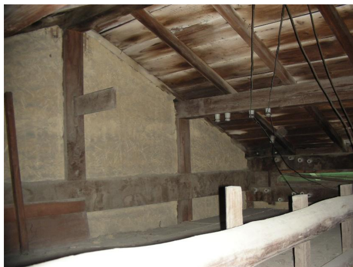
(2) 原台南運河海關西側次量體屋架單元與主量體連接處之縱向貫木中斷
