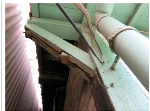
【相 5-5.9】斜撐腐朽開裂情形
