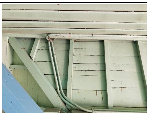
【相 5-5.20】走廊屋面板腐朽情形
