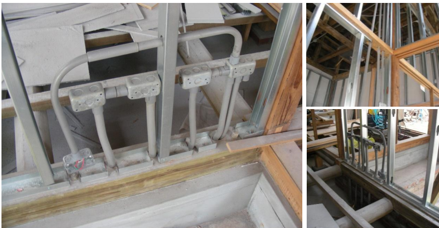
(3) 埋入矽酸鈣板牆體之電氣管線
