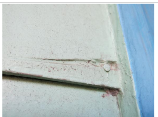
【相 5-4.2】雨淋板破裂
