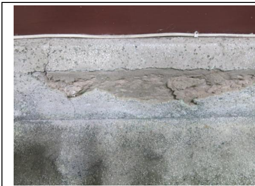
【相 5-2.7】室內布基礎磨石子表面剝落
