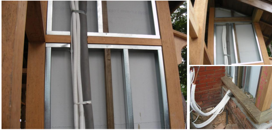
(1) 廁所牆體集中埋入之空調水管
