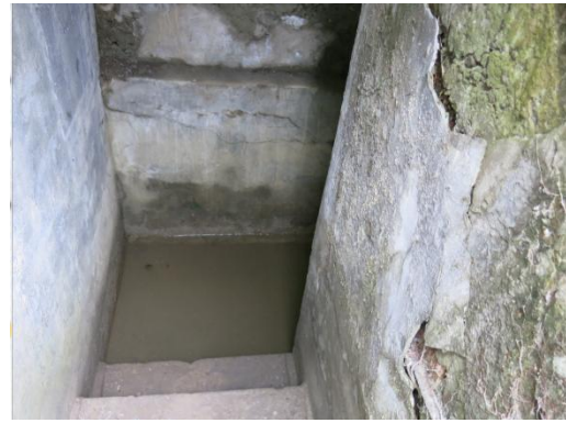
【相 5-8.2】防空洞內部積水情形
