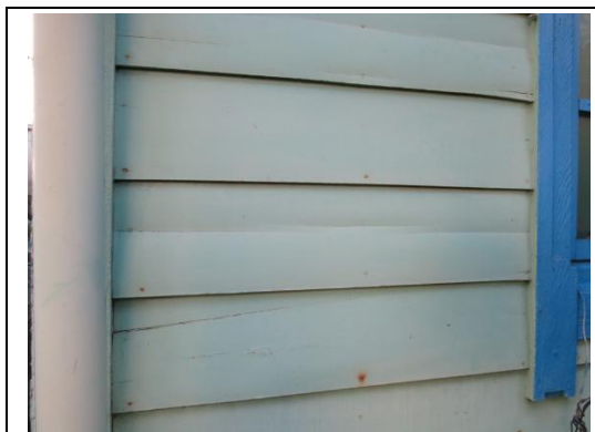
【相 5-4.1】雨淋板開裂情形
