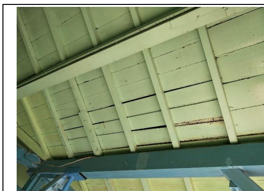
【相 5-5.19】走廊屋面板腐朽情形
