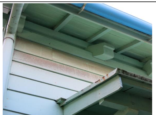
【相 5-4.6】壁體頂端雨淋板有沙塵
