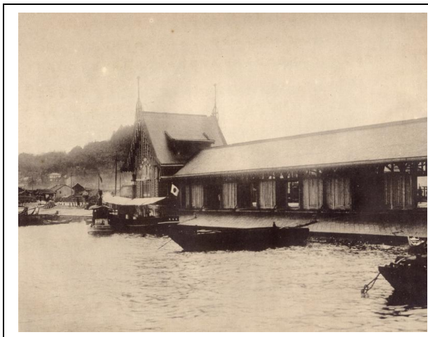
【圖 3-1.53】基隆新店街候船室（1911 年 2 月竣工） （資料來源：國家文化資料庫）
