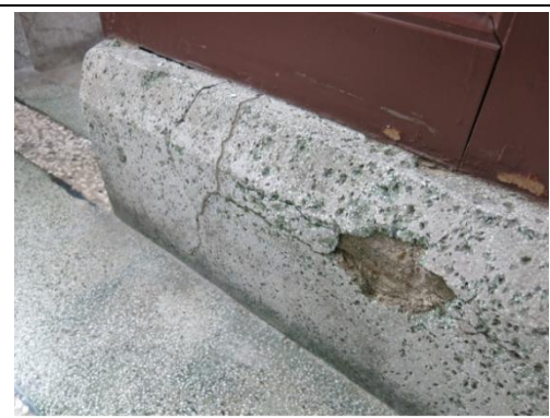
【相 5-2.8】室內布基礎有垂直與水平裂痕
