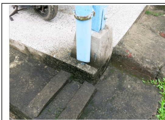
【相 5-3.9】室外走廊地坪受潮情形
