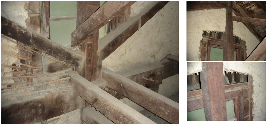
(1) 原台南運河海關主量體山牆部位之屋架填有編竹夾泥構造並預留開口設置採光窗
