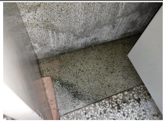
【相 5-3.2】地坪積水情形 2
