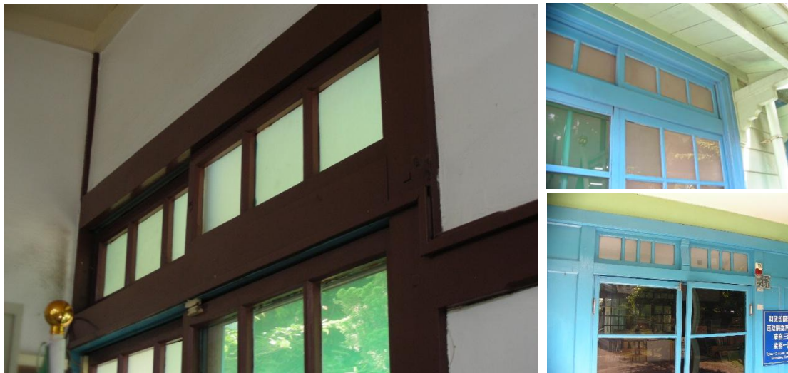
(1) 原台南運河海關門窗現況
