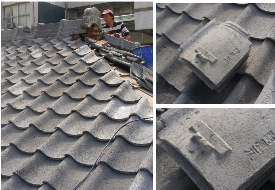
【圖 7-3.2】日式建築舊瓦表面塗覆水泥砂漿
