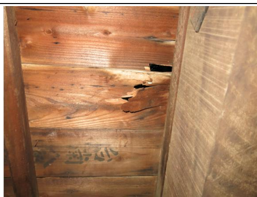
【相 5-5.16】屋面板破損情形
