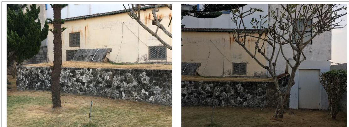
【圖 4-1.17】財政部關務署高雄關馬公辦公室防空洞，採一字型平面，無防爆牆，避難室上方有掩土。
