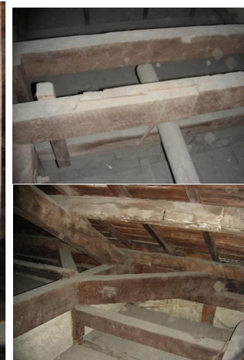
(3) 原台南運河海關主量體屋架面外穩定構件包含剪刀撐、水平夾撐與火打樑（水平夾撐以犁壁樺接續）
