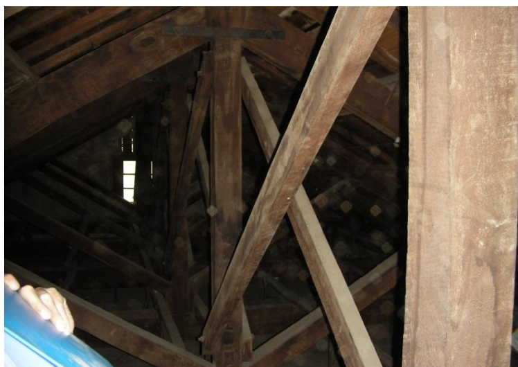
(3) 原台南運河海關主量體屋架面外穩定構件包含剪刀撐、水平夾撐與火打樑（水平夾撐以犁壁樺接續）
