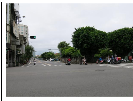
【相 5-1.1】基地東側環河街現況
