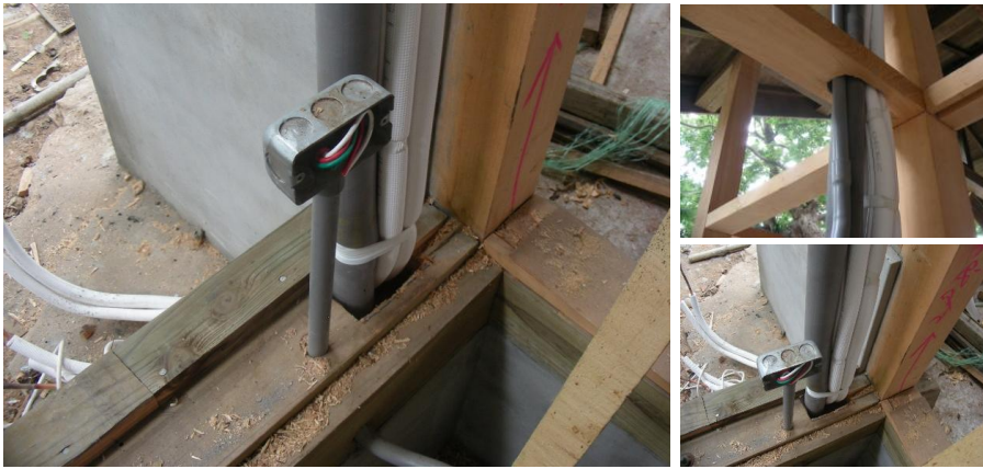
(2) 管線穿越軸組構件處須裁製成圓孔以避免應力集中
