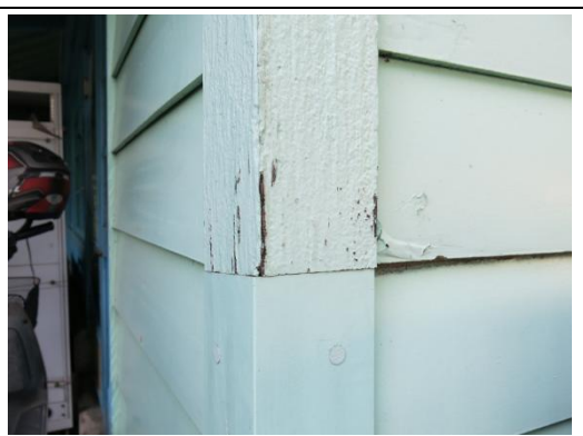
【相 5-4.4】雨淋板轉角收邊木板修復情形
