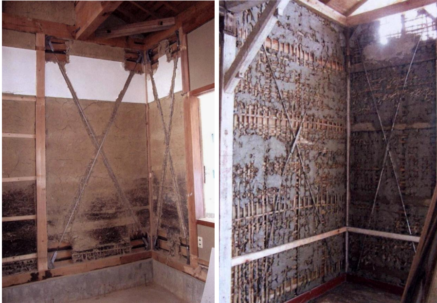
左：日本案例（圖片來源：《木造耐震工法》，101年4月，株式會社エクスナレッジ）/右：嘉義縣歷史建築央廣民雄分台日式招待所，（圖片來源：《九二一震災重建區歷史建築修復結構補強技術研究》，96年8月，財團法人成大研究發展基金會）
