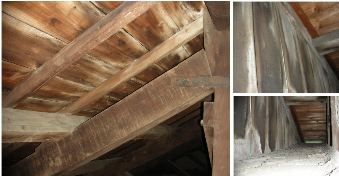
(2) 原台南運河海關主量體屋面內側樣貌
