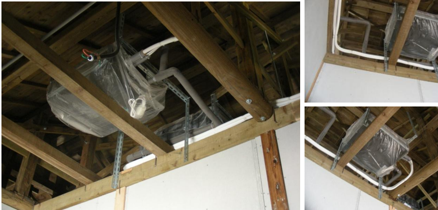
(1) 增設之空調機箱以適當形式之鐵件固定或吊掛於屋架、牆體等主要承重構件
