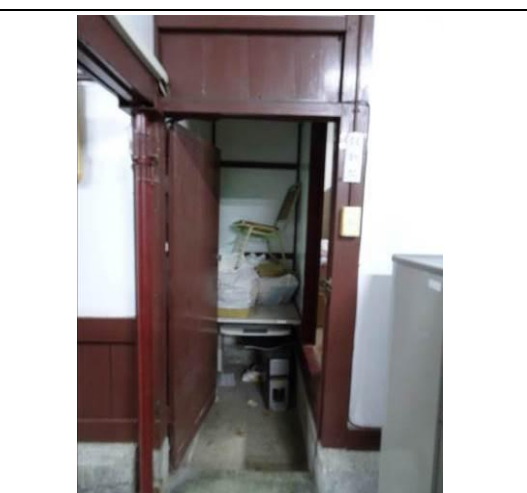
【圖 4-1.41】電話室空間拆除閒置
