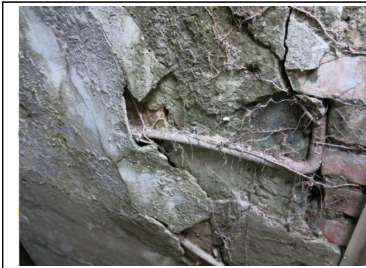
【相 5-8.3】壁體植物附生撐破水泥砂漿
