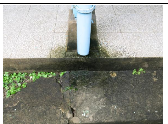
【相 5-3.10】室外走廊地坪青苔附生情形
