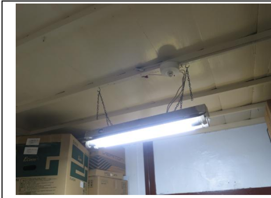
【相 5-6.1】天花板竿緣掛有電器設備
