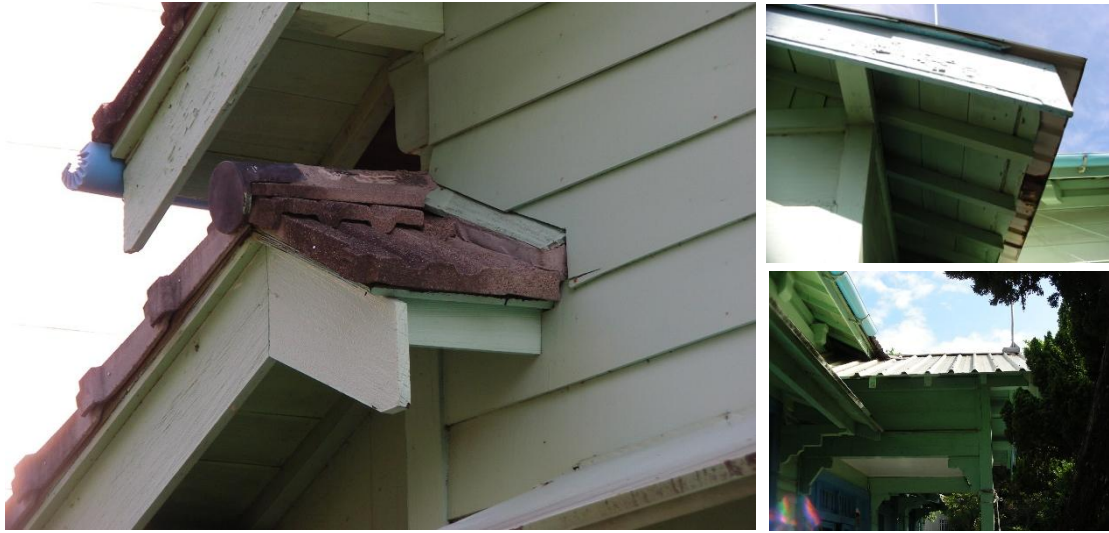
(1) 原台南運河海關簷廊端部與入口量體屋面構造
