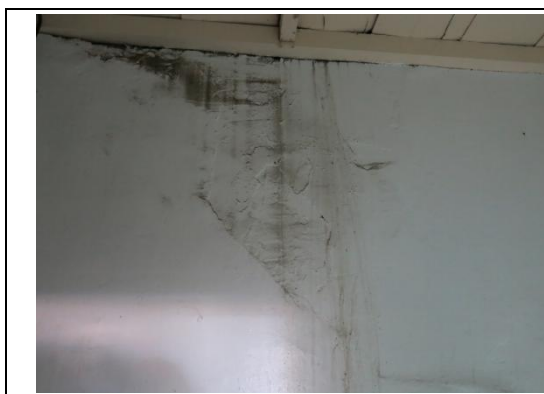
【相 5-4.21】泥水沖刷痕跡
