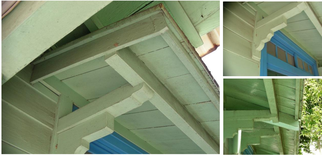
(1) 原台南運河海關雨庇細部做法以托架支撐桁條後鋪設屋面板
