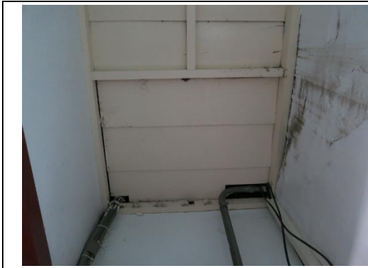
【相 5-6.3】天花板有開孔供電線管路經過
