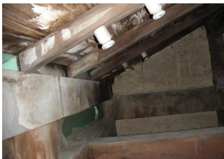
(3) 原台南運河海關西側次量體屋架單元與牆體之連結構造
