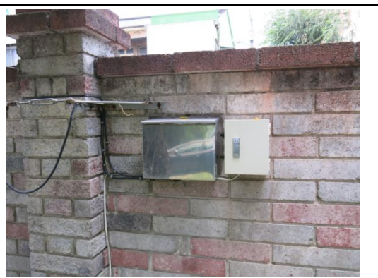
【相 5-1.16】東側圍牆內側掛有電箱
