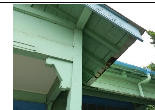
【相 5-5.26】入口雨庇封檐板佚失
