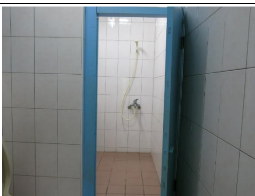
【相 5-4.24】浴廁壁體面貼磁磚
