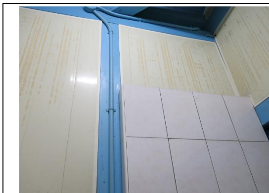
【相 5-4.23】男廁壁體頂部封有 PVC 板
