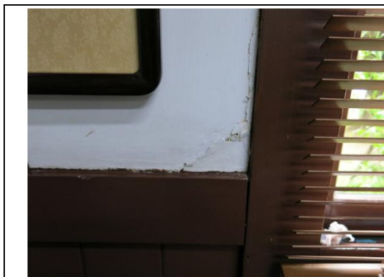
【相 5-4.19】小舞壁端部開裂情形 3
