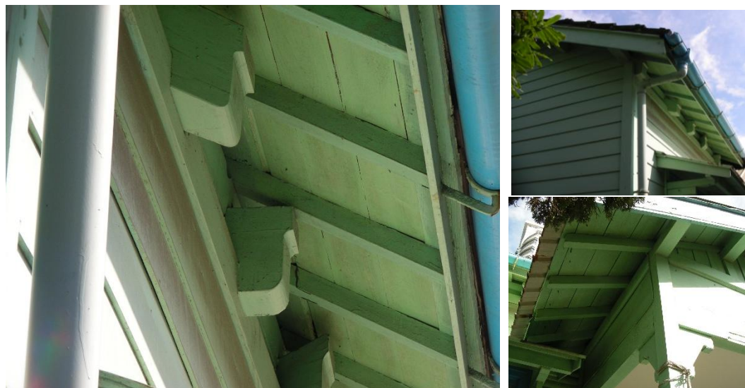
(2) 原台南運河海關簷口部位屋面未設置簷口天花
