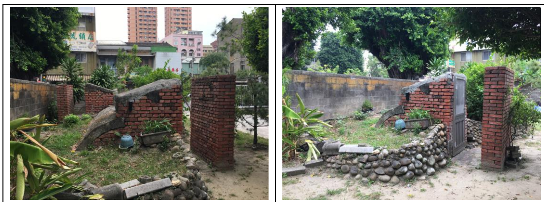
【圖 4-1.48】防空洞現況，採半地下式作法。
