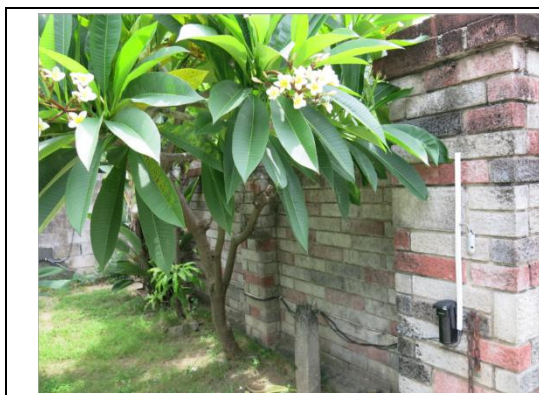
【相 5-1.17】東側圍牆內側有植物緊鄰情形
