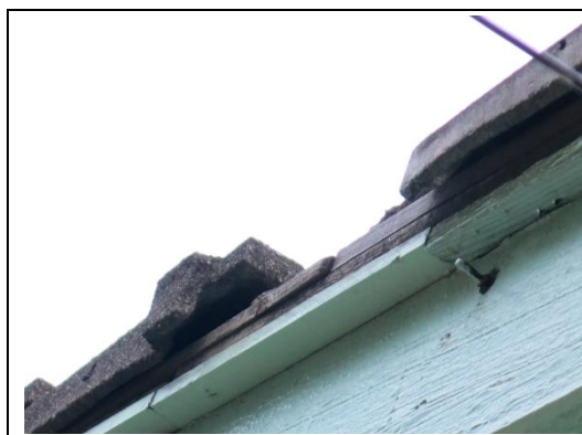
【相 5-5.11】邊瓦破損情形
