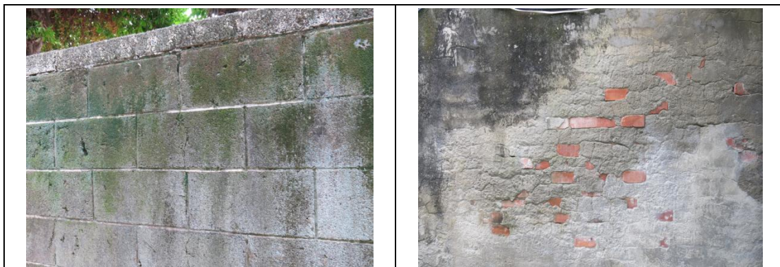
【相 5-1.19】北側空心磚圍牆多處有垂直裂縫
