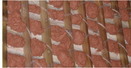
【圖 8-2.10】【圖 7-3.10】竹材防腐（左）與編竹夾泥牆底層泥料塗覆
