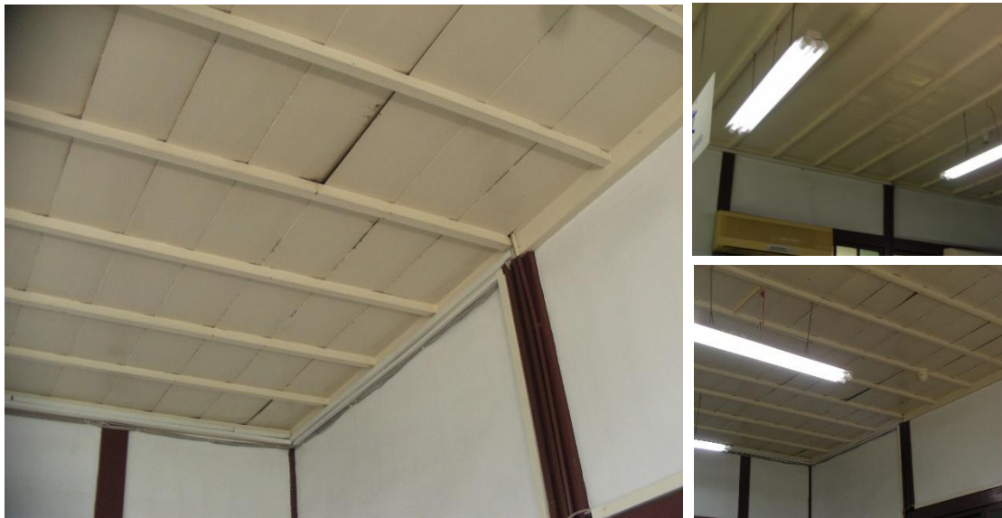
(2) 原台南運河海關天花板採用竿緣天花形式
