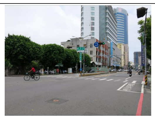
【相 5-1.4】基地北側民生路現況
