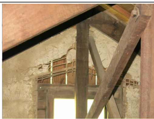
【相 5-4.12】泥土剝落情形
