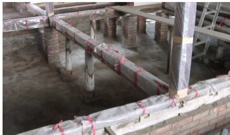
【圖 8-2.11】【圖 7-3.11】泥料乾縮木框出現縫隙 木節點以鐵件補強
