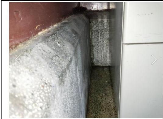
【相 5-3.1】地坪積水情形
