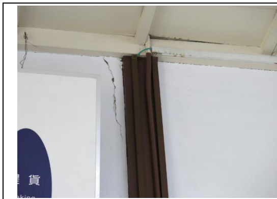
【相 5-4.17】小舞壁端部開裂情形
