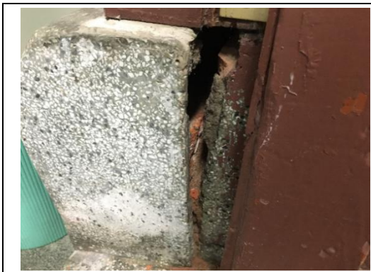
【相 5-2.9】布基礎內側之紅磚明顯斷裂
