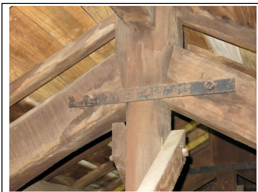
【相 5-5.7】鐵件生鏽情形
