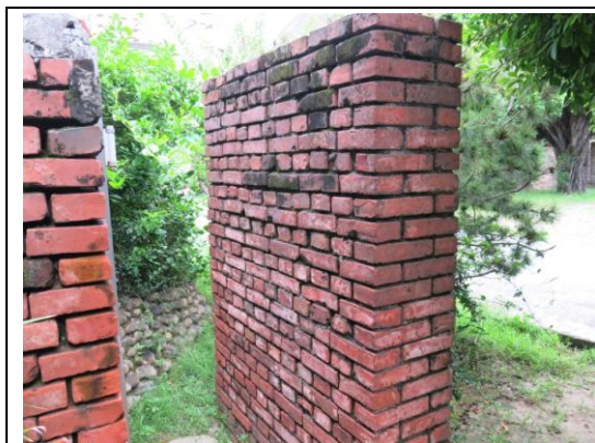
【圖 4-1.51】防爆牆現況
