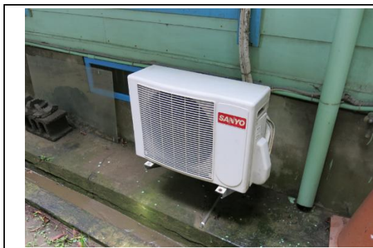
【相 5-2.13】布基礎有加掛冷氣室外機
