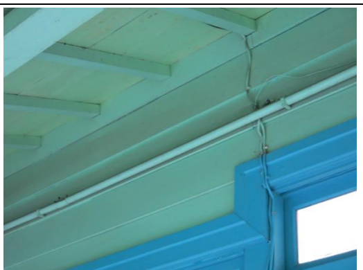
【相 5-4.8】雨淋板釘有管線
