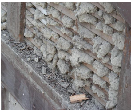
(1) 劉啟祥故居編竹夾泥牆原構法錯誤而形成特色
