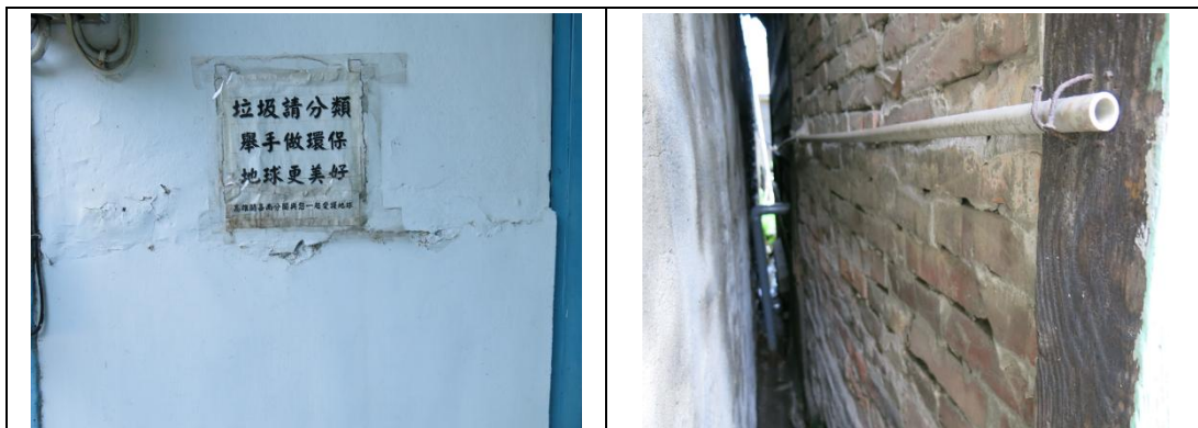
【相 5-4.9】不同時期修建痕跡
