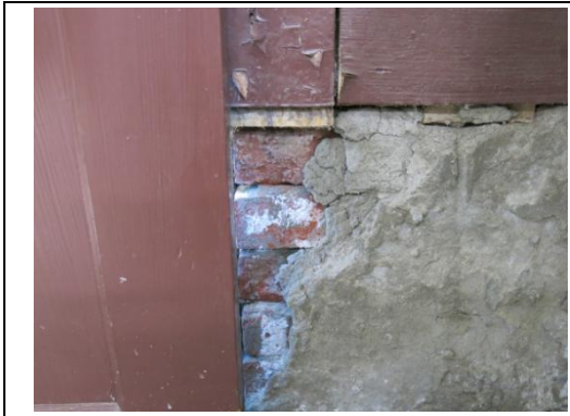
【相 5-2.5】室內布基礎紅磚有嚴重白華吐鹽情形
