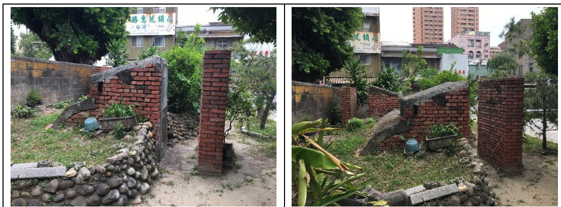
【圖 4-1.15】原台南運河海關之防空洞防爆牆及掩體現況
