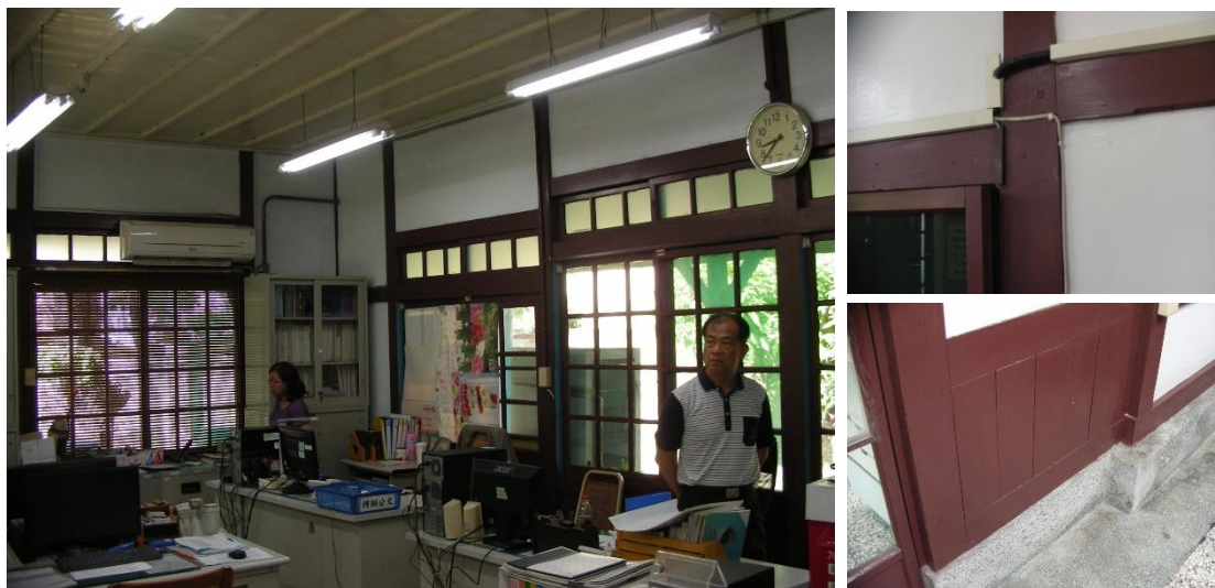
(1) 原台南運河海關牆體以軸組框架內填編竹夾泥構造（臺度部位鋪設垂直板材）
