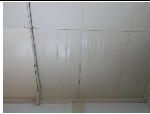
【相 5-6.2】儲藏室天花板有受潮情形
