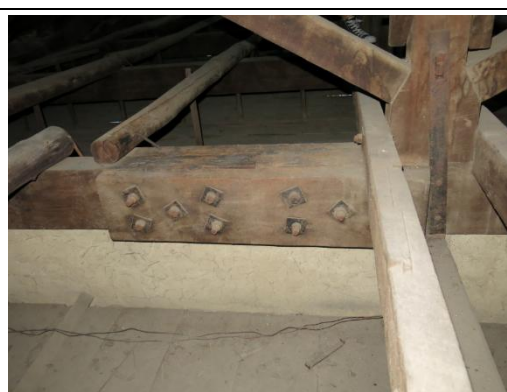
【相 5-5.4】鐵件鬆脫及掉落情形
