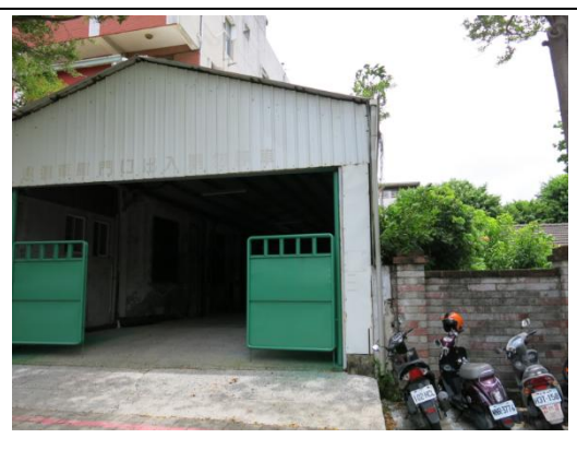
【相 5-1.2】基地西側為海安派出所車庫
