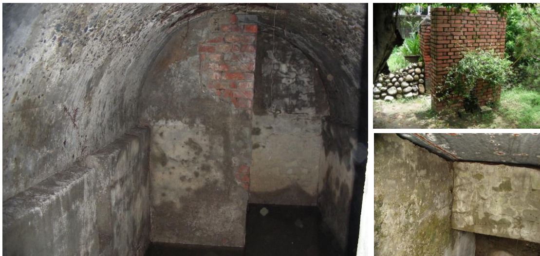
(3) 原台南運河海關防空洞主體構造包含磚牆與鋼筋混凝土圓筒 【圖 4-4.2】原台南運河海關雨庇及其他構造
