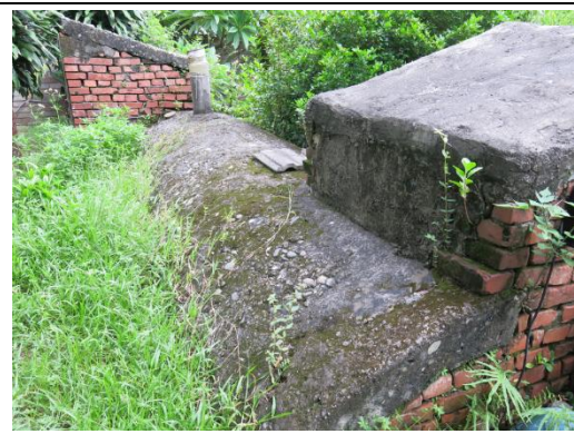
【相 5-8.4】防空洞上方水泥砂漿受潮情形
