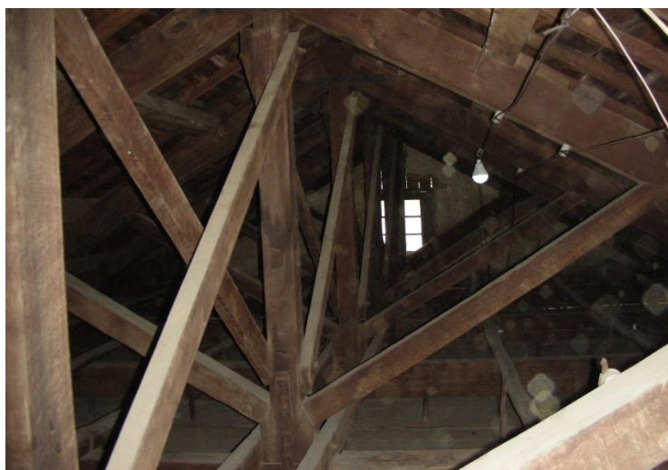
(1) 原台南運河海關主量體屋架單元為正同柱桁架（未設置吊鞍）
