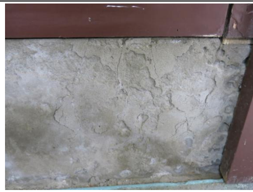
【相 5-2.6】室內布基礎有嚴重粉刷層剝落情形
