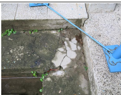
【相 5-2.20】水泥砂漿修補情形
