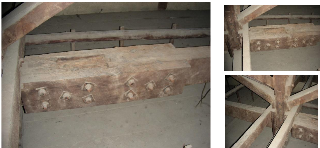
(3) 原台南運河海關主量體屋架水平大樑之添板對接（剪力釘斜向放置）
