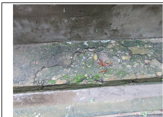
【相 5-2.17】北側犬走表面粉刷層剝落情形
