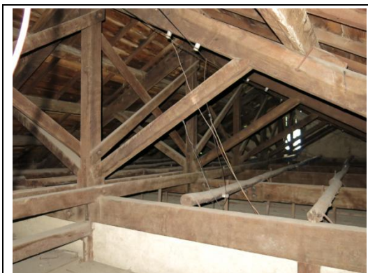
【相 5-5.5】早期電線釘掛情形
