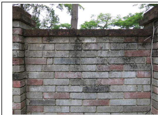
【相 5-1.15】南側圍牆有水漬情形
