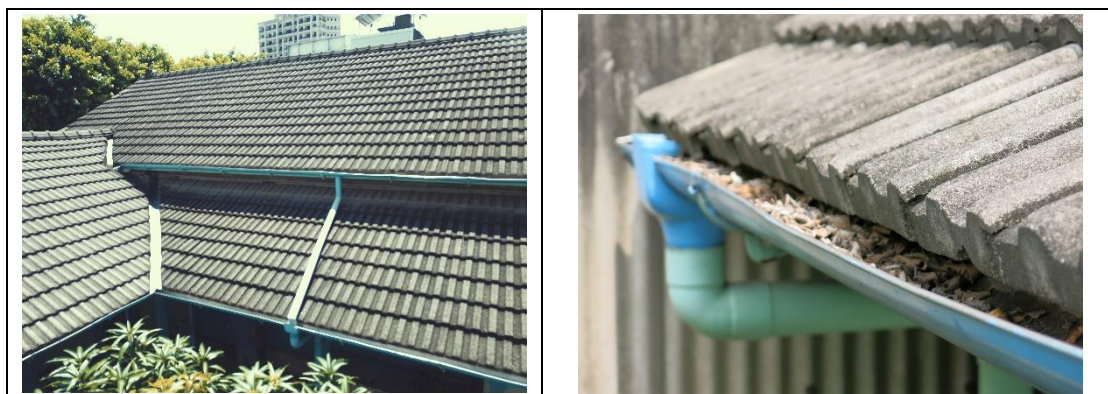
【相 5-5.13】屋頂天溝與落水管現況良好
