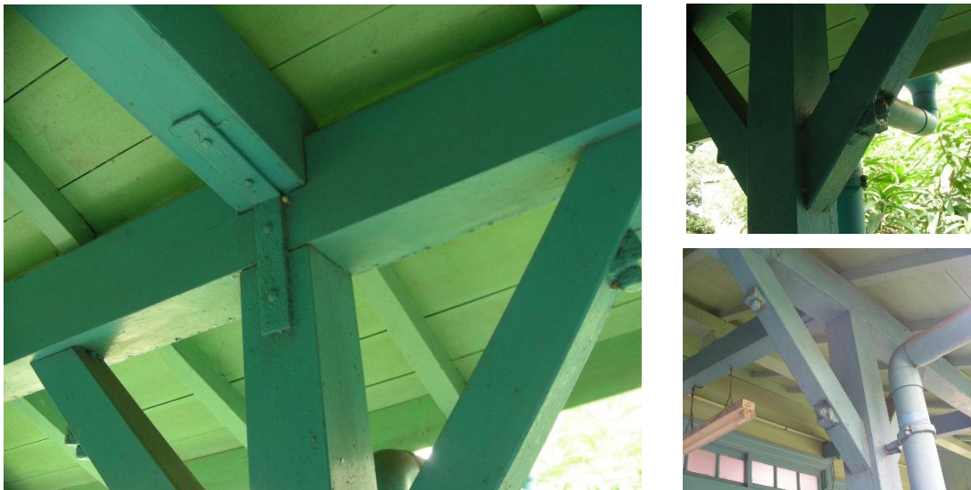
(2) 原台南運河海關簷廊屋架與簷柱結點處之三角托架（輔以螺栓與L形鋼板加固）
