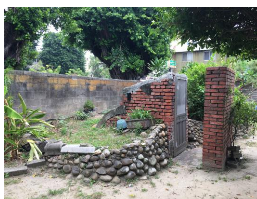
【圖 4-1.54】防空洞周邊以卵石疊砌現況
