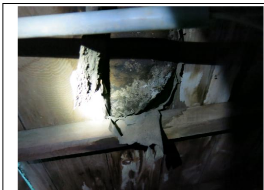
【相 5-5.17】屋面板及防水層破損情形
