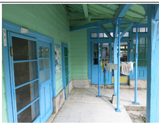
【相 5-5.10】屋架傾斜緊急支撐情形
