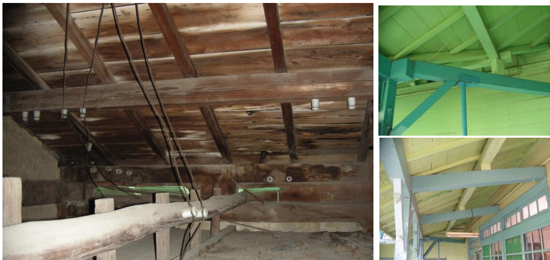
(3) 原台南運河海關西側次量體屋面以及簷廊屋面內側樣貌 【圖 4-2.2】原台南運河海關屋頂現況（二）
