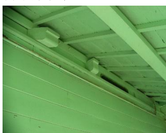
(2) 原台南運河海關西側次量體屋架單元與主量體連接處之縱向貫木中斷
