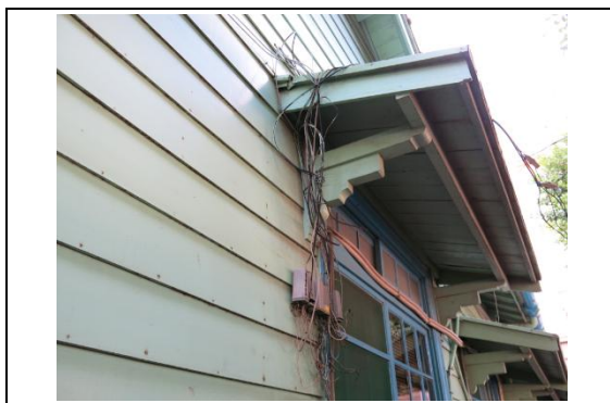
【相 5-5.25】雨庇屋面板有受潮及破損情形
