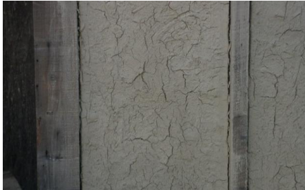
【圖 8-2.11】【圖 7-3.11】泥料乾縮木框出現縫隙 木節點以鐵件補強
