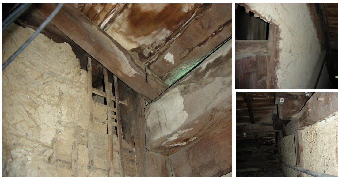
(2) 原台南運河海關牆體框架內之編竹夾泥構造
