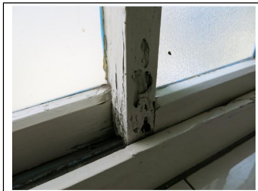
【相 5-7.7】W8 腐朽情形
