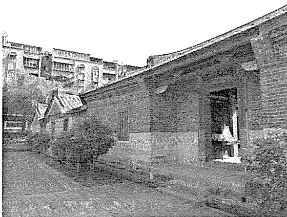
圖 4 石砌牆基、清水磚砌牆身
