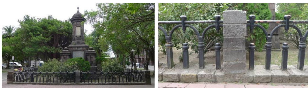
圖 43 獻誠碑之圍欄現況，因每邊採單數柱，致使原中央有階梯之中軸消失；且現有欄杆形式亦與獻誠碑不甚配合。
