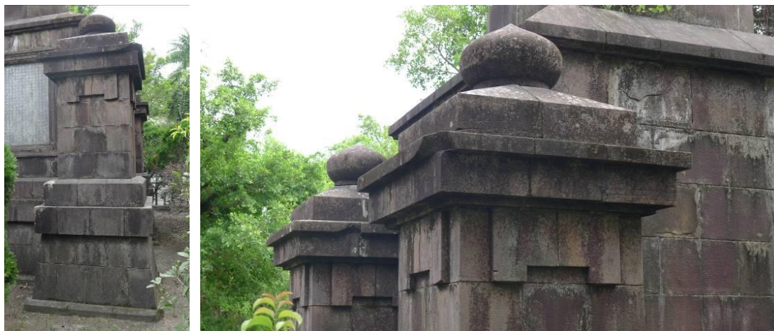
圖 49：構成獻馘碑碑座四角之四根角柱及其柱頭處理方式
