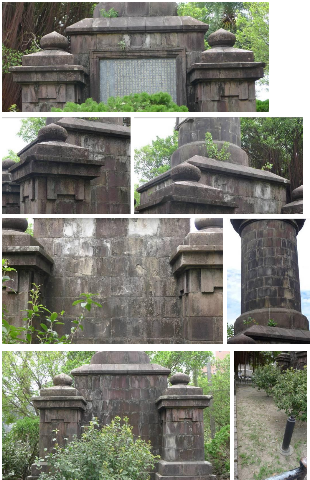
圖 45 獻誠碑碑體因經久日曬雨淋，表面產生污損或石材之風化剝落，另在平台上亦有植物附生。另獻誠碑圍欄內地坪設有景觀燈具，皆以損壞，亦應整體考量。
