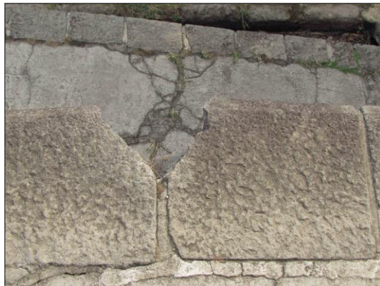
圖 7-174 砲座(1)右側欄杆孔
