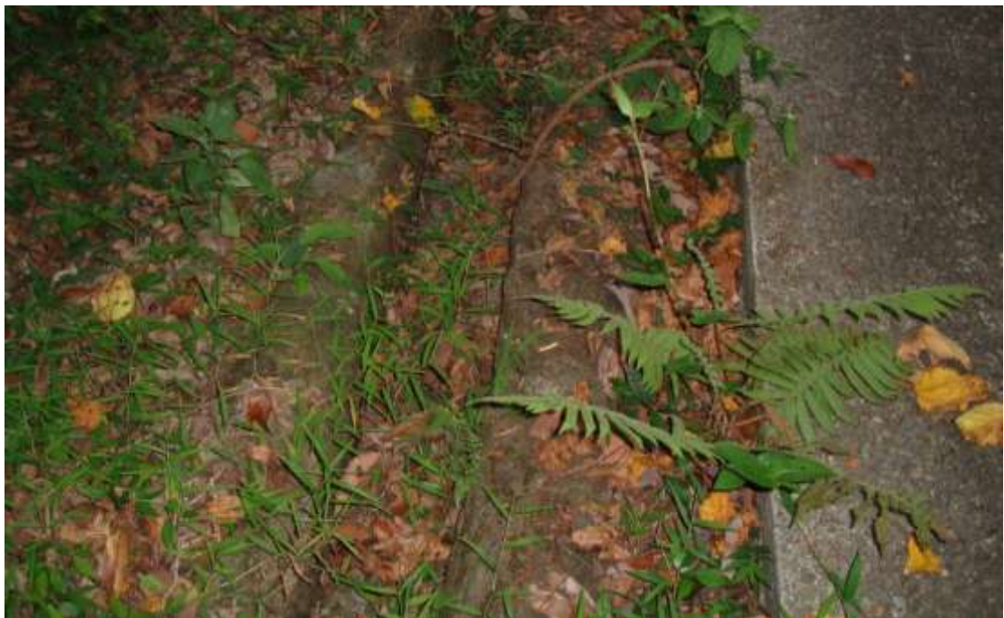
圖5-10 3m寬的砲台主要交通路日治時期所做的排水溝尚存
