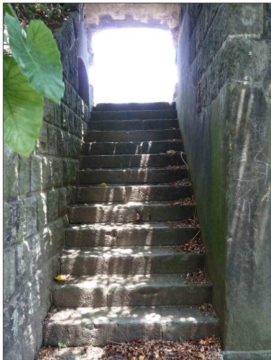
圖 7-115 往觀測所樓梯
