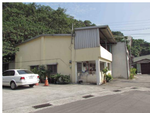
圖 7-14 編號 12 兵舍(已拆毀民眾改建為自宅)
