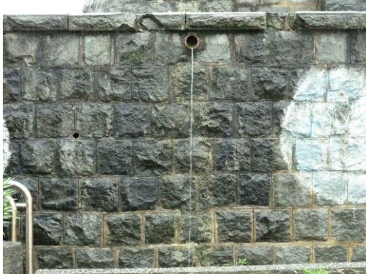
圖 7-01 已破壞的排水系應依循環水法修復
