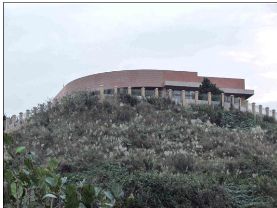
圖 7-025 左側射擊指揮所舊址
