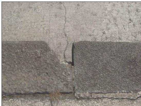
圖 7-173 砲座(1)右側欄杆孔
