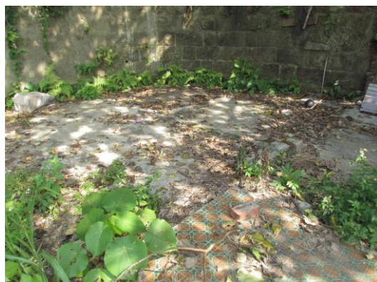
圖 7-15 編號 13 監守衛舍(已拆毀未整理)
