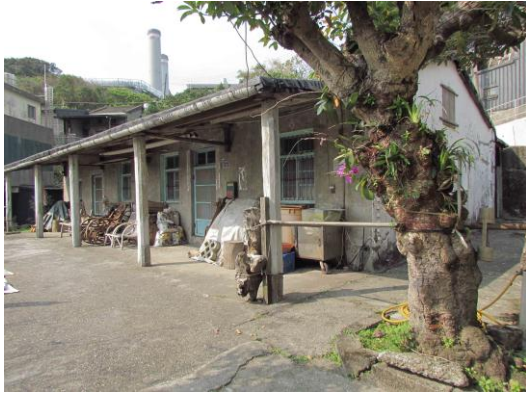
圖 7-19 編號 17 洗濯場 浴室(已拆毀民眾改為自宅)
