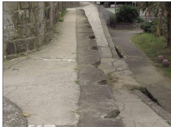
圖 7-172 砲座(1)右側欄杆孔
