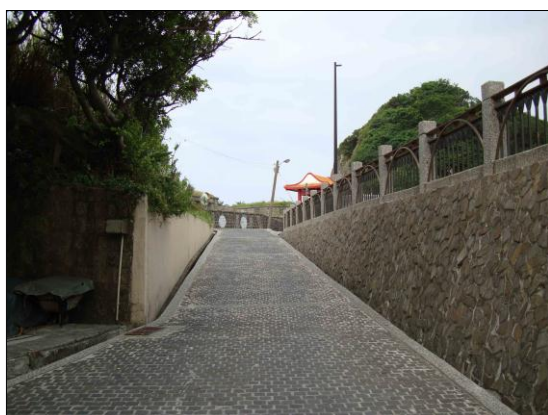
圖 7-029 貯水所(1)旁走道
