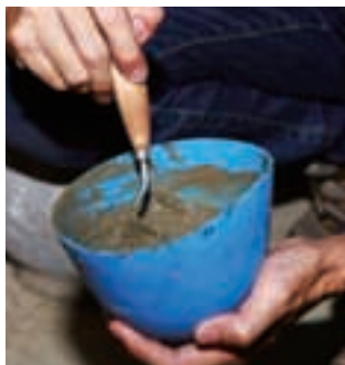
圖1-2-5 在橡膠碗內充分攪拌麻絨水泥
