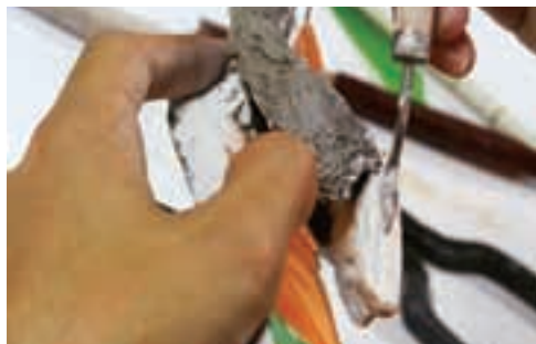
圖1-2-26 粗胚表面塗抹棉仔灰打底灰來回勻平
