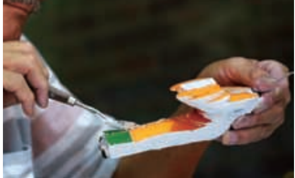
圖1-2-29 經過灰匙仔無數次來回粉光，棉仔灰面層光滑、平整且緊實。
