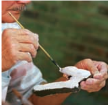
圖2-3-24 拿畫筆沾水潤飾棉仔灰表面的灰屑。
