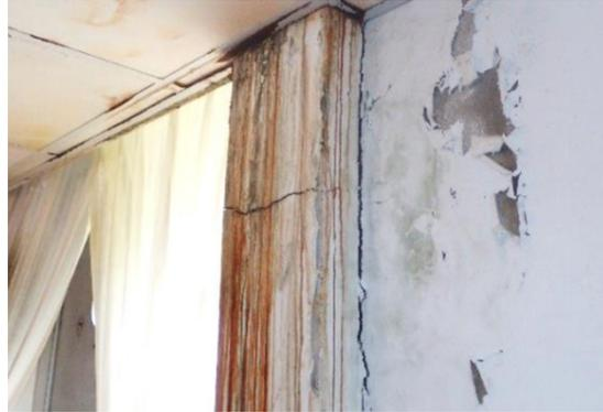
【照片 22】二樓夾層儲藏室北側柱子表面有明顯裂痕與漏水痕跡(陽明山中山樓市定古蹟調查研究及再利用)
