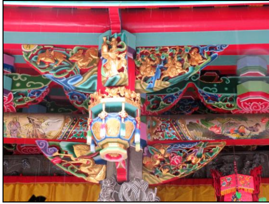
【照片 24】三川殿前步口托木、吊筒、豎材
