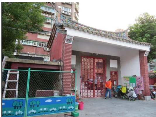
【照片 12】大門警衛室整修工程
