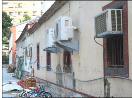
【照片 11】右護室室外空調裝設現況
