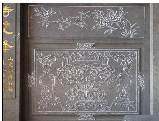
【照片 23】三川殿螭虎團爐堵、花鳥堵
