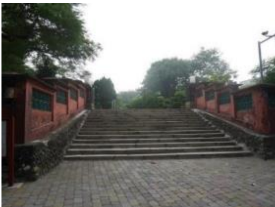
圖 3-33 五妃廟街廓入口處階梯
