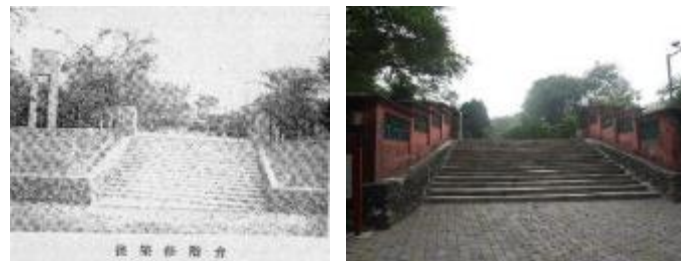
圖 3-6 廟前台階於 1966 年修築後及現況
