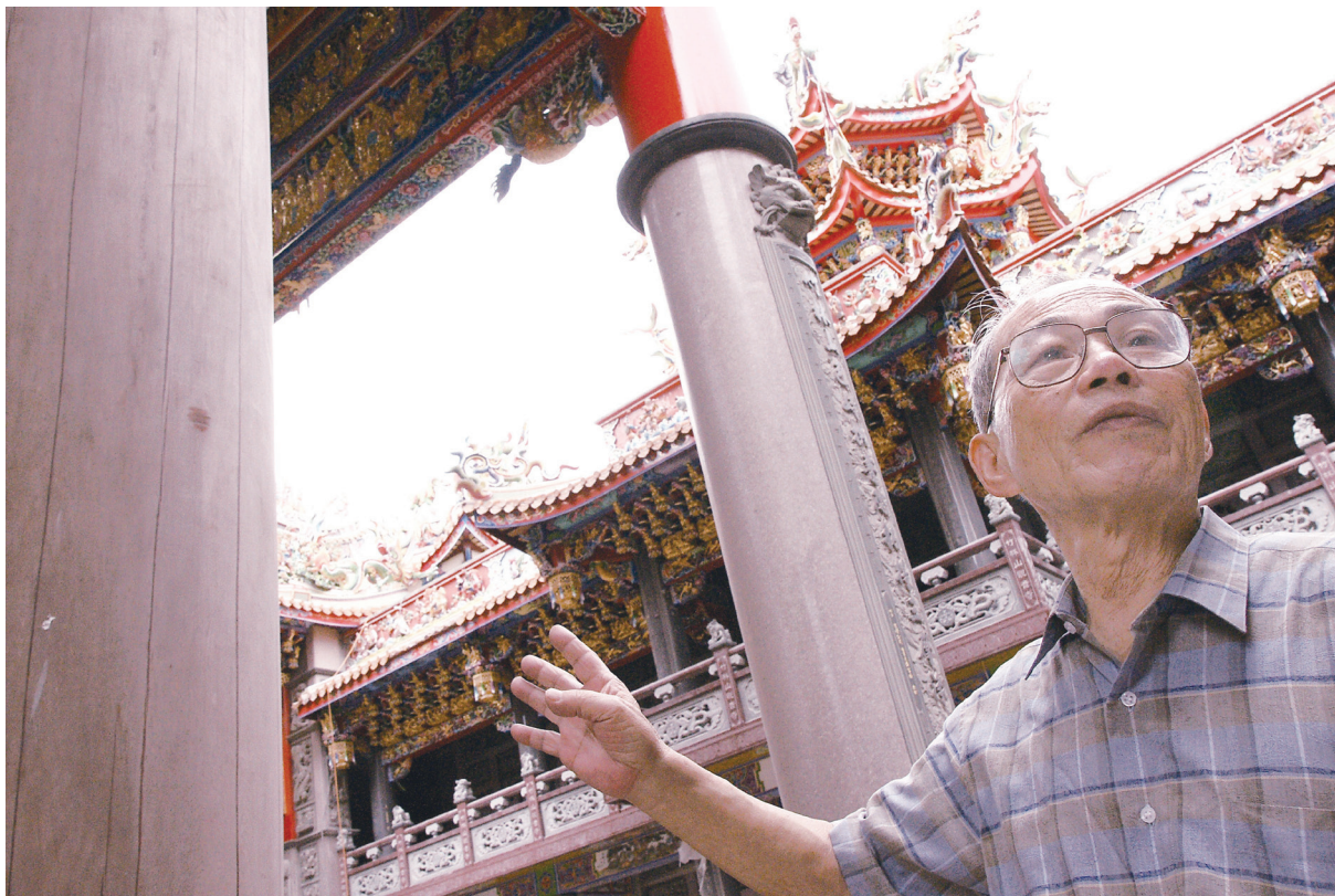
新北市林口竹林山觀音寺的改建工程依照傳統建法，沒用到一根釘子，全部以卡榫結合，完整保留傳統木構造的建築精華。
