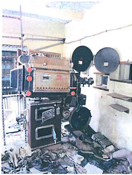
電影放映機現況 (108 年 11 月拍攝)
