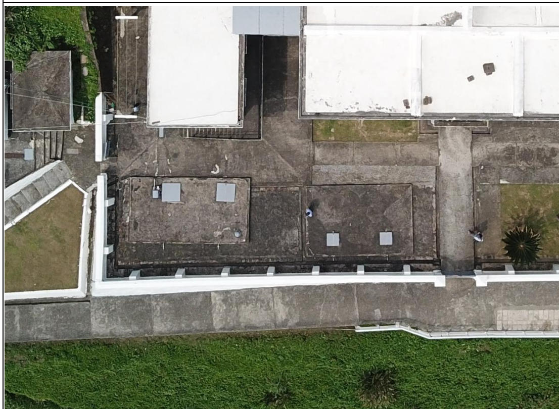
照片八 地下貯水池空拍照
