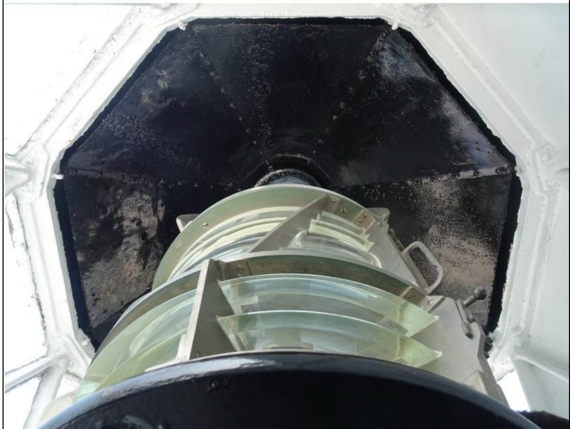
照片六 燈籠層內部俯瞰燈器及穹窿頂
