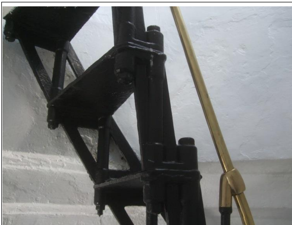
照片七 燈塔內預製鑄鐵樓梯及扶手
