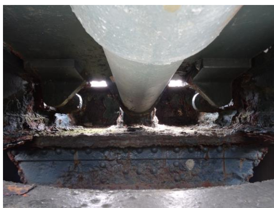
圖 4-21 炮架與中央磨心接合應力腐蝕嚴重
