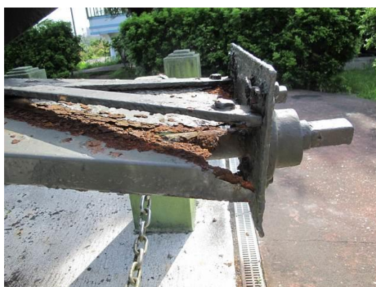
圖 4-11 操炮桿遮蓋腐蝕支板與固定架脫離
