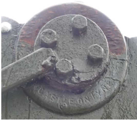
圖 4-01 炮耳腐蝕使表層及油漆爆裂
