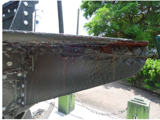
圖 4-14 操炮平臺下緣腐蝕
