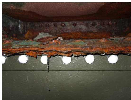
圖 4-26 轉架上板腐蝕相當嚴重
