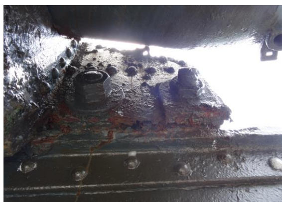
圖 4-10 炮體下的轆架橫材腐蝕嚴重
