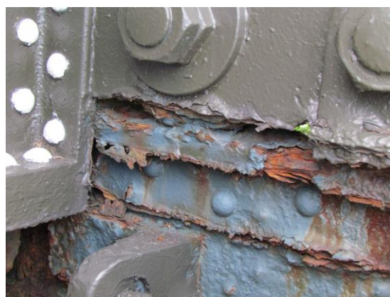
圖 4-22 轆架下端應力腐蝕嚴重
