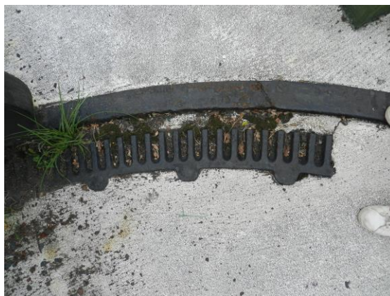
圖 4-17 半圓周形的滑軌及齒軌已缺損三段
