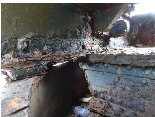
圖 4-09 轆架與磨心應力腐蝕嚴重部分殘斷
