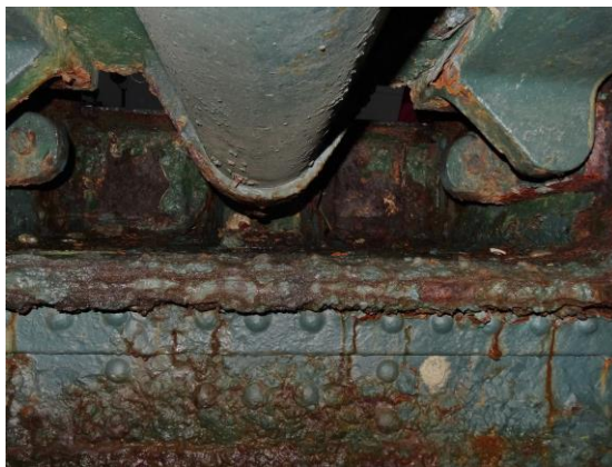
圖 4-20 液壓避震器下撐架腐蝕嚴重
