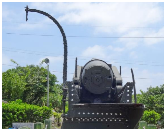
圖 4-16 整支吊炮桿腐蝕有斷裂之虞吊炮鍊已失
