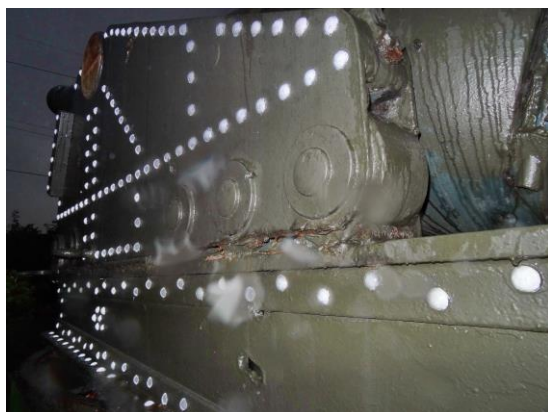
圖 4-08 滾輪與轆架間應力腐蝕嚴重使炮架鎖死
