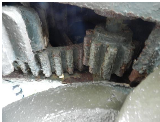
圖 4-25 齒輪連動組內部腐蝕
