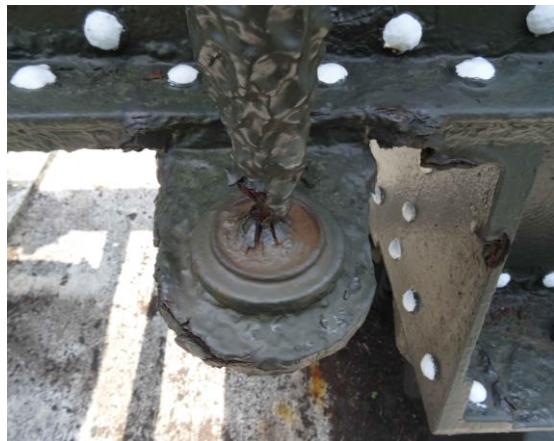
圖 4-15 吊炮桿下段腐蝕嚴重已無固定力
