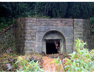
東慶煤礦坑道口
