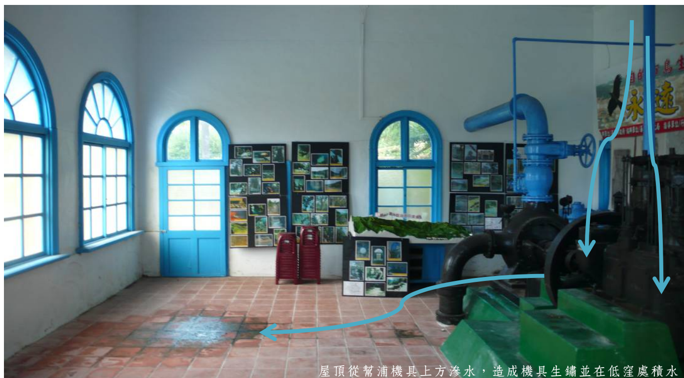
屋頂排水孔堵塞，致原洞口於大雨積水時從此處滲水
