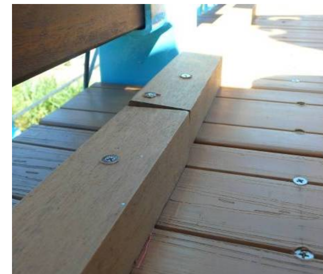
吊橋施工粗糙
