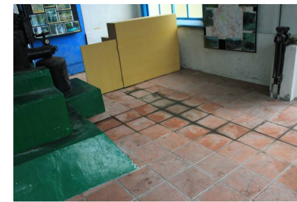
漏水從幫浦機具順著地勢流向低窪地並在此積水
