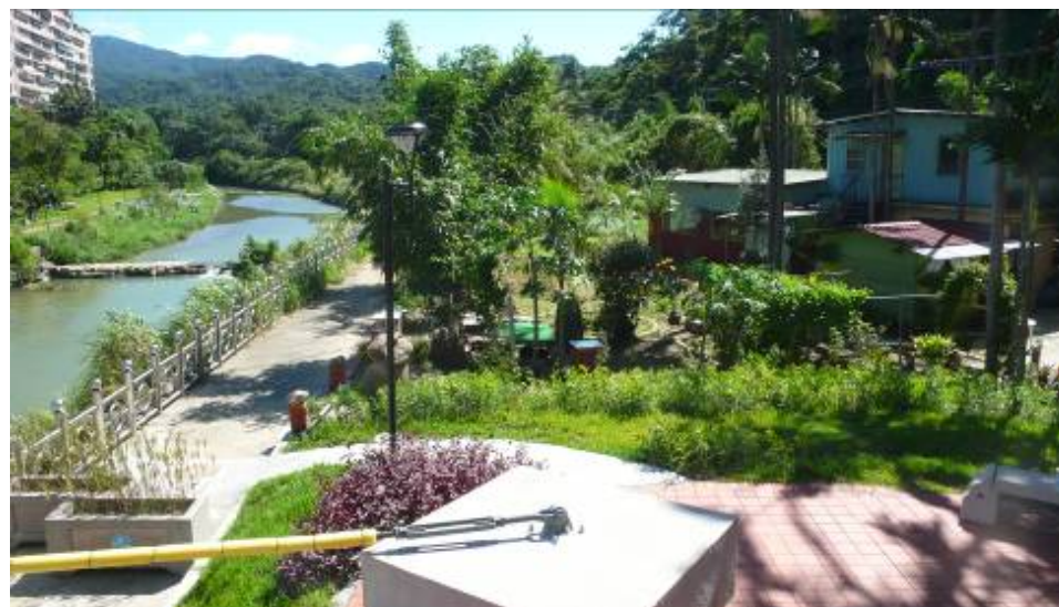
新設吊橋與私有土地缺乏緩衝
