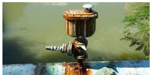
使用中的水管外觀佈滿鏽斑
