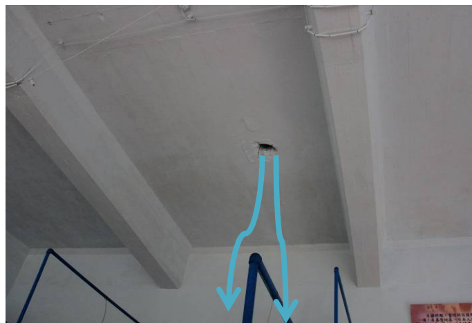
屋頂排水孔堵塞，致原洞口於大雨積水時從此處滲水
