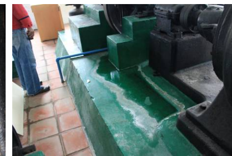
漏水從幫浦機具順著地勢流向低窪地並在此積水
