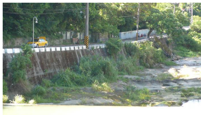
水源路護岸剖面上缺乏親水空間
