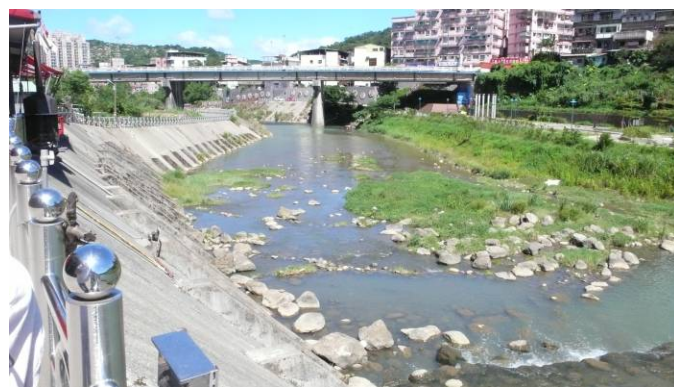
僵硬的水泥護岸
