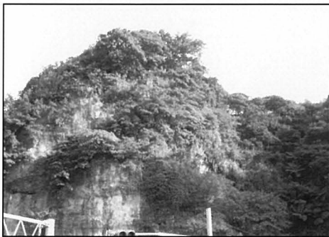
洞口左側岩壁為獅子山剷除後裸露山壁
