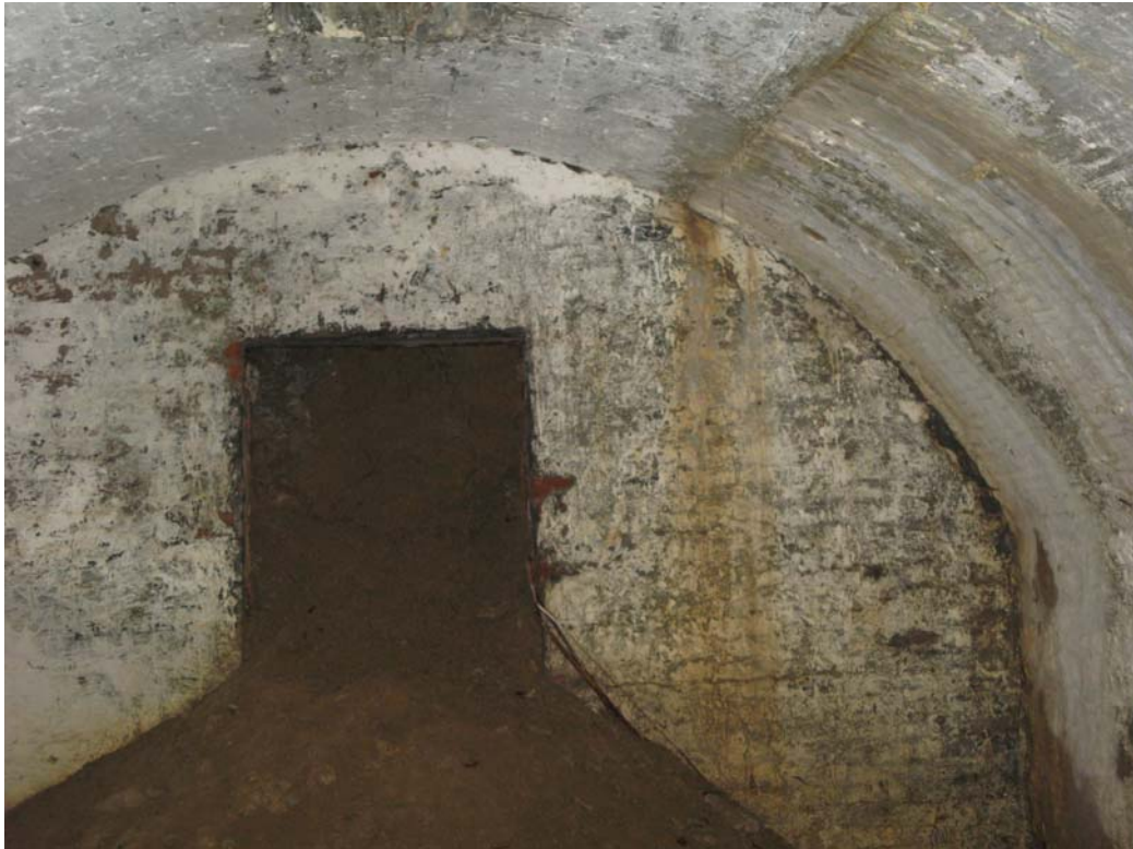
圖 12 通道上嚴重的土石崩塌，應有其他砲臺遺構尚待挖掘探勘
