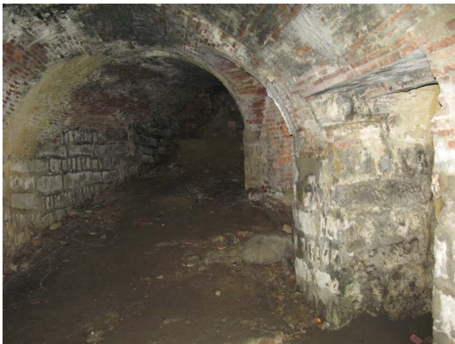
圖 21 砲臺內部甬道壁體土石崩塌情形
