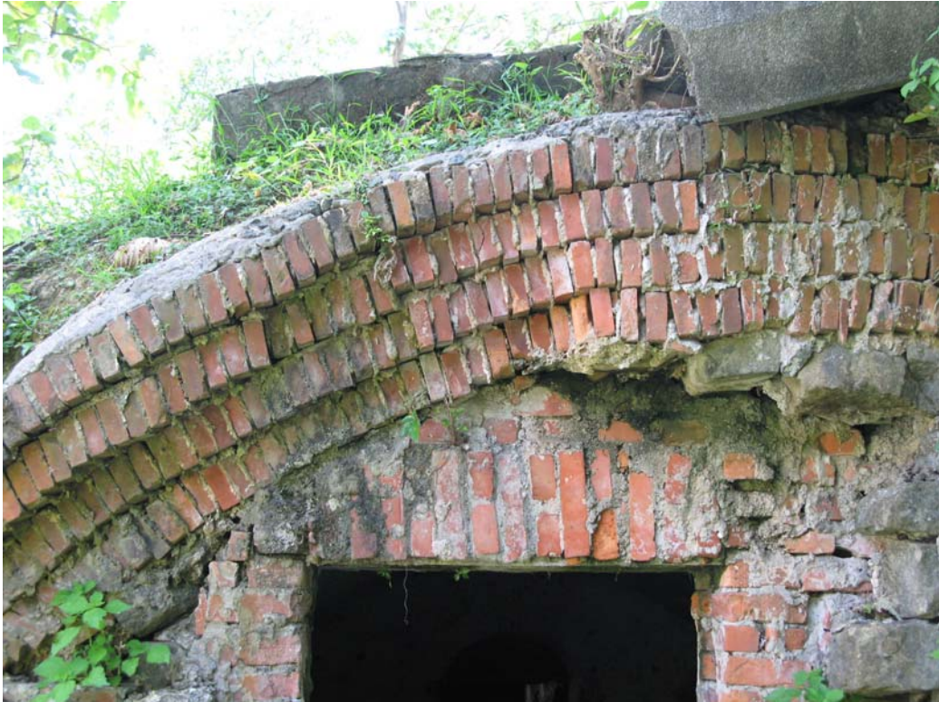
圖 13 拱頂由四層磚拱所構成
