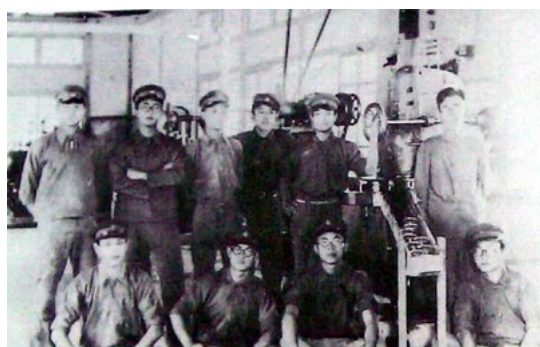
照片 2-2-19 一期製造科全體學生於實習工場 出處：基隆海事職校提供
