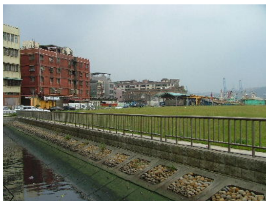
照片 2-1-2 港岸邊的建築，原海港已經填土
