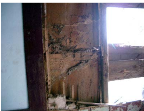
照片 4-1-77 漆喰壁（木舞下地）白蟻蛀蝕破壞
