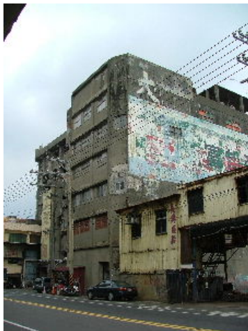
照片 2-1-14 濱町港邊的大洋 冷凍工廠
