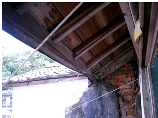
照片 4-1-67 磚牆砌磚型式
