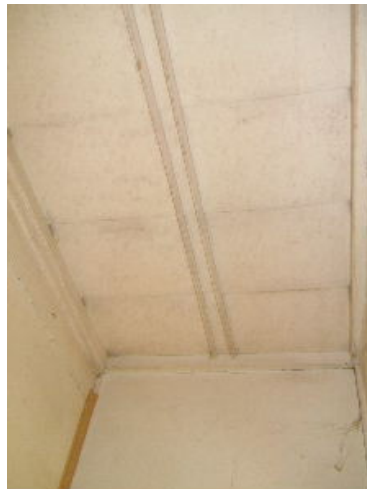
床之間天井(吹寄猿頰棹緣板)
