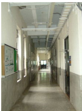
照片 3-1-19 二樓廊下(走廊)
