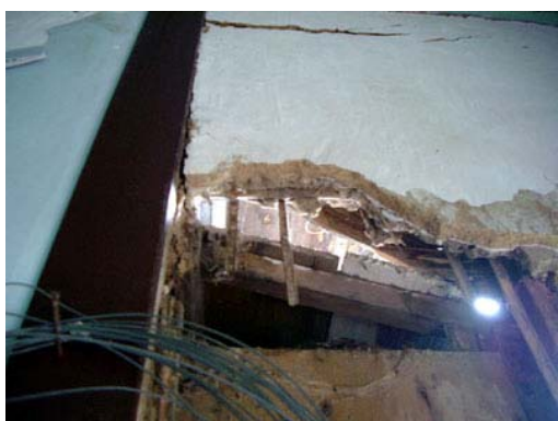
照片 4-1-78 漆喰壁（木舞下地）白蟻蛀蝕破壞
