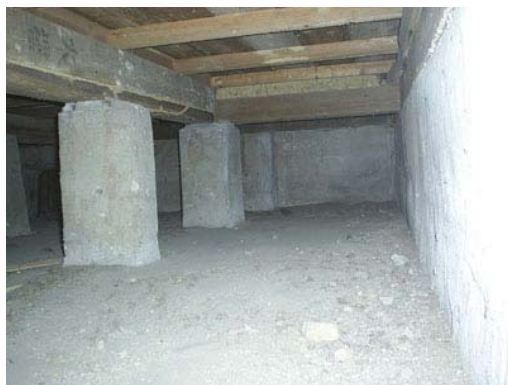
照片 4-1-1 防蟻混凝土
