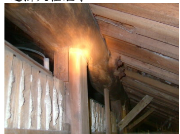
椽側木柱與軒桁接頭
