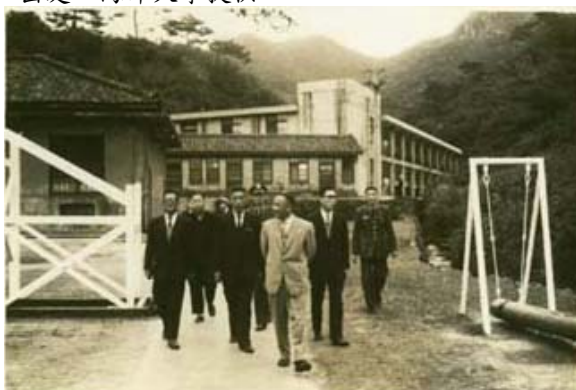
照片 3-1-14 校區內的舊建築 出處：海洋大學提供
