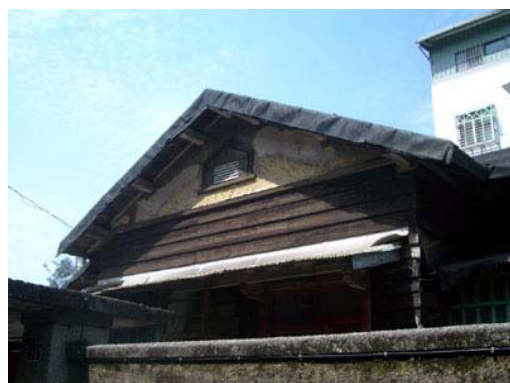
照片 4-1-60 荒壁外牆外觀
