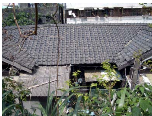
照片 4-1-86 切妻造妻側屋根
