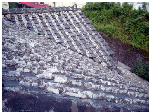
照片 4-1-89 屋瓦水泥砂漿防水處理
