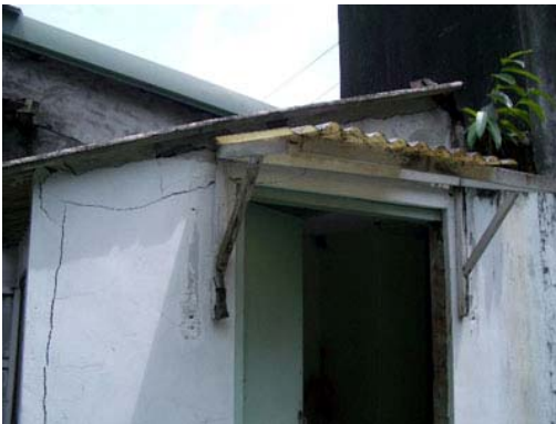
照片 4-1-70 結構性破壞裂縫
