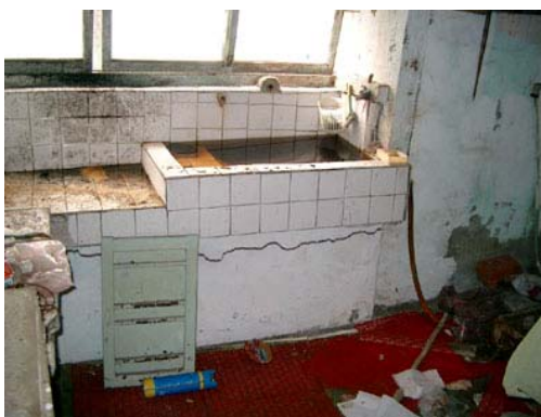
照片 4-1-118 洗手台出挑裂縫
