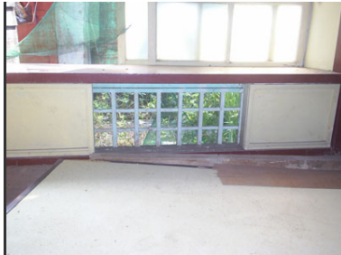
換氣窗板襖障子為通清槽 左右開的設計
