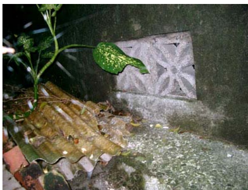
照片 4-1-23 增建空間換氣孔
