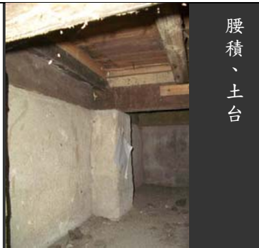
混凝土腰積、磚造腰積
