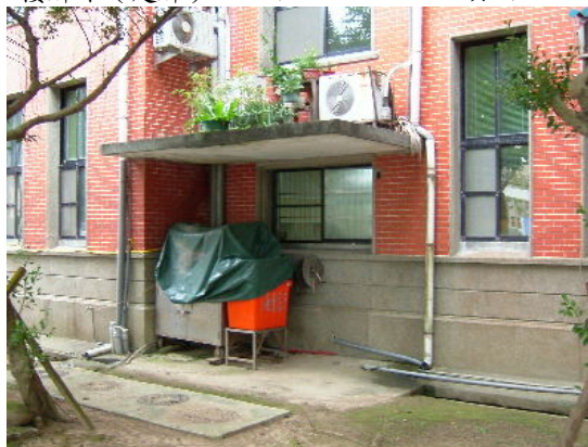
照片 3-1-22 樓梯間出入口(已封死)
