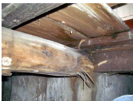
照片 4-1-36 床構件腐蝕
