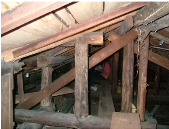
照片 3-4-1 切妻屋架與原有構架的接頭
