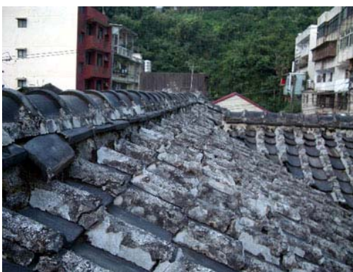
照片 4-1-92 鬩斗瓦破損
