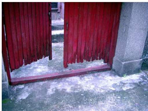
照片 4-1-115 門作破損
