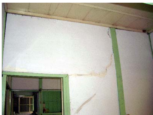
照片 4-1-76 內牆斜向裂縫
