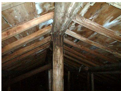
照片 4-1-45 屋架構件腐朽
