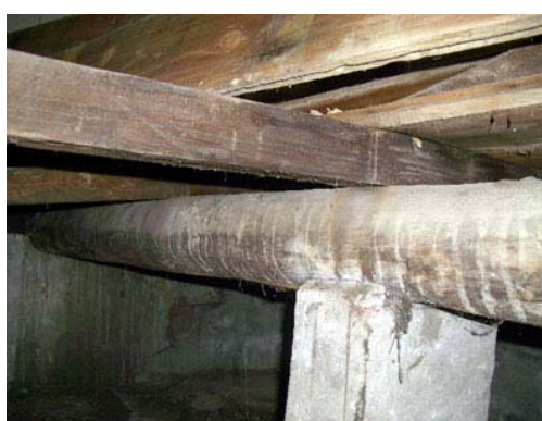
照片 4-1-35 床結構構件潮濕
