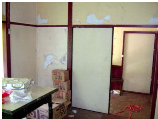
照片 4-1-74 室內牆面飾剝落
