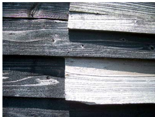
照片 4-1-54 下見板木材乾裂變色
