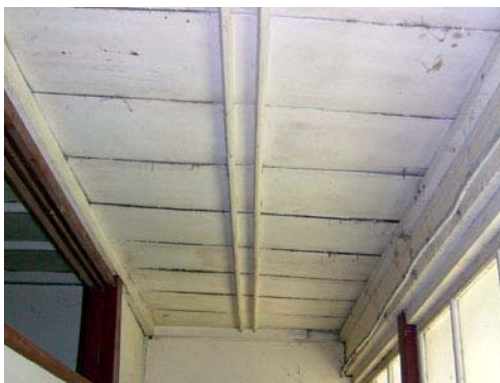
照片 4-1-98 緣側寄猿類棹緣式天花板
