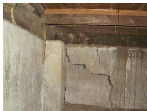
照片 4-1-11 腰積斜向裂縫
