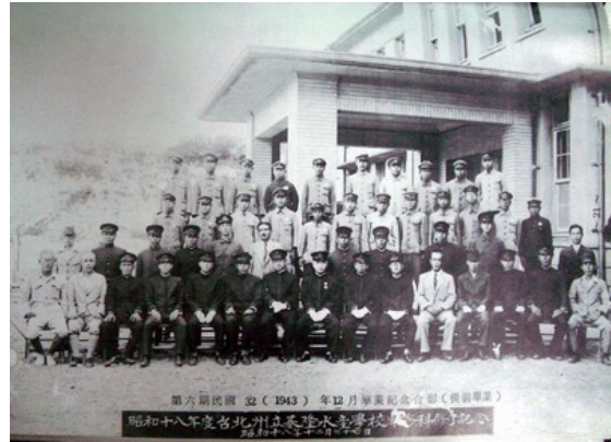
照片 3-1-26 校舍本館車寄(門廊)，此為 1943 年 12 月 1 日畢業生合影舊照 出處：《早期畢業校友紀念冊》，基隆海事職校提供
