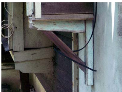
照片 4-1-111 出窗腕木補強
