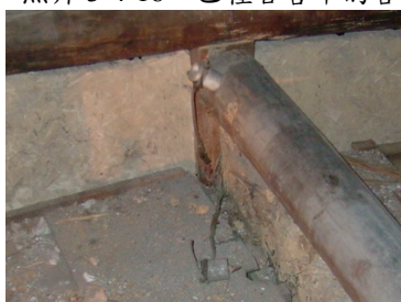
延押入配置の舊有電線與礙子
