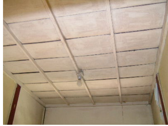
玄關天井(棹緣板)
