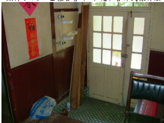
玄關周圍真壁、腰羽目板
