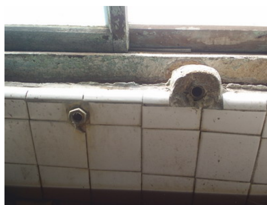
照片 3-4-19 炊事場洗手台上的水孔
