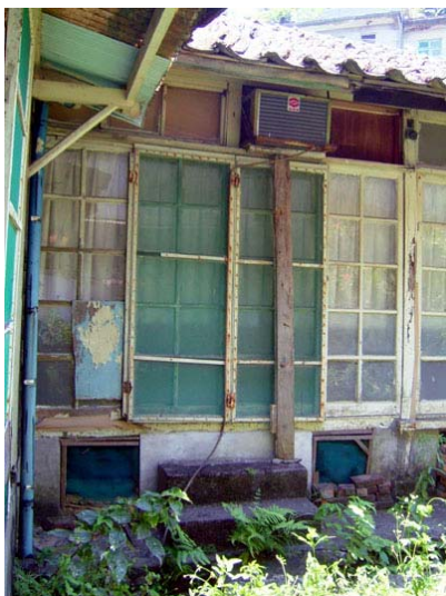
照片 4-1-122 窗型冷氣支撐
