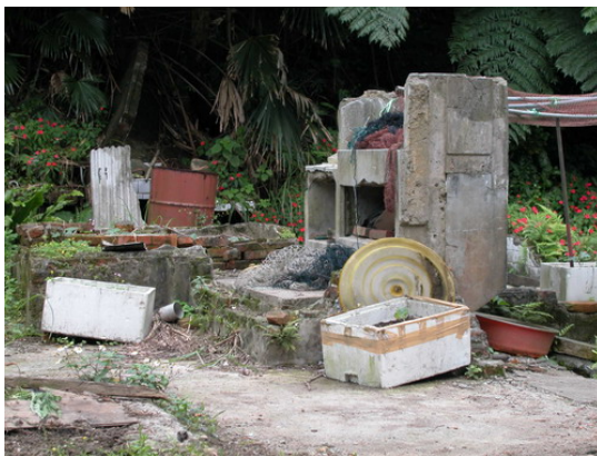
照片 3-1-32 原有廚房基礎
