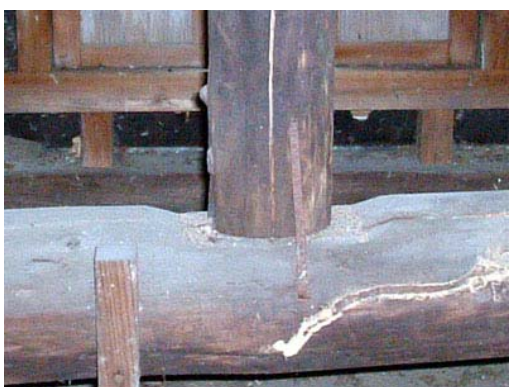
照片 4-1-43 投掛梁與小屋束
