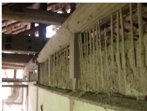
照片 4-1-29 漆喰壁（木舞下地）破壞
