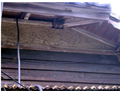
照片 4-1-61 荒壁外牆外觀
