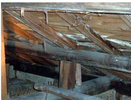
照片 4-1-88 檼木與母屋腐朽
