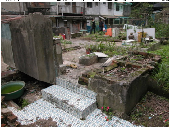
照片 3-1-33 原有廚房與外部入口
