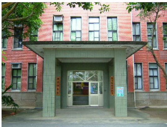
照片 3-1-17 正入口車寄（門廊）
