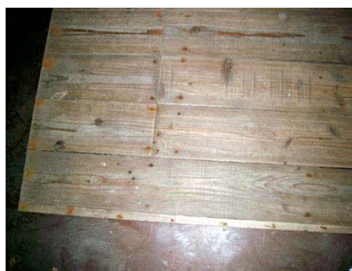
照片 4-1-106 夾板鋪設於揚板之上
