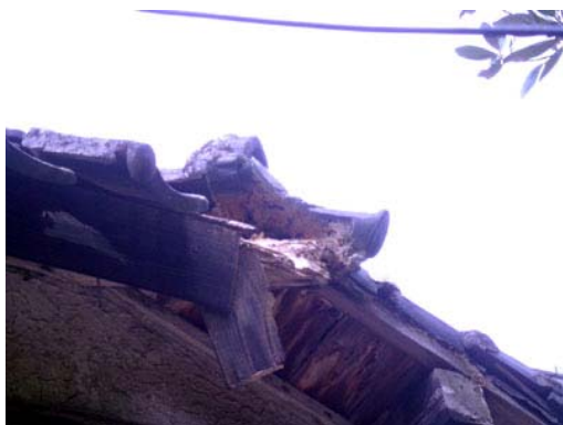
照片 4-1-91 鬼瓦破損
