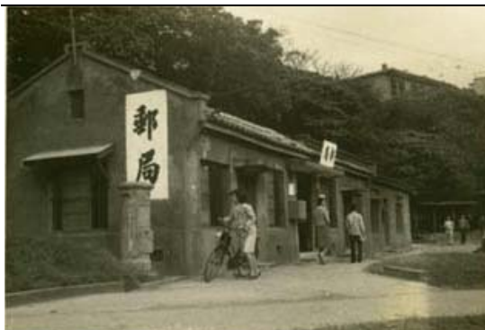
照片 3-1-11 校區內的舊建築 出處：海洋大學提供
