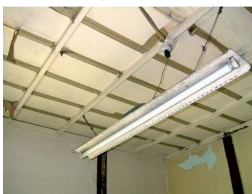
照片 4-1-102 膠帶修補痕跡
