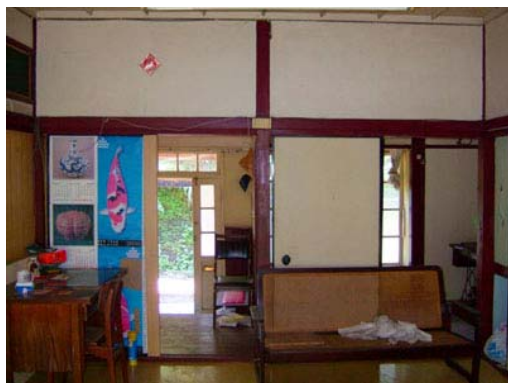
照片 4-1-27 室內軸組系統
