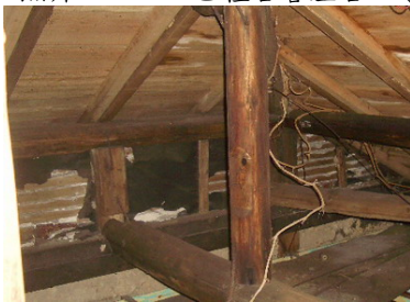
木摺壁內的防水瀝青（黑色部分）
