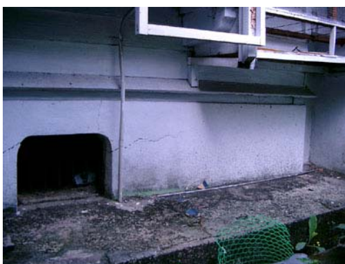
照片 4-1-8 腰積外側
