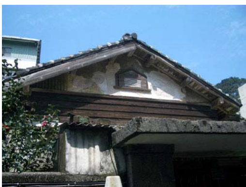
照片 4-1-64 荒壁外牆表面剝落破壞
