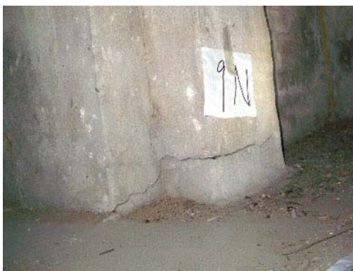
照片 4-1-17 磚束水平裂縫
