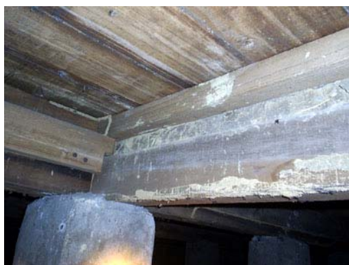
照片 4-1-34 床結構構件潮濕
