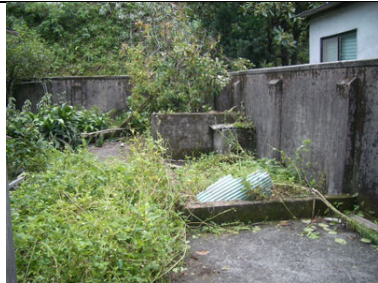
僅剩基礎的廚房現況
