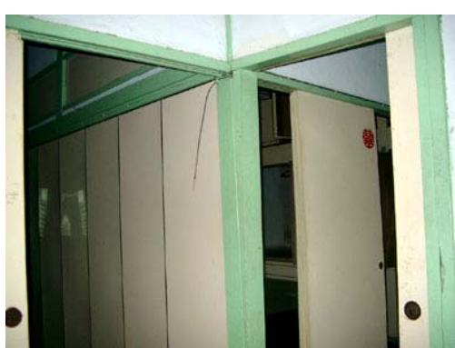
照片 4-1-30 門框新增立柱支撐
