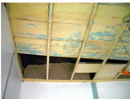
照片 4-1-100 板片脫落下陷
