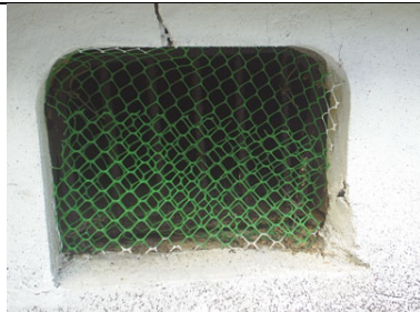
地板下換氣窗為混凝土建造，塗上水泥，內部貼上金屬網
