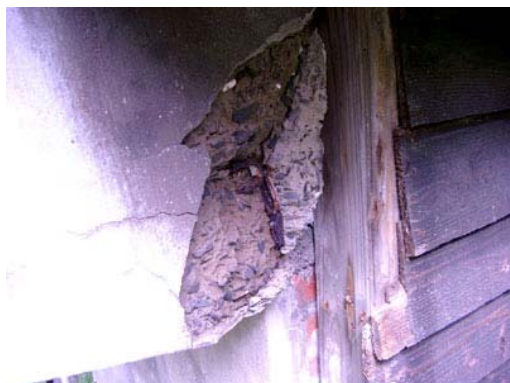
照片 4-1-119 洗手台鋼筋銹蝕
