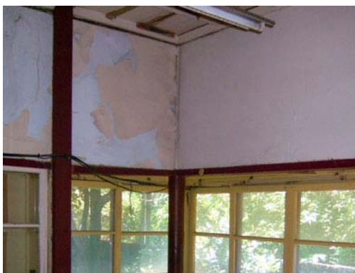
照片 4-1-75 室內牆面飾剝落
