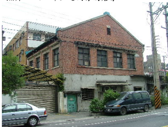
照片 2-1-7 中正路旁的舊建築
