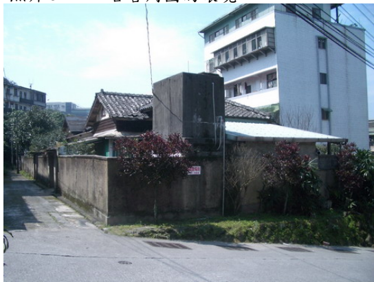
照片 5-2-3 水塔、圍牆與巷道
