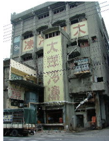
照片 2-1-16 濱町港邊的大洋 冷凍工廠
