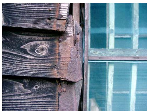
照片 4-1-58 下見板交角鐵件
