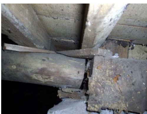
照片 4-1-37 床構件腐蝕
