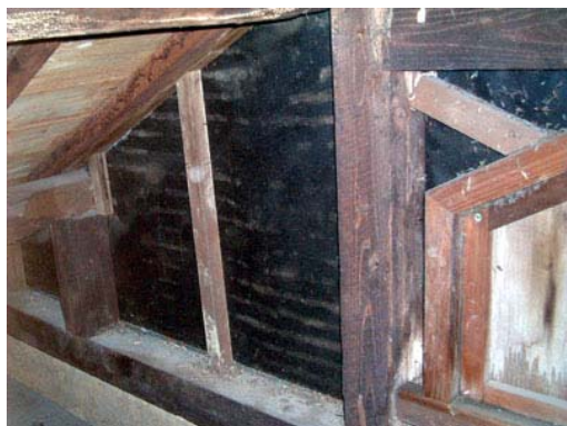
照片 4-1-62 荒壁外牆內側紗網
