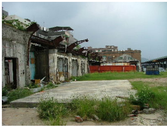
照片 2-1-19 已經拆除的魚市場（僅存餘構）
