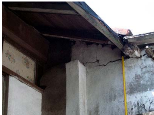
照片 4-1-71 結構性破壞裂縫
