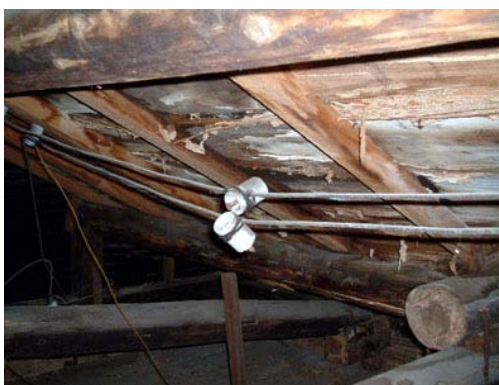
照片 4-1-121 屋架內礙子
