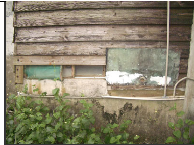
大便所掃出窗為交錯的玻璃障子
