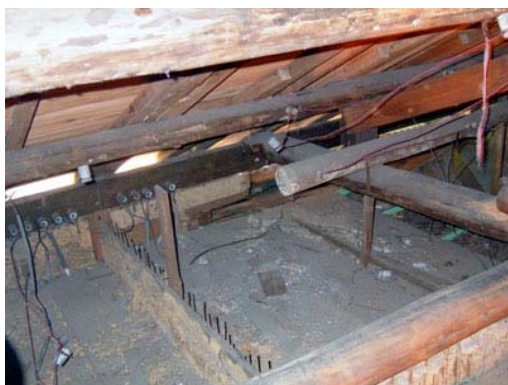
照片 4-1-72 漆喰壁(木舞下地)構造
