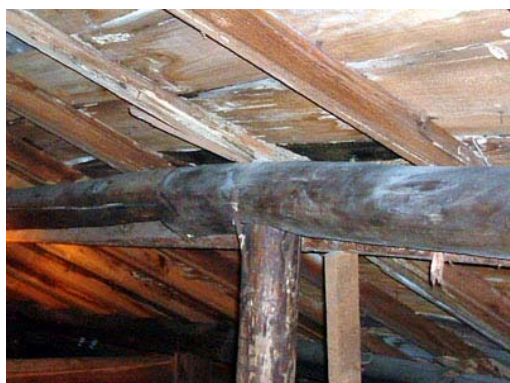
照片 4-1-87 檼木與母屋腐朽
