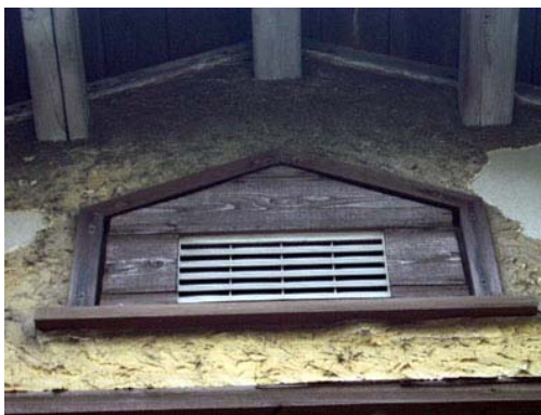
照片 4-1-63 荒壁外牆表面剝落破壞
