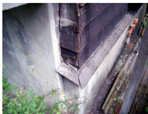
照片 4-1-59 雨押鬆脫破壞
