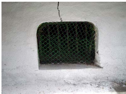
照片 4-1-20 床下換氣孔
