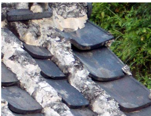
照片 4-1-90 屋瓦水泥砂漿防水處理
