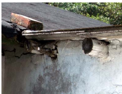
照片 4-1-95 鼻隱破壞母屋腐朽
