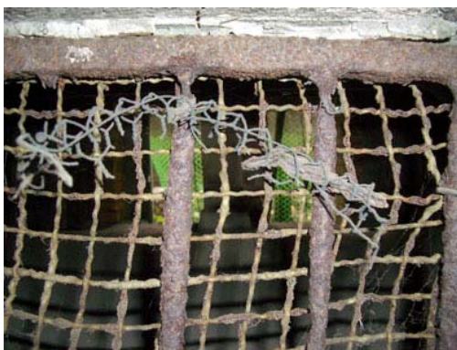
照片 4-1-21 鑄鐵格柵
