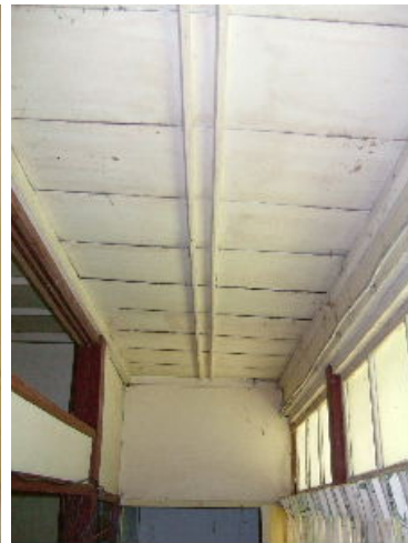
椽側天井(吹寄猿頰棹緣板)
