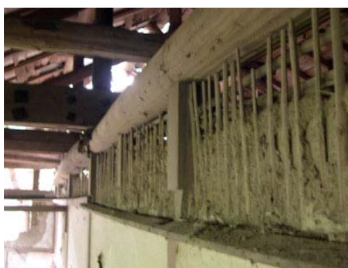
照片 4-1-73 漆喰壁(木舞下地)破壞
