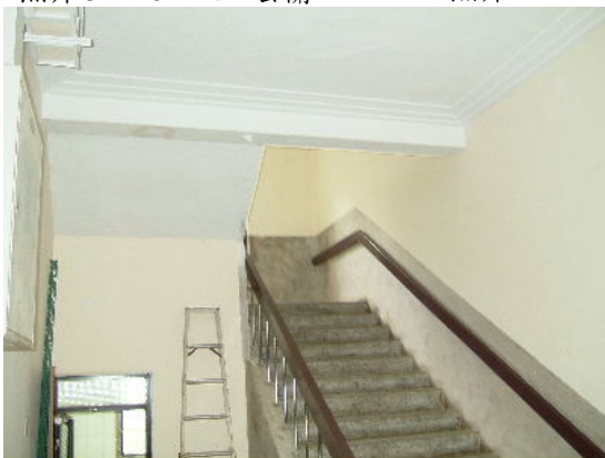
照片 3-1-21 階段室(樓梯間)
