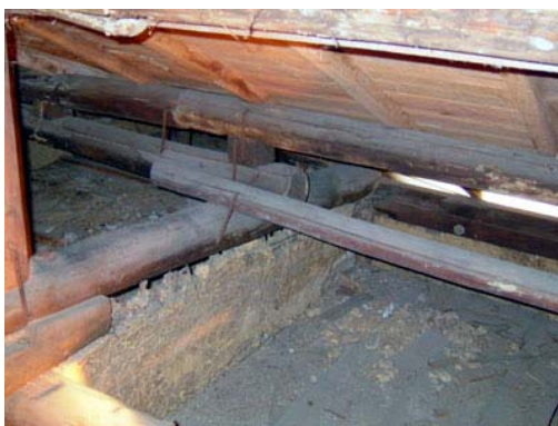
照片 4-1-82 屋根通風口
