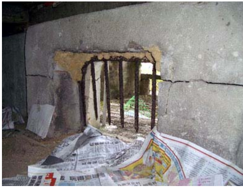
照片 4-1-12 腰積水平裂縫
