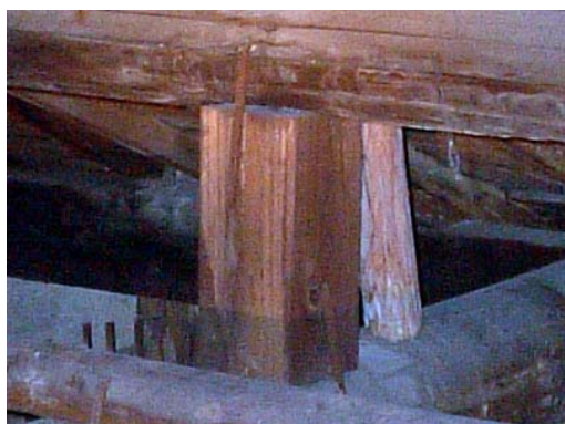
照片 4-1-49 小屋束支撐補強
