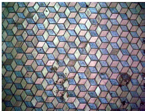
照片 4-1-107 浴廁地坪磁磚
