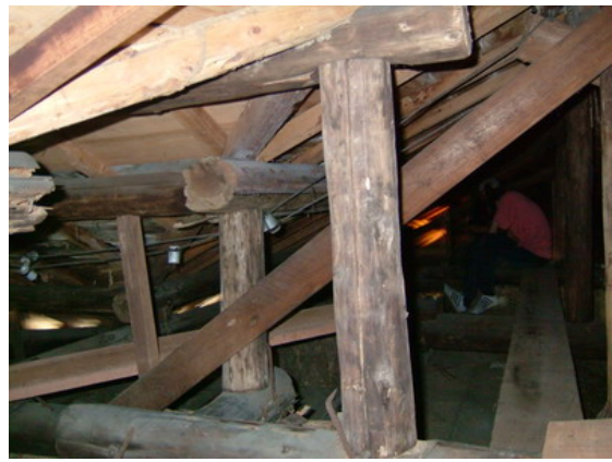
照片 3-4-2 切妻屋架部位原有母屋構架中斷
