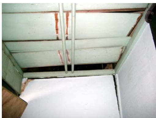
照片 4-1-101 押緣板片分離
