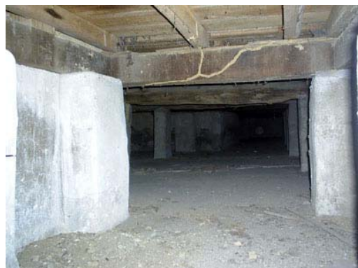
照片 4-1-38 床構件白蟻蛀蝕
