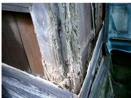
照片 4-1-31 立柱白蟻蛀蝕
