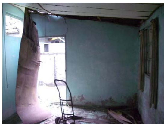
照片 3-3-82 加建房間
