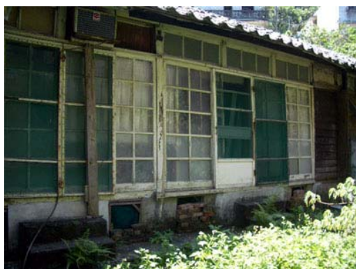
照片 4-1-117 緣側落地門窗增建
