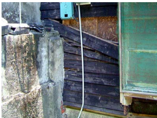
照片 4-1-56 板材剝落破壞
