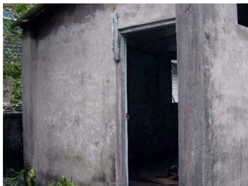
照片 4-1-65 增建磚牆外觀
