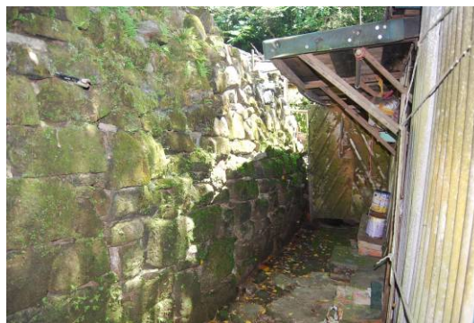
照片 3-2-11 疑似原有城門基腳位置（上方砌石為後期重砌）
