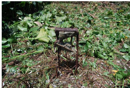
照片 3-2- 33 後期增建建物桁架
