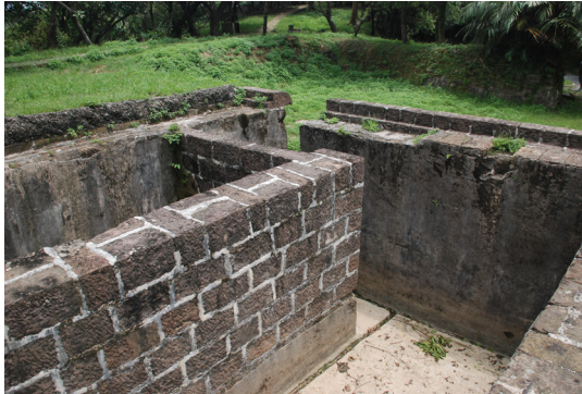
照片 3-2-5 二沙灣砲台北砲座彈藥庫
