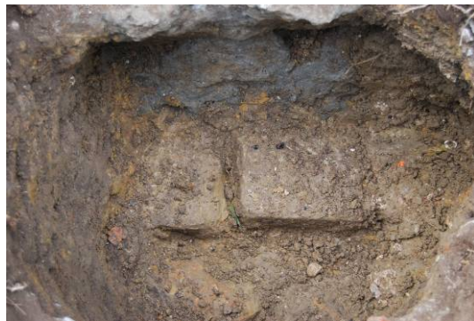
照片 3-2- 31 後期增建建物基腳下方的原房舍基礎
