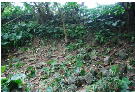
照片 3-2-20 樓梯護坡現況
