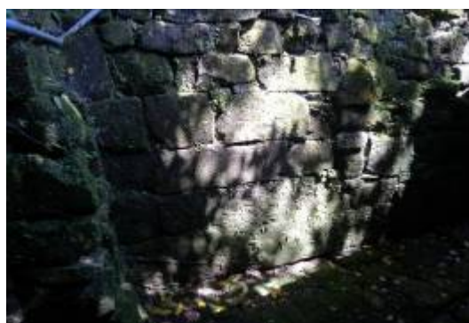
照片 3-2-9 疑似原有城門基腳位置（下方砌石平整）
