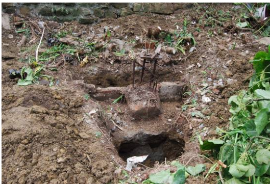
照片 3-2- 30 後期增建建物基腳
