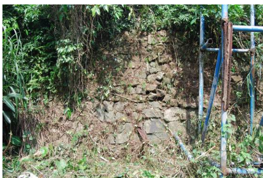
照片 3-2-24 連通第四層石砌護坡牆（樓梯已填實）
