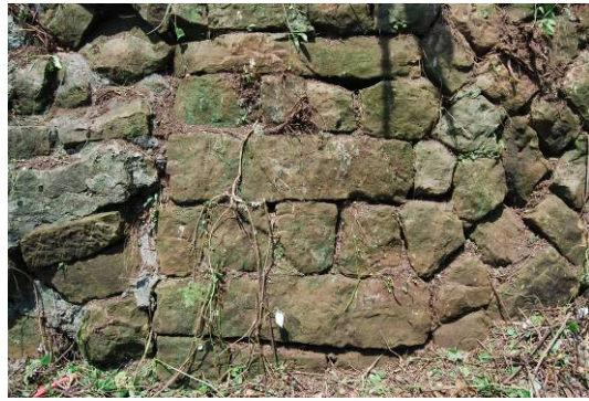
照片 3-2- 29 原有樓梯兩旁的順丁砌法石砌
