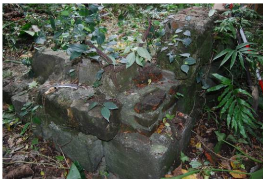
照片 3-2-18 後期增建建築物基腳
