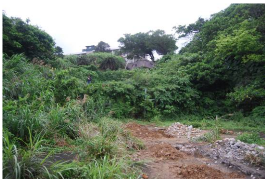
照片 3-2-22 第三層平台清理現場
