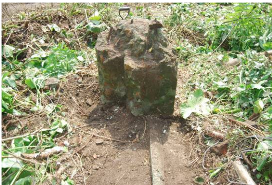
照片 3-2- 32 後期增建建物混凝土基腳
