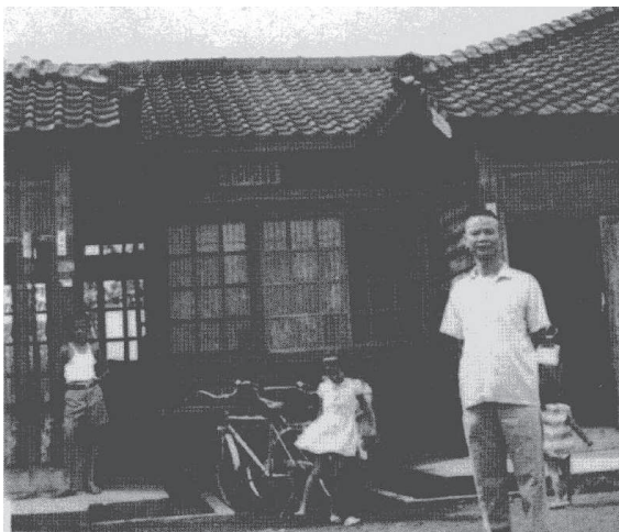
【圖 2-1-01】日軍遺留宿舍（屏東縣東港鎮共和新村舊照）。《國軍眷村發展史》，P.221。
