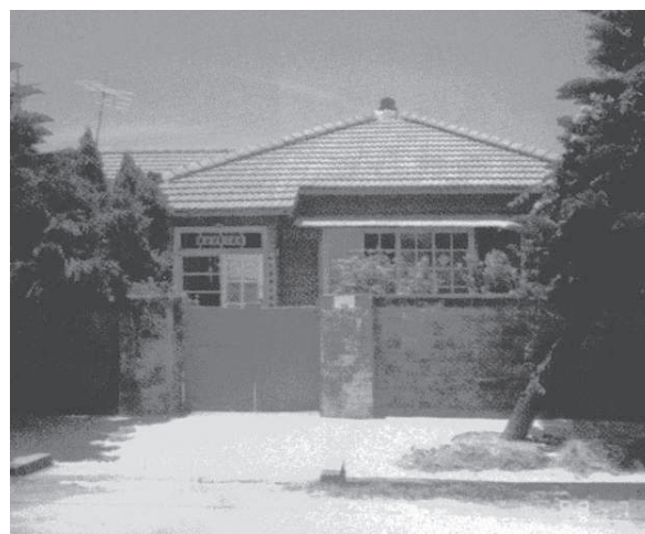
【圖 2-1-02】日軍遺留宿舍（屏東縣東港鎮共和新村舊照）。《國軍眷村發展史》，P.224。
