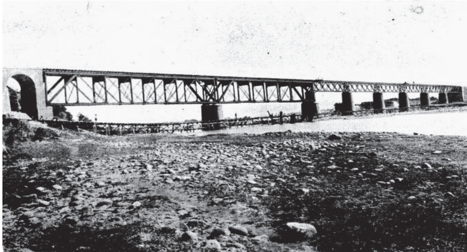
圖 2-81 1902 年（明治 35 年）4 月竣工之鳳山溪橋 資料來源：台灣鐵道史中卷。
