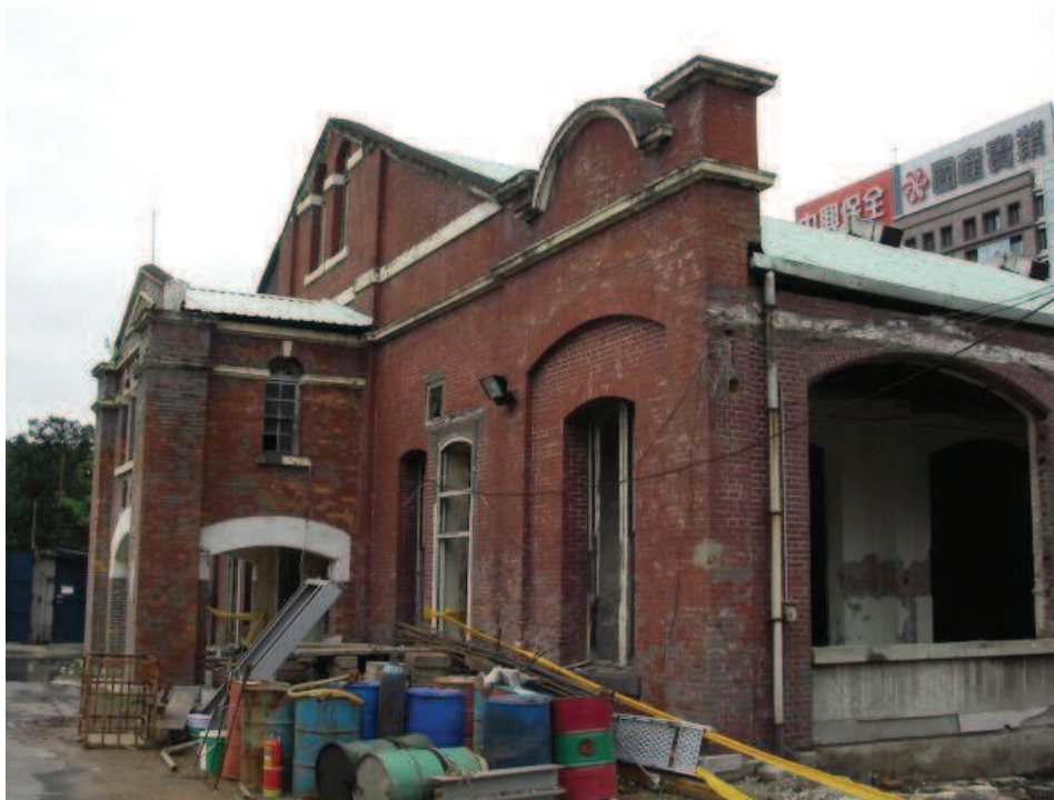
圖 2-18 鐵路局舊禮堂前身為日治時期鐵道部台北工場，該工場亦為清代劉銘傳所設置之機械局原址，目前已北台北市政府指定為市定古蹟，本研究拍攝。
