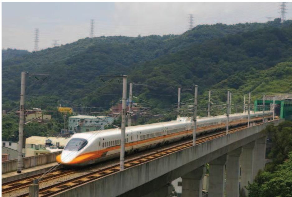
圖 2-46 台灣高鐵列車跨塔寮坑溪橋，圖中遠方龜山隧道，橋下則為台一線及台一甲線，本研究拍攝。
