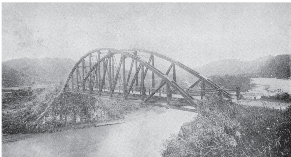
圖 2-13 清代基隆河鐵路橋（今基隆市大華橋），其橋台採用「丁順砌」。
