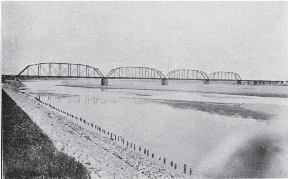
圖 2-73 1901 年（明治 34 年）6 月竣工之第二大科坎溪橋 資料來源：台灣鐵道史中卷。
