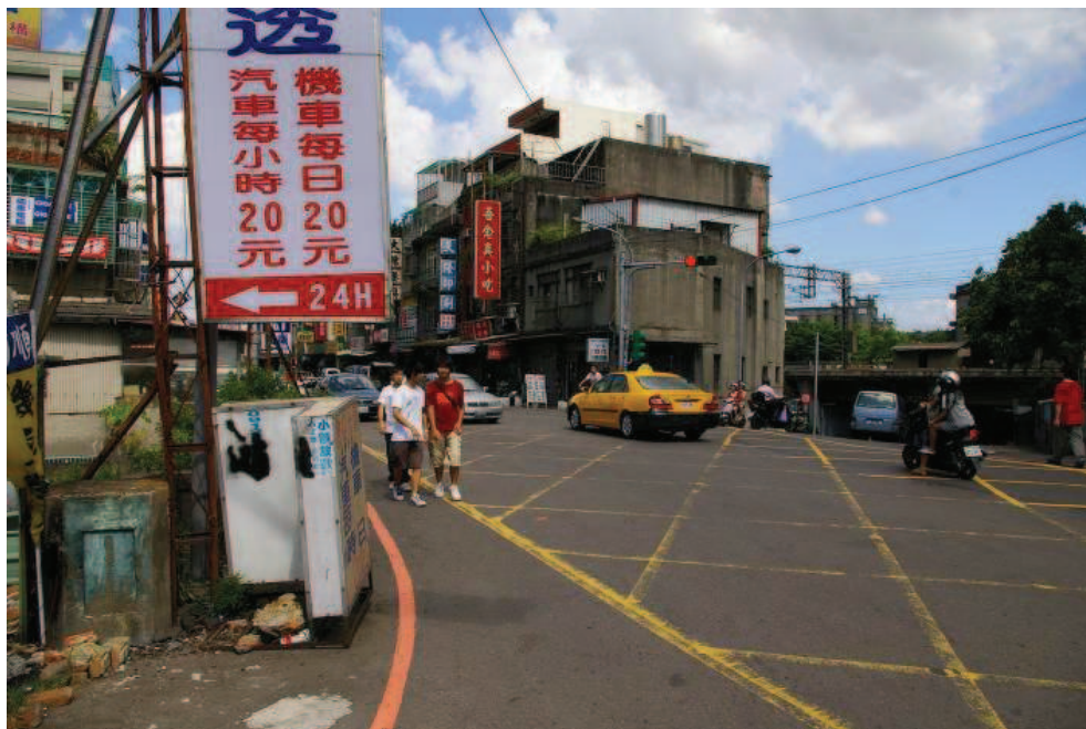
圖 2-62 清末台北至新竹段鐵路「桃仔園坑橋」遺址，於日治時期改建為一般公路橋樑並改稱為「武陵橋」，其位置緊鄰今日改線後之縱貫鐵路，本研究拍攝。
