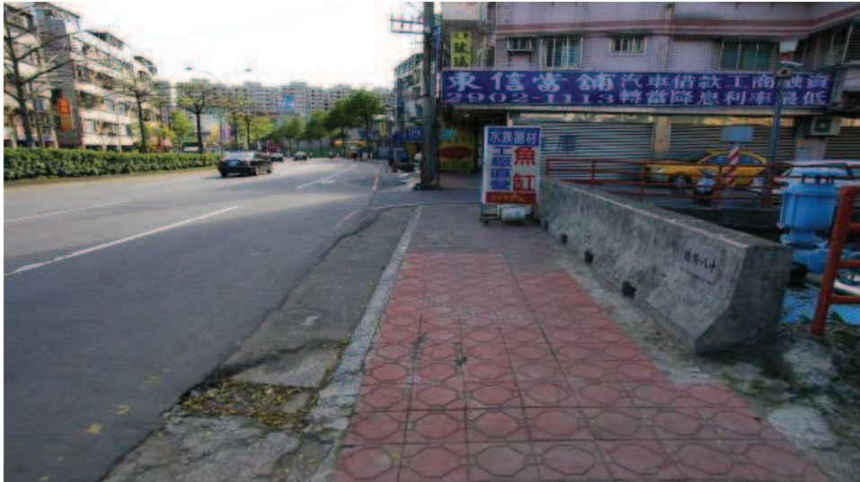
圖 2-28 清末台北至新竹段鐵路之「十八份坑一號橋」遺址（北起基隆 27 哩 33 鎖），位於新莊市中正路（台一甲線）之十八份橋，本研究拍攝。
