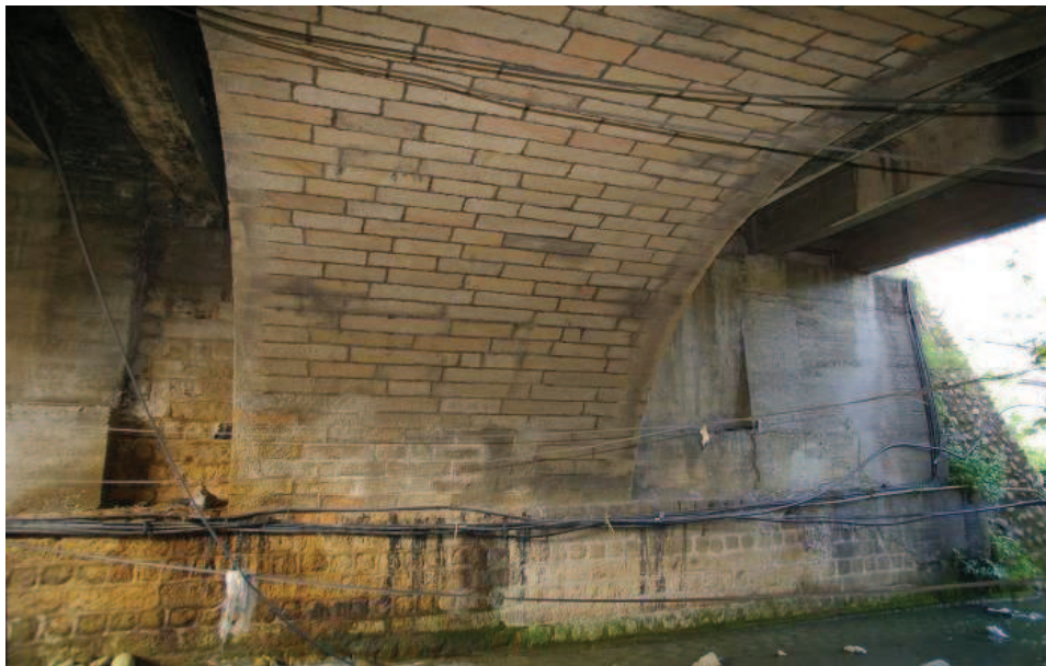
圖 2-40 清末台北至新竹段鐵路之「九芎頭坑橋」遺址橋體現況，石拱橋材質主要使用石英砂岩，此處可明顯看到該橋歷次修建之演變過程，本研究拍攝。
