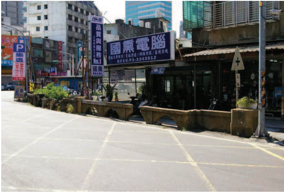
圖 2-61 清末台北至新竹段鐵路之「桃仔園坑橋」遺址（北起基隆 34 哩 73 鎖），位於桃園市萬壽路三段武陵橋，本研究拍攝。
