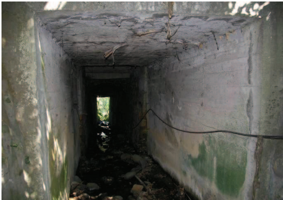
圖 2-51 龜崙嶺坑底清代鐵道橋遺構西側橋底外觀，由現場構造可看到道路歷年拓寬的過程，本研究拍攝。
