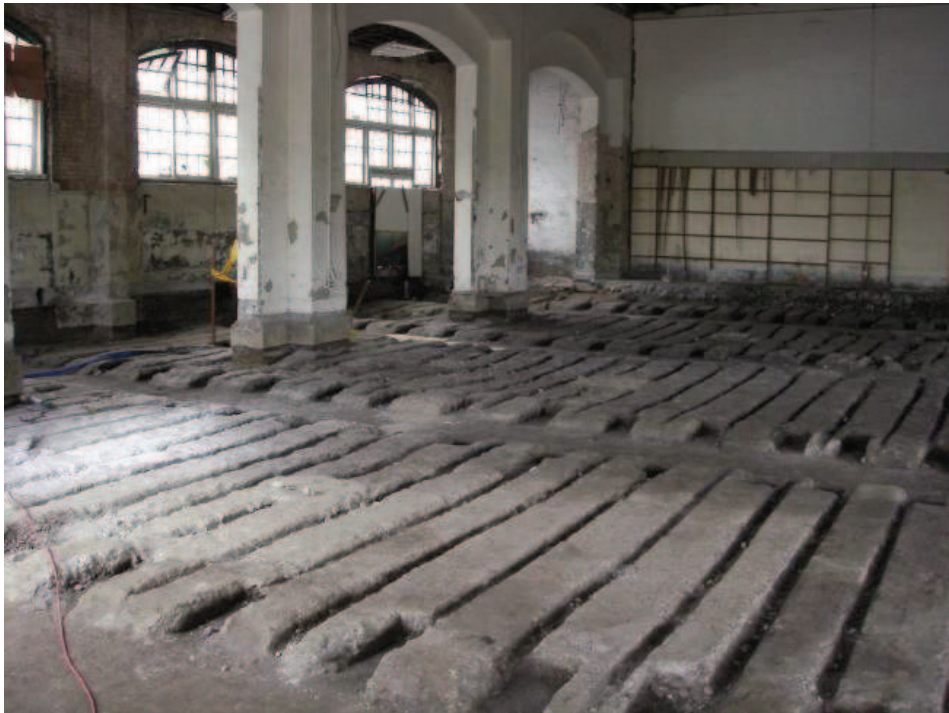
圖 2-21 鐵路局舊禮堂內部地坪，此地坪已因捷運松山線興建車站出入口而拆除，本研究拍攝。
