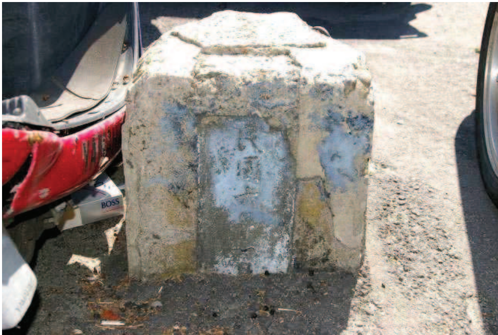
圖 2-60 「大樹林坑橋」殘跡，該橋目前已經加蓋，現況僅存欄杆橋名柱，上面提有「民國 6 年 1 月」等字樣，應為 1917 年（大正 6 年）左右改建，本研究拍攝。
