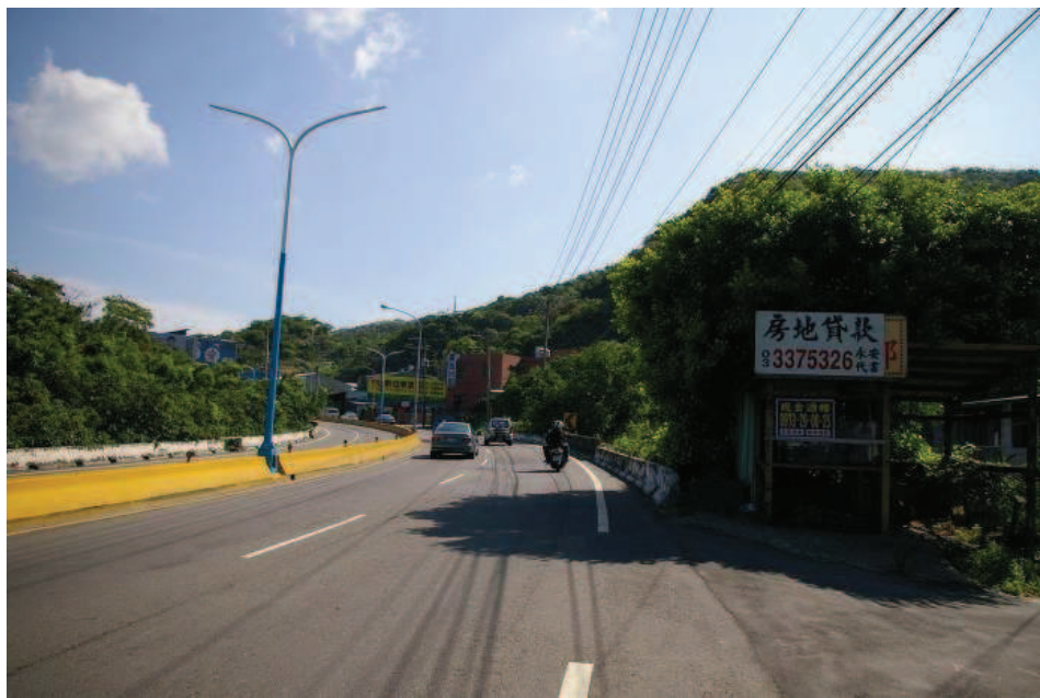
圖 2-49 龜崙嶺坑底清代鐵道橋遺構路面現況，位於龜山鄉萬壽路一段省道台一甲線 19.6 公里，本研究拍攝。
