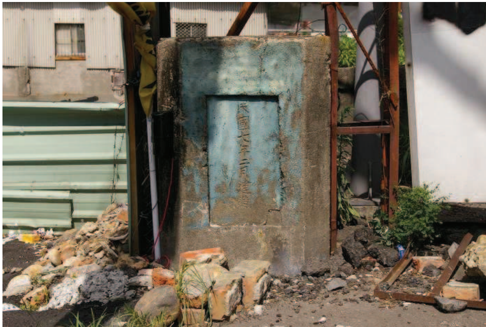
圖 2-64 日治時期「武陵橋」之欄杆橋名柱牌額題字，題有「民國七年建造」，應為大正七年間改建，本研究拍攝。
