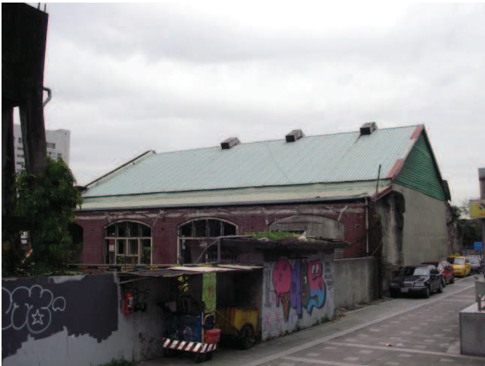
圖 2-20 鐵路局舊禮堂東側及背立面，因鄭州路拓寬及市民大道高架橋興建，建物拆除三分之一，本研究拍攝。
