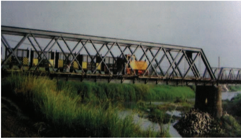
圖 2-68 台糖虎尾溪鐵橋，該鋼樑橋經考證應為日治時期利用清代鳳山崎溪鐵橋於風災後之材料所建造。
