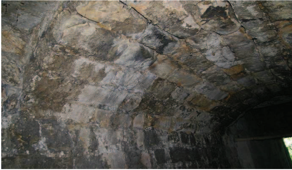
圖 2-54 龜崙嶺坑底清代鐵道橋遺構石拱橋現況，其構築方式採「縱列條石發卷」砌置，本研究拍攝。
