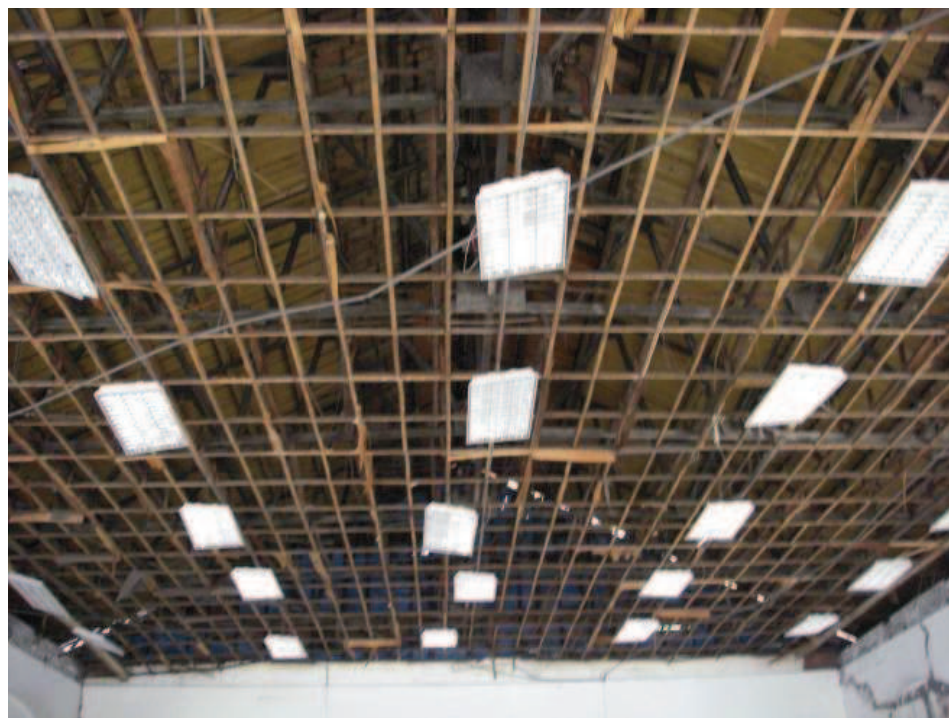
圖 2-22 鐵路局舊禮堂鋼構屋架，此屋架原為清代大稻埕台北火車票房構造，於日治後改築於此，本研究拍攝。
