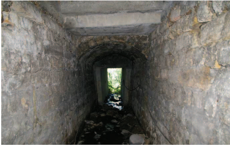
圖 2-52 龜崙嶺坑底清代鐵道橋遺構西側橋底內部，石拱橋之規模小於「第二尖山橋」及「大坑溪橋」，本研究拍攝。
