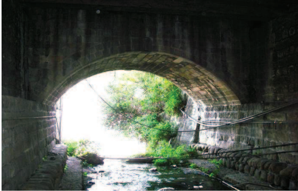
圖 2-37 清末台北至新竹段鐵路之「九芎坑橋」遺址北側橋底，圖中可看到第二尖山橋石拱橋底部石拱橋構造及兩側石砌橋台，本研究拍攝。
