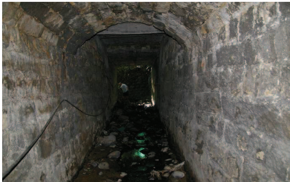
圖 2-53 龜崙嶺坑底清代鐵道橋遺構東側橋底外觀，石拱橋兩側橋台砌法為「丁順砌」，本研究拍攝。
