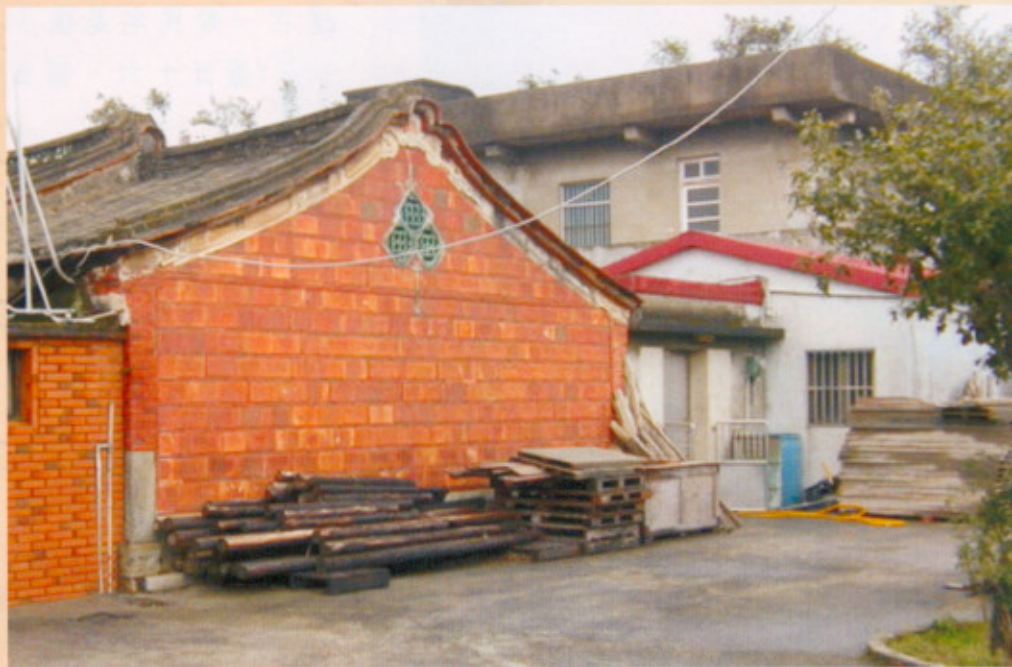
▲圖五十八：呆板生硬的建築環境
