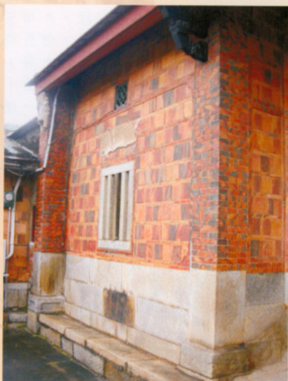
▲圖十三：斗子砌磚構造
