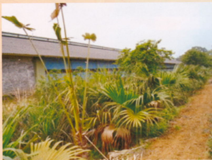
▲圖四：淹沒於樹叢中之坑道口
