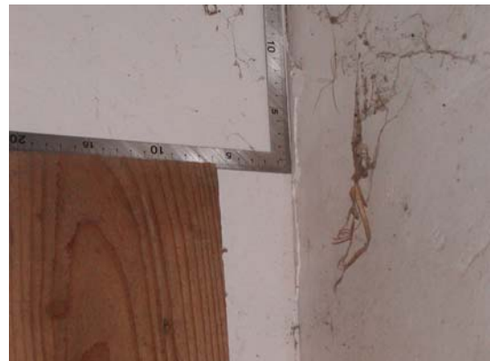
【圖 6-1-04】G3 牆面向外傾斜。
