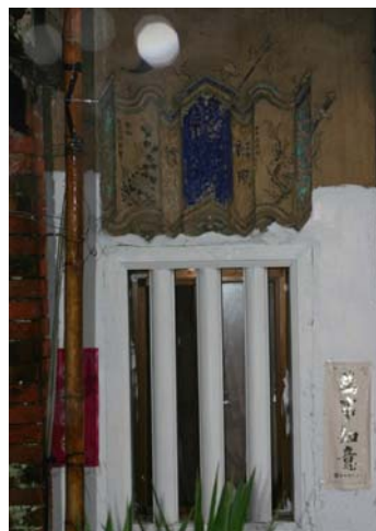
【圖 6-1-13】牆壁表面塗上水泥漆。
