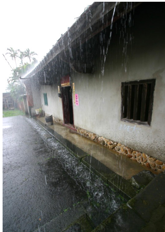
【圖 4-1- 28】下大雨時，雨水沿屋邊水溝排出。
