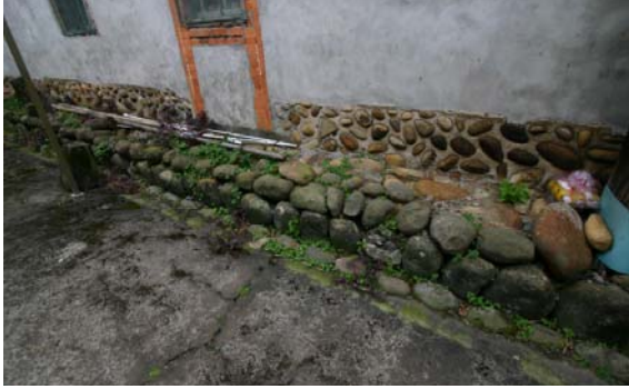
【圖 4-3- 33】右內護龍背面之卵石基礎與牆基。
