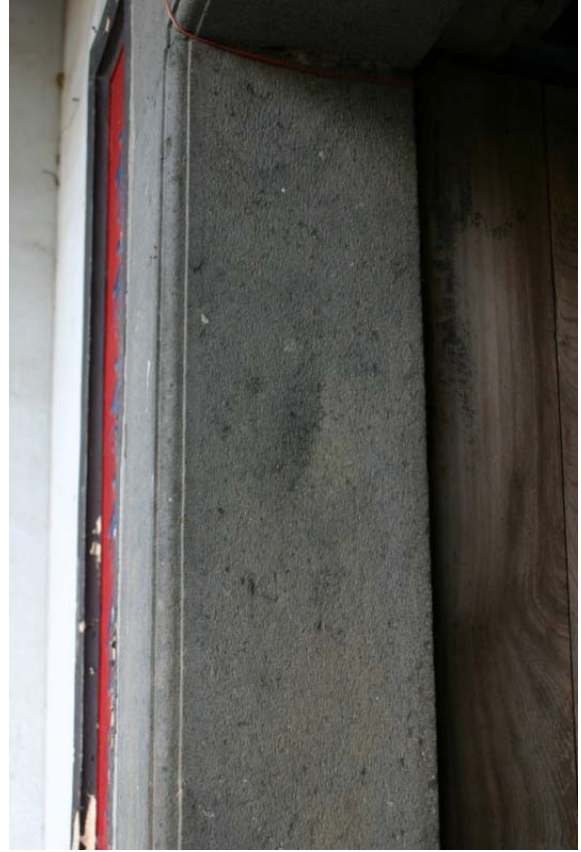
【圖 4-3- 79】第一進中門門柱上的開鑿痕跡。
