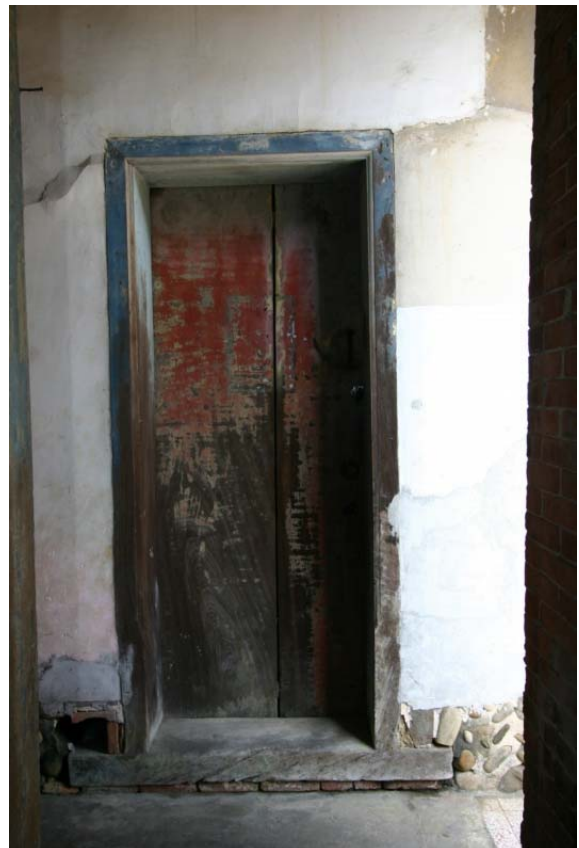
【圖 4-3- 96】第一進龍邊房門。
