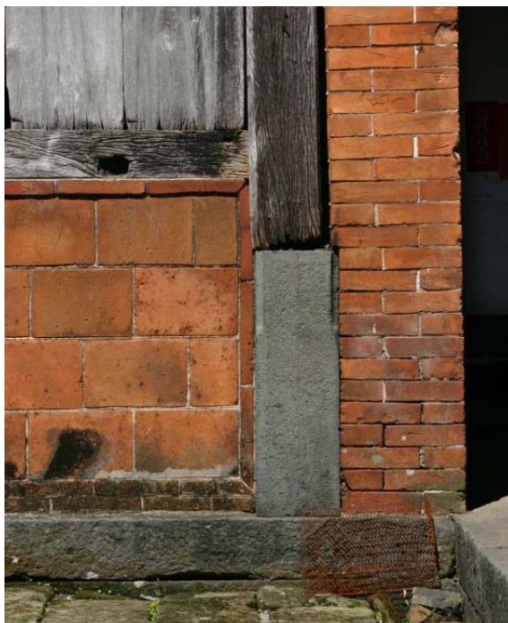
【圖 4-3- 30】南北廳正面為磚石混砌構造。
