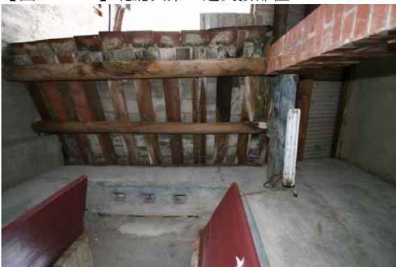
【圖 4-3- 17】第一進右過水廊屋架。
