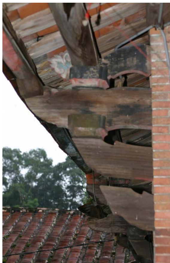
【圖 4-3- 47】第一進正面虎邊挑簷斗拱。
