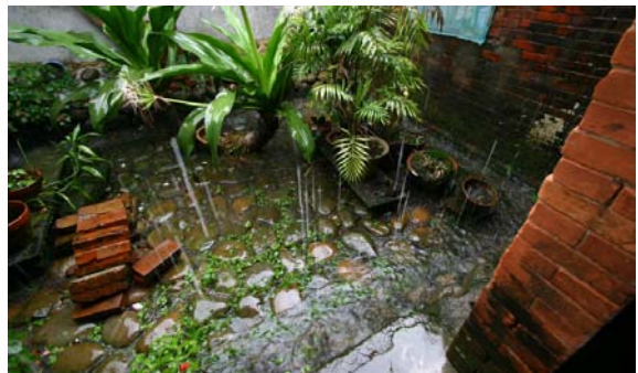
【圖 4-1- 32】右外護龍天井，下雨時僅周圍積水。
