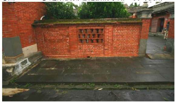
【圖 4-1- 36】新坡天水堂院牆外往右方蜿蜒之水路。
