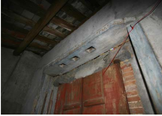
【圖 4-3- 82】第一進右內護龍過水門上方之伏兔。
