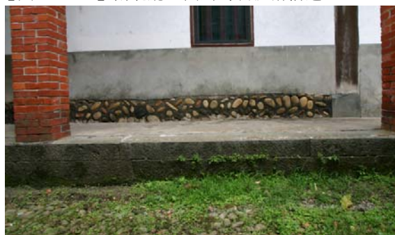
【圖 4-3- 32】右內護龍建築正面基礎使用條石砌。
