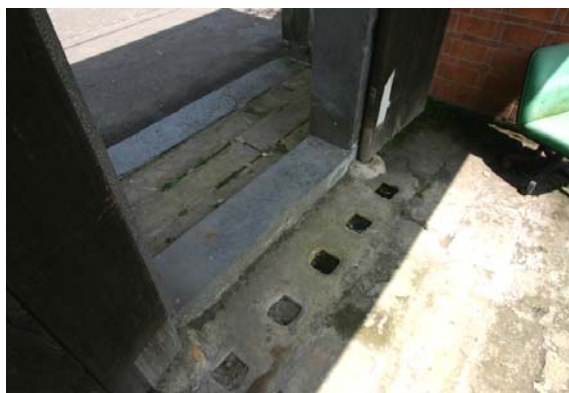
【圖 4-3- 74】門樓內側地面之伏兔。
