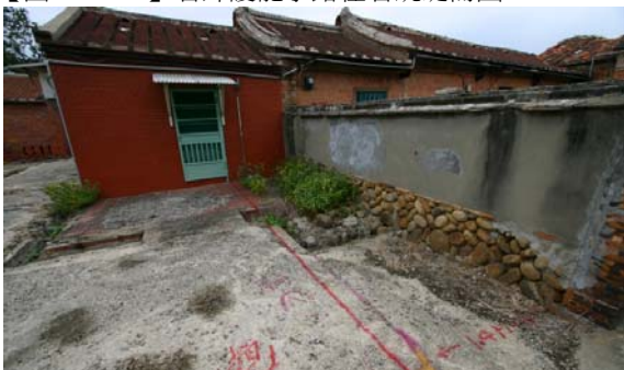
【圖 4-1-35】新屋范姜古厝院牆外往右方蜿蜒之水路。
