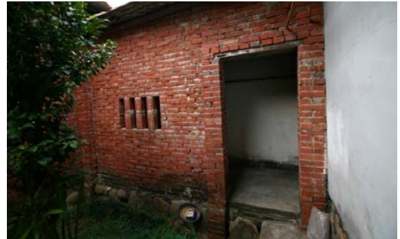
【圖 4-3- 36】左外護龍過水地面使用石板鋪砌。
