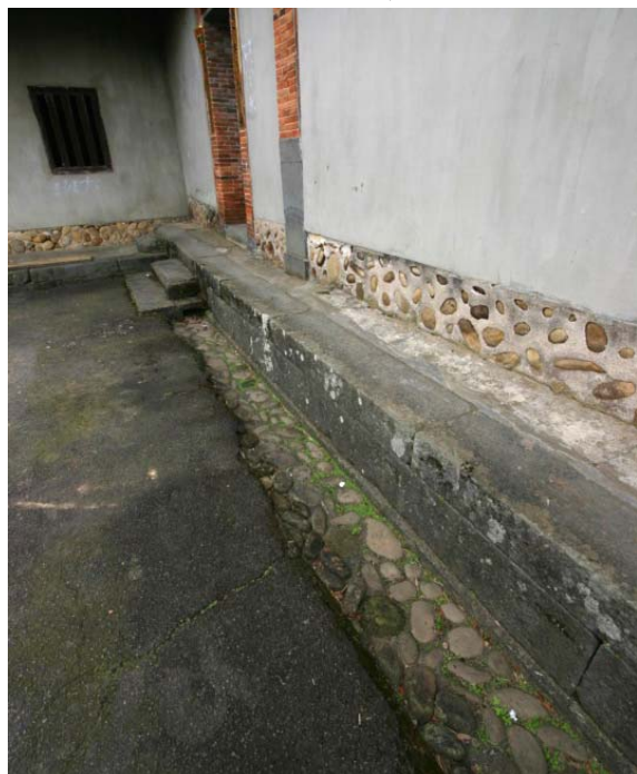
【圖 4-3- 29】主要建築台基使用石條砌，水溝用卵石。
