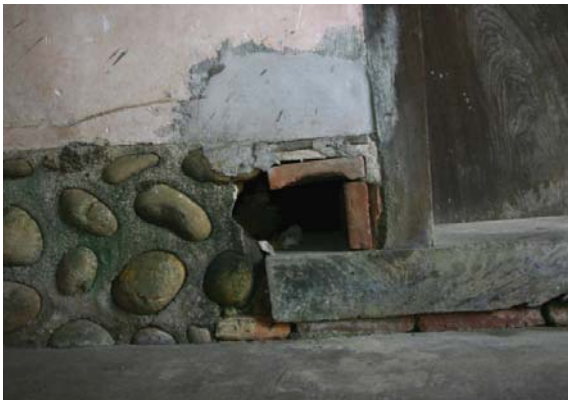
【圖 4-3- 95】第一進龍邊房門角落設貓狗洞。
