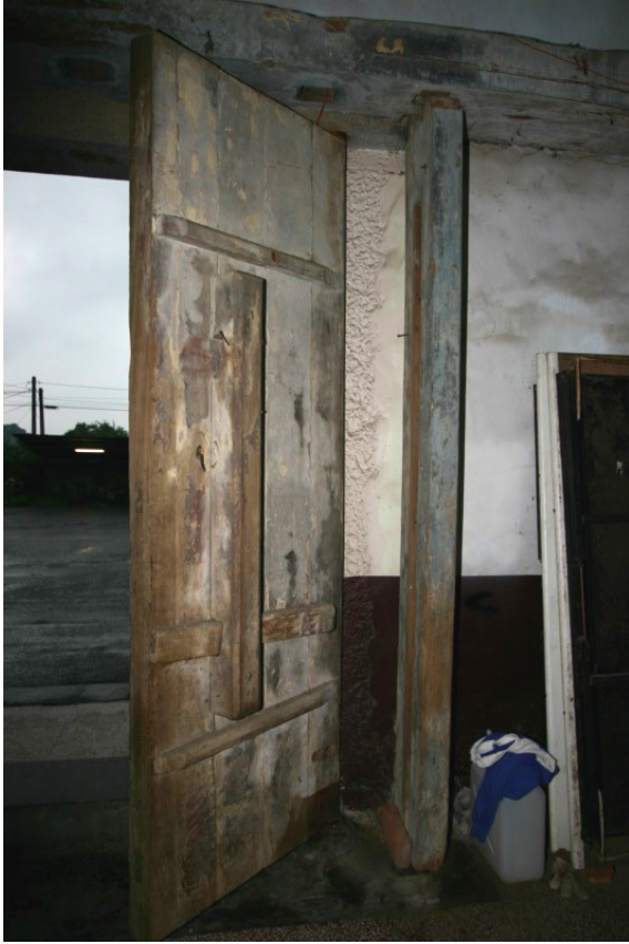
【圖 4-3- 78】第一進中門旁之立柱，作加固之用。
