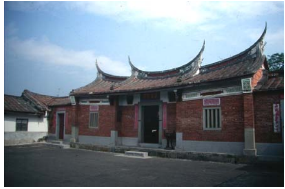
【圖 4-1- 13】新埔上枋寮劉宅面寬五開間。
