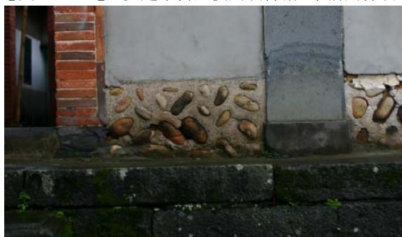
【圖 4-3- 31】第一進正面使用石柱與石柱礎。
