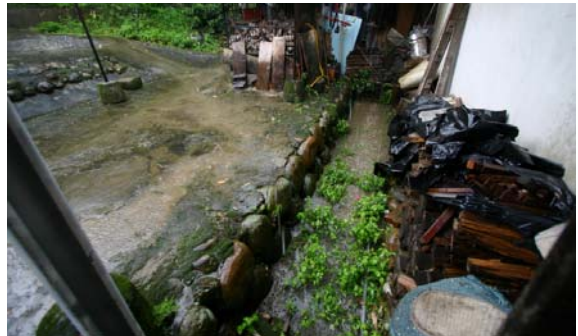
【圖 4-1- 34】建築後側之化胎溝水路，仍可使用。
