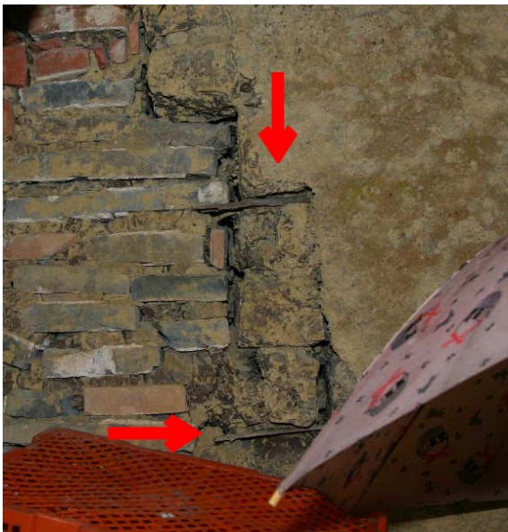
【圖 4-3- 42】從破損處可看出土塙牆上有疑似竹片物體（箭頭指向處）。
