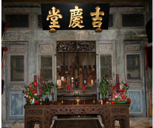
【圖 4-4- 17】上堂神龕面全景，共有六扇格扇門。
