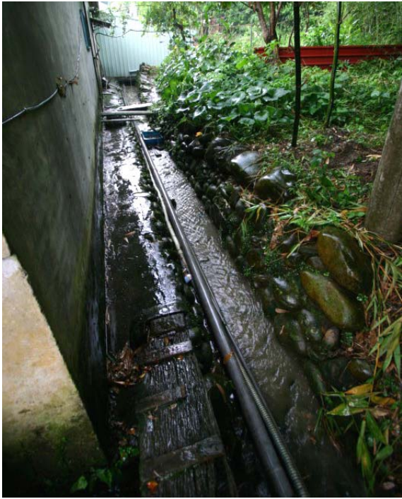
【圖 4-1- 29】房屋左側之介水路仍保存完整。
