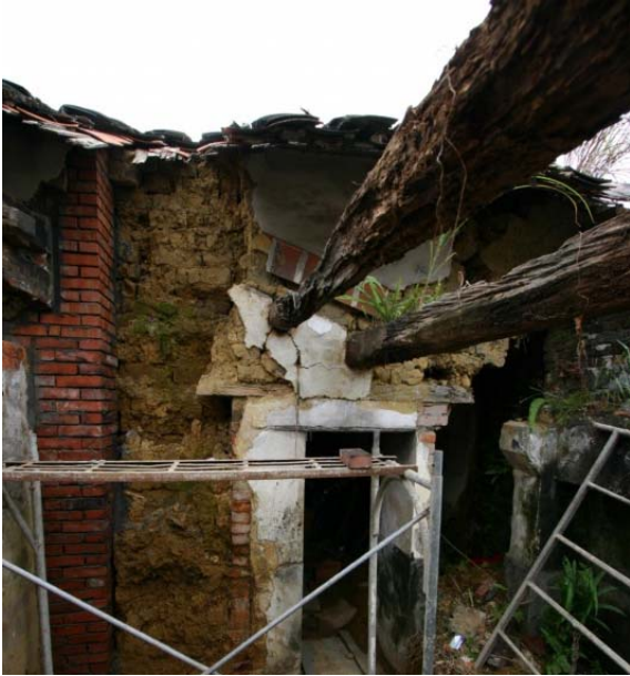
【圖 4-3-07】右外護龍外側過水廊屋架。
