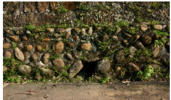
【圖 4-3- 39】外圍牆基開小洞。
