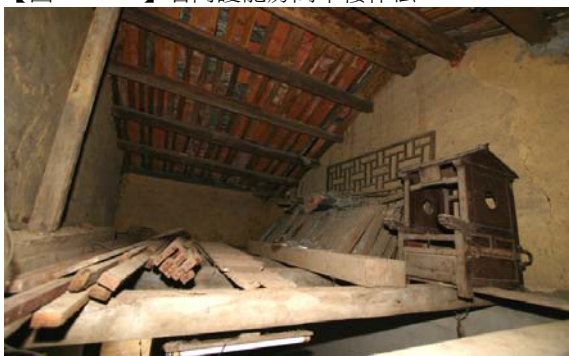
【圖 4-3- 25】右內護龍房間半樓及屋架。
