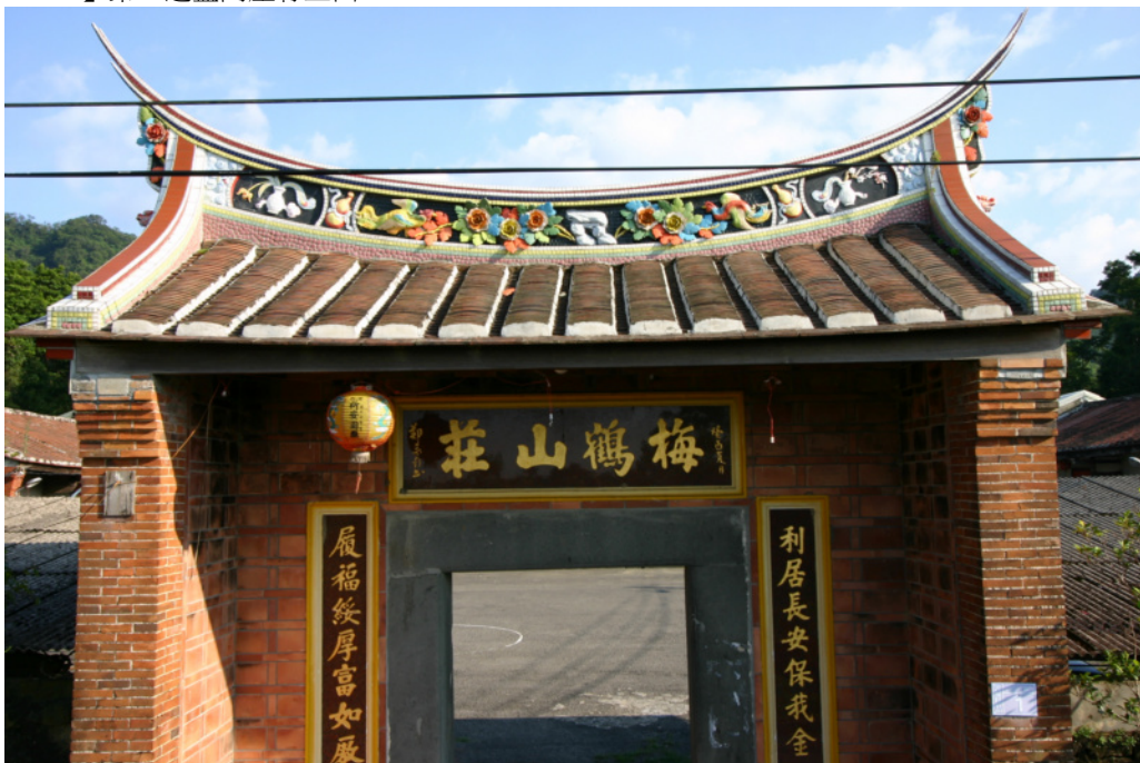
【圖 4-4- 35】門樓之屋脊近年整修過，已非原貌。
