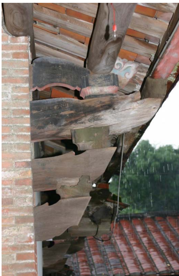
【圖 4-3- 46】第一進正面龍邊挑簷斗拱。
