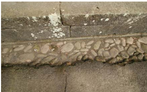
【圖 4-3- 107】第一進正面水溝。
