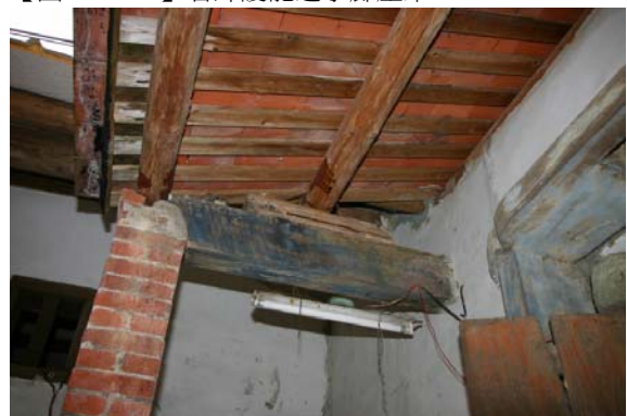
【圖 4-3- 18】第一進左過水廊屋架。
