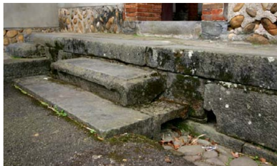
【圖 4-3- 28】第一進右過水門前的石階。
