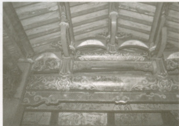
正殿與廂房間之過水廊棟架。
