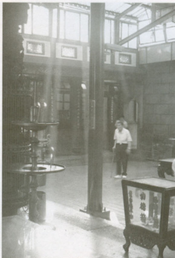
三川及正殿之間設有採光頂棚。
