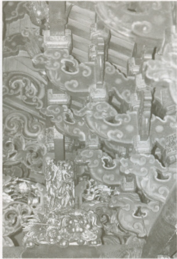
三川架內後排樓面出跳斗拱為螭虎造型。
