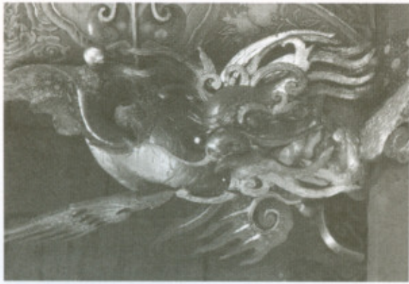
正殿架内棟架上之鯨魚插角。
