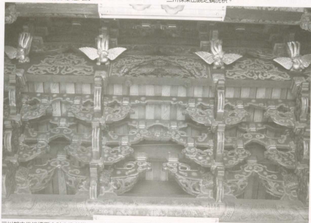
三川架内後排樓面之計心造斗拱。
