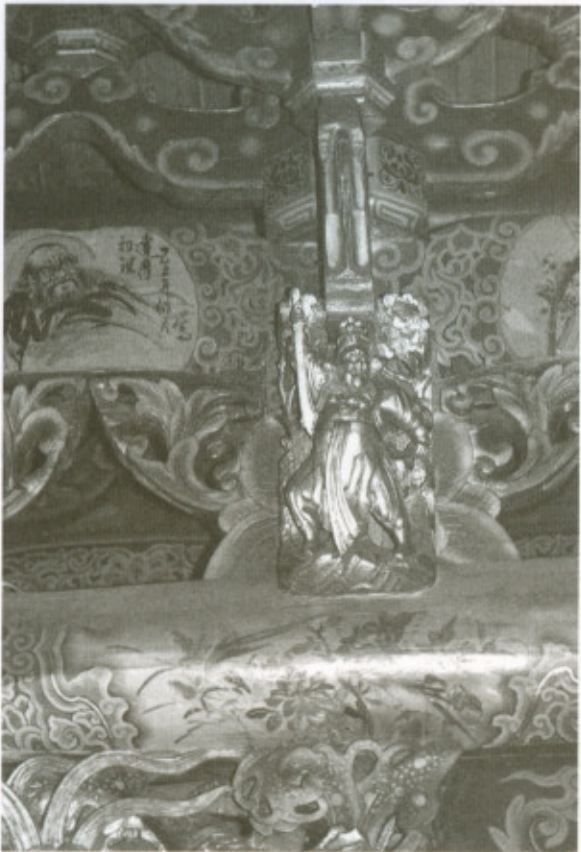
三川排樓面通樑上使用斗座。
