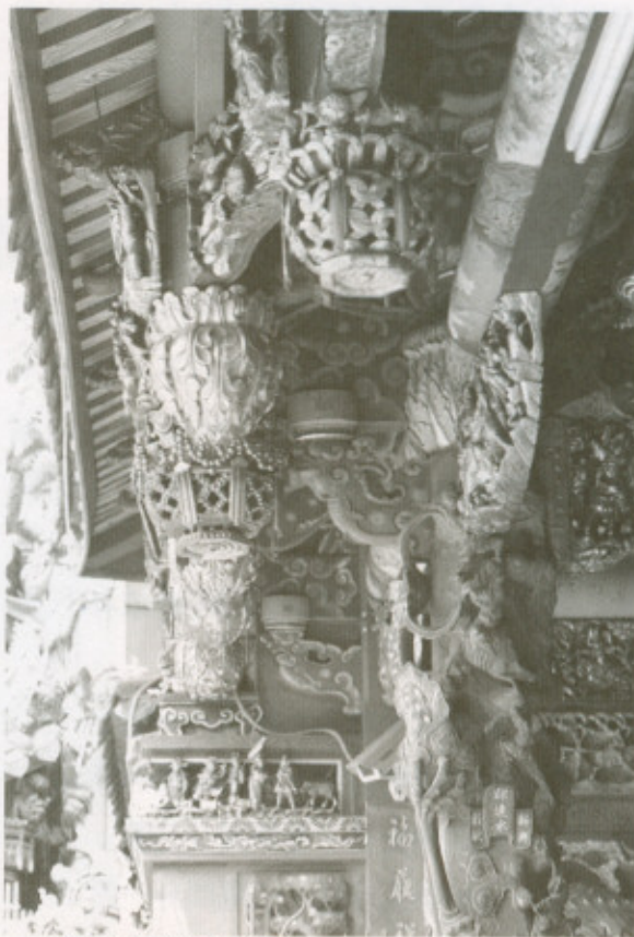
三川正面外寮之吊筒構造。
