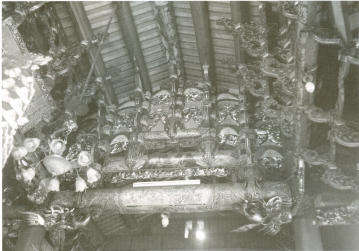
正殿架內棟架為三通五瓜式，通樑用料碩大。
