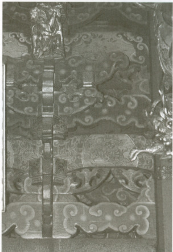
三川架内前排樓面之排樓斗拱。
