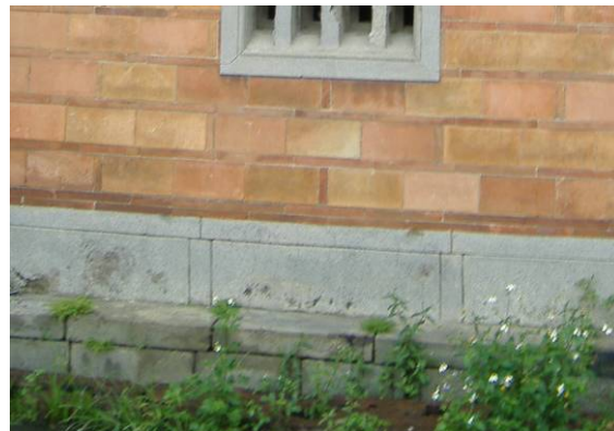
照片 3-16 外牆台度作洗石子
