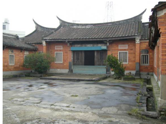
照片 3-4 層層疊落的屋面
