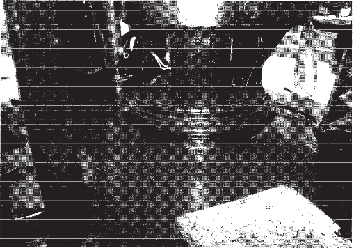
燈具之底座浮在水銀槽上，供固定透鏡及燈具設備。
