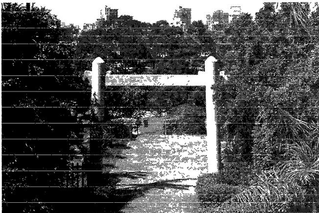
鳥居為鋼筋混凝土，表面洗石子。
