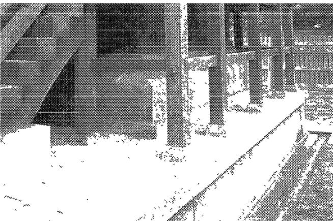
本殿基壇混凝土結構，表面洗石子，水泥本色。
