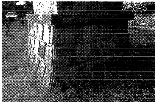
大型石燈籠基座為混凝土，表面仿石材處理。
